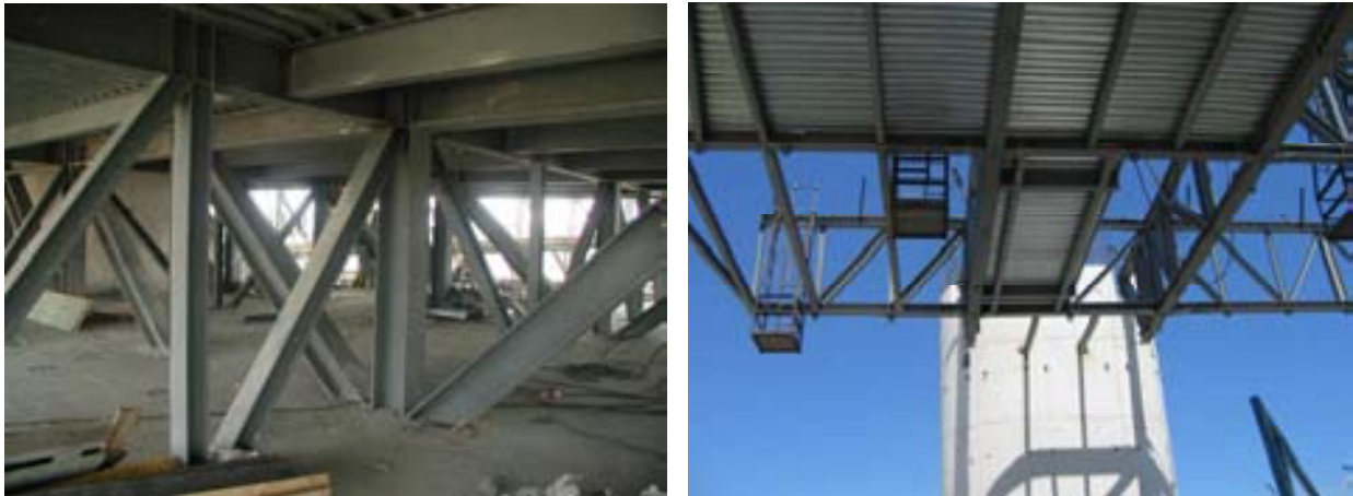
Figura 10 – Vistas de las celosías principales y de las secundarias en voladizo desde éstas: montaje de la estructura metálica y aspecto final tras la construcción de las losas superior e inferior
