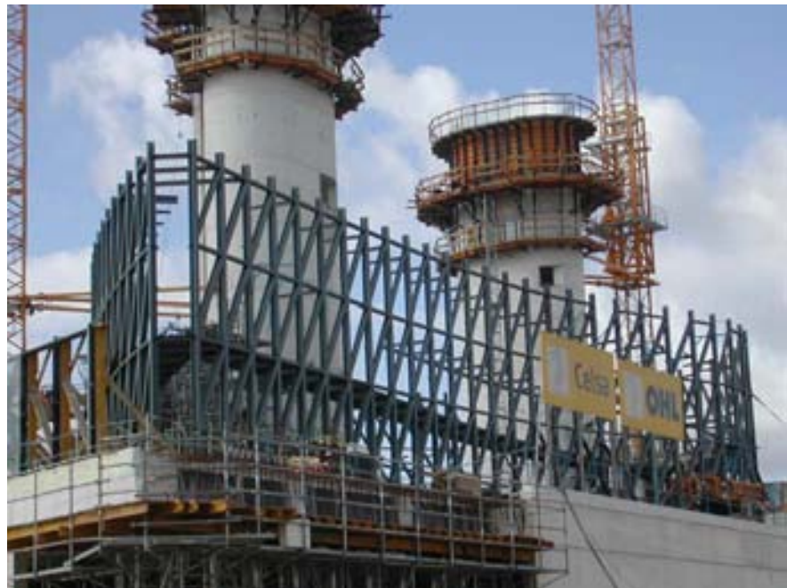
Figura 5 – Esquema en planta con los principales elementos estructurales de la Torre y vistas exteriores e interiores de la fachada y los núcleos durante la construcción, incluyendo las losas de conexión entre ambos
