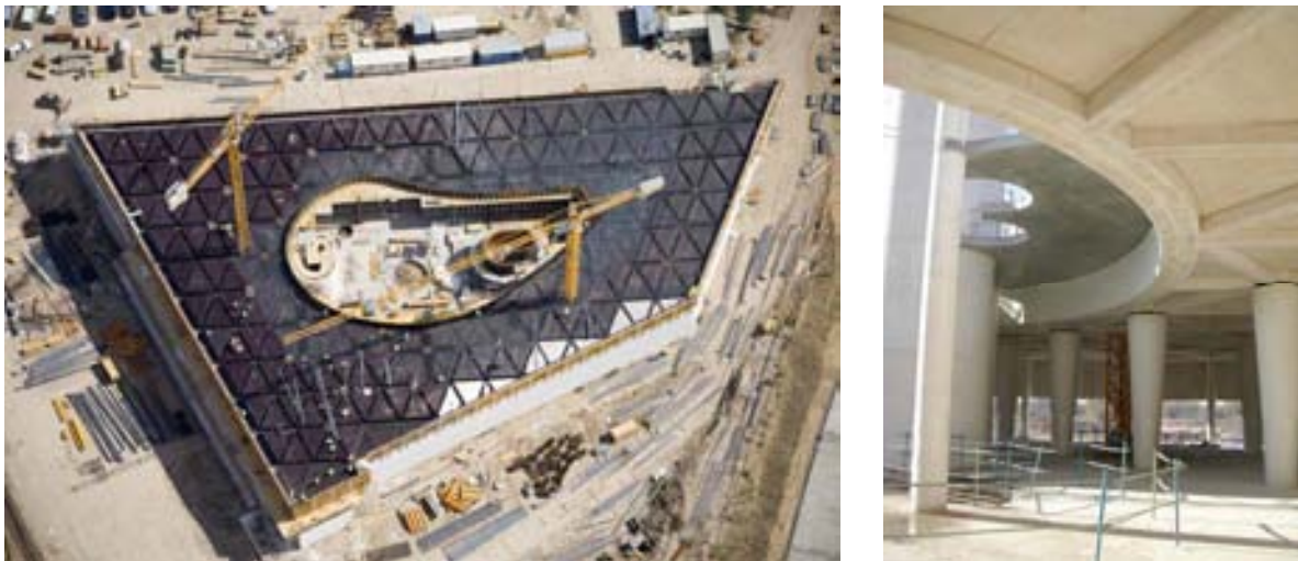
Figura 4 – Vista aérea general del forjado durante su ejecución y detalle de los soportes y el remate del óculo
