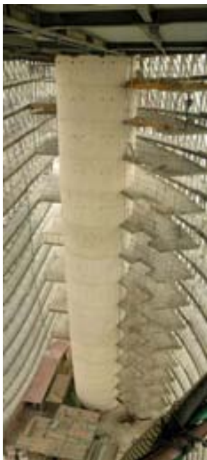
Figura 5 – Esquema en planta con los principales elementos estructurales de la Torre y vistas exteriores e interiores de la fachada y los núcleos durante la construcción, incluyendo las losas de conexión entre ambos
