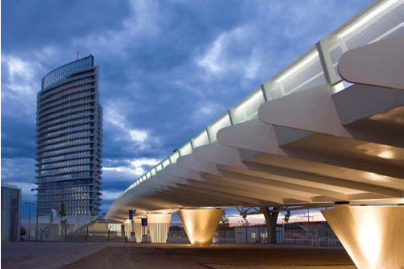
Figura 13 – Imagen general de la Torre y la pasarela de acceso a la misma sobre el vial de ronda (foto Arcelor Mittal – A. Sagasti)
