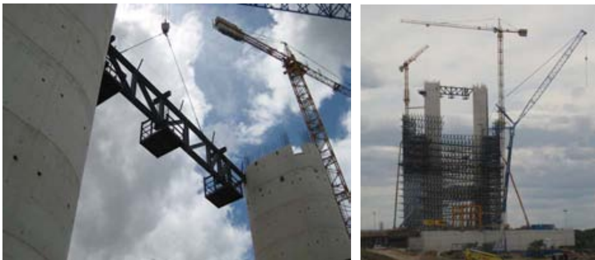
Figura 12 – Diferentes vistas durante la construcción de la torre, incluyendo las grúas y plataformas empleadas para el montaje de la fachada y las plataformas intermedias, y los encofrados trepantes de los núcleos
