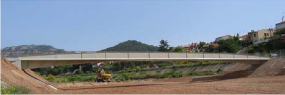
Fig.13 Pasarela de Matadepera.
