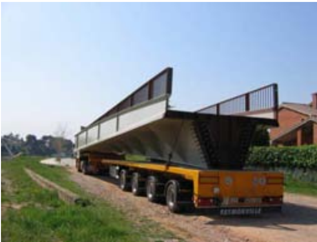
Fig.16. Tramo lateral del puente.
