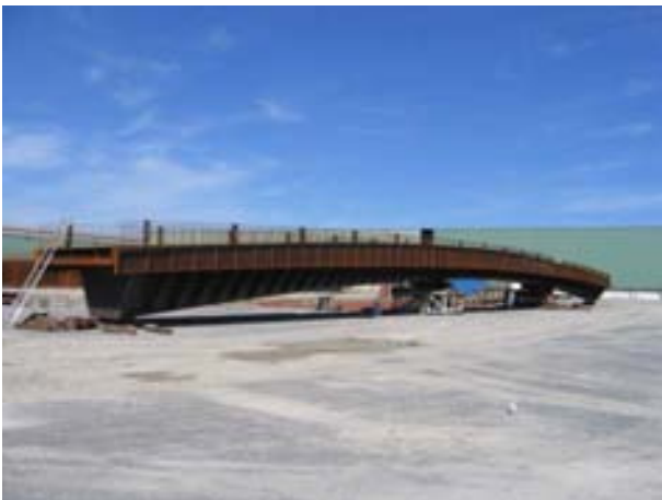
Fig. 11. Montaje en blanco de la pasarela.
