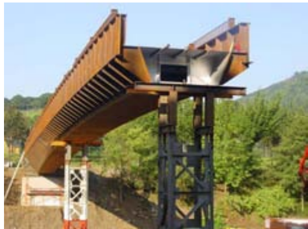
Fig. 12. Montaje de dos tramos de la viga metálica.
