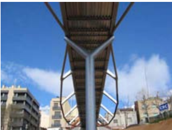
Fig.7. Vista de la pila n° 2
