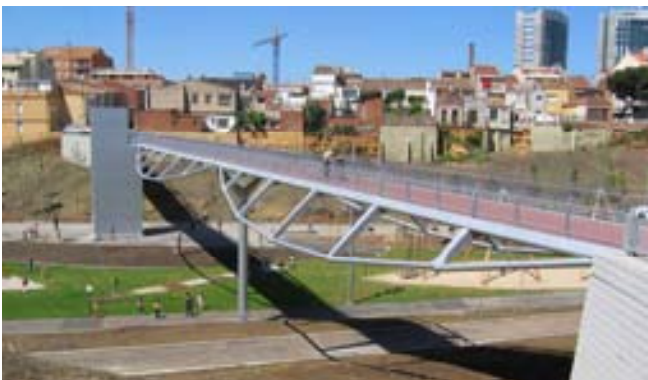
Fig.6 Pasarela de Valparadís.
