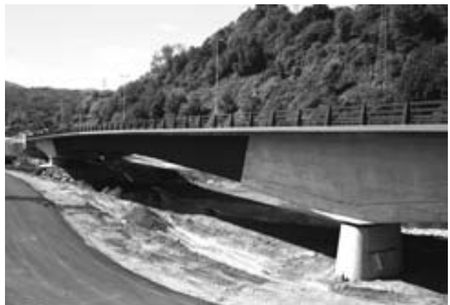
Figura 29. Vista lateral de los dos viaductos concluidos.
