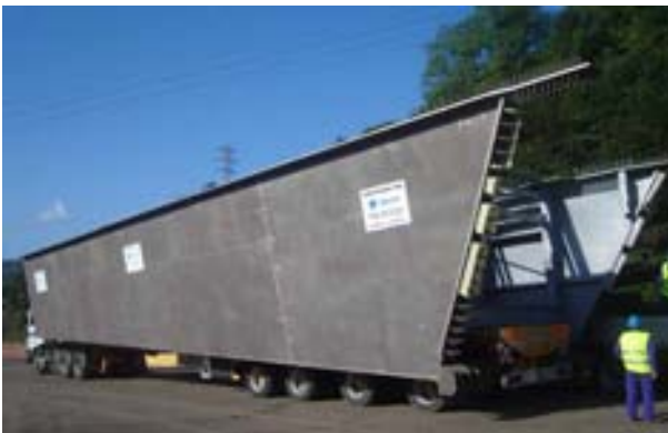
Fig. 8: Transporte del primer tramo metálico.
