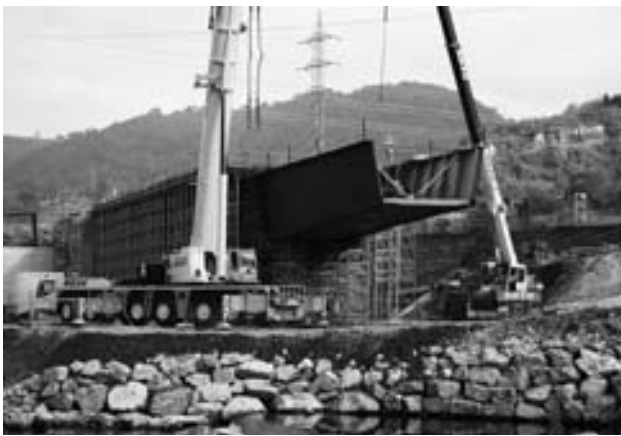
Figura 17. Vista del voladizo pretensado y desapeado.
