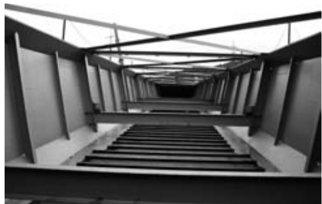
Figura 22. Vista interior del centro de vano.
