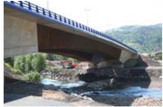
Fig. 14: Vistas de los viaductos concluidos.
