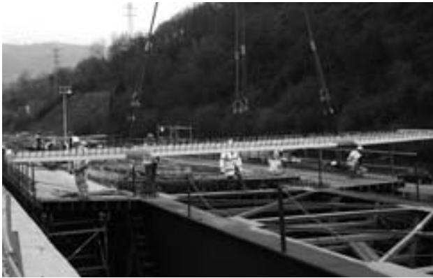
Figura 23. Colocación de prelosas prefabricadas.
