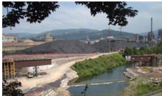
Fig. 9: Vista de los 2 tramos laterales apeados.
