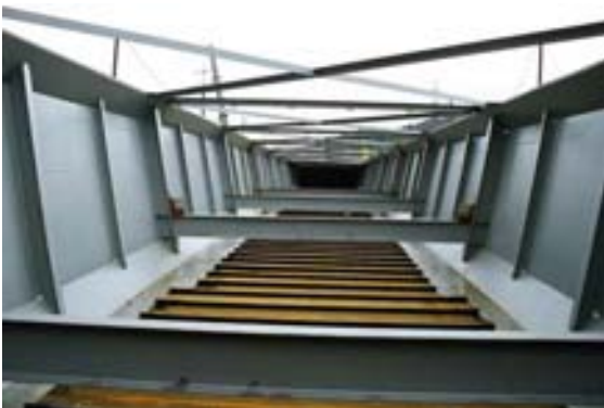
Fig. 11: Vista interior del centro de vano.
