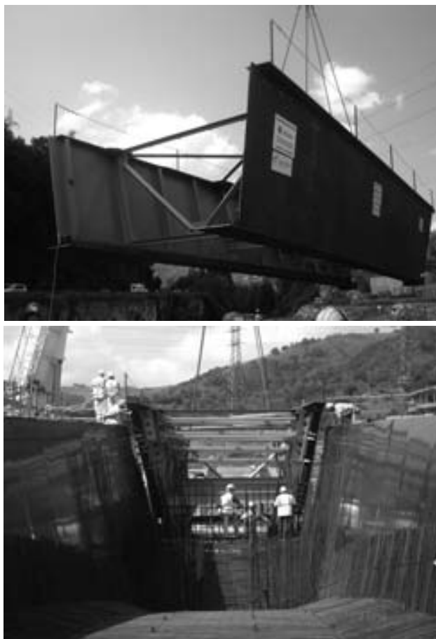
Figuras 14a y 14b. Izado y colocación del primer tramo metálico.
