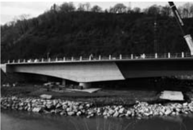
Figura 5. Vista de uno de los vanos laterales de hormigón con 27,5 m de luz.
