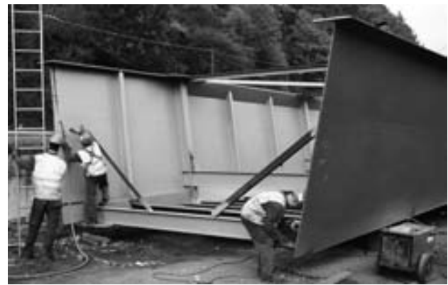
Figura 20. Corte de demasías en el tramo central.
