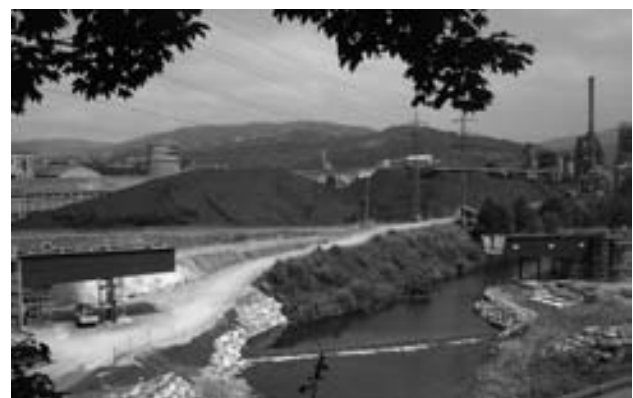
Figura 15. Vista de los 2 tramos laterales metálicos apeados.
