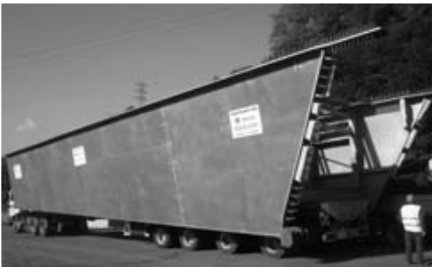
Figura 13. Transporte del primer tramo metálico.
