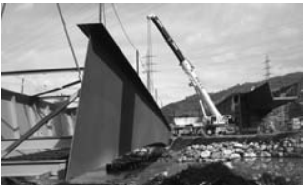
Figura 19. Izado del tramo central metálico.
