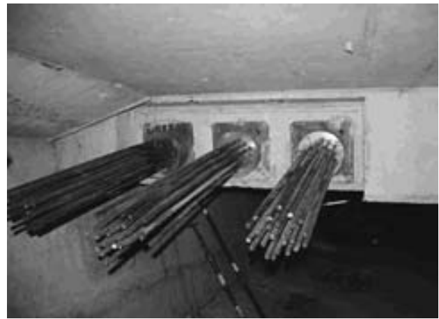
Figura 7. Vista de anclajes de pretensado en cuñas
