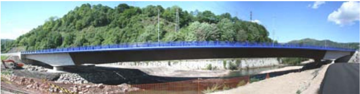
Figs. 1a y 1b: Alzado y vista del Puente sobre el Río Nalón concluido.
