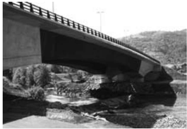
Figura 28. Vista inferior de los dos viaductos concluidos.
