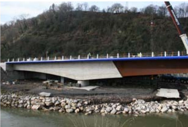
Fig. 4: Vista de uno de los vanos laterales de hormigón con 27.5 m de luz.
