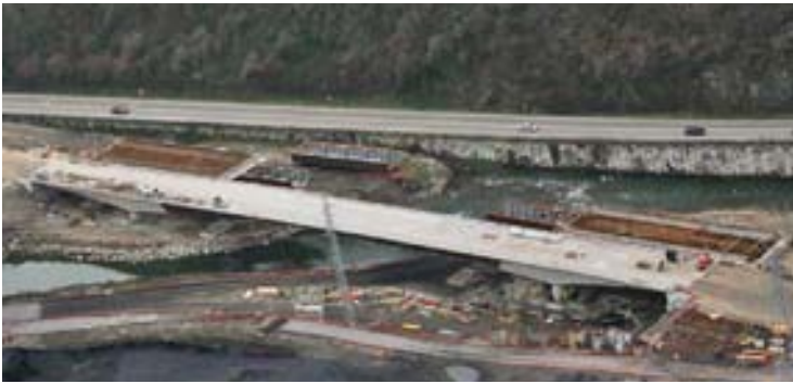
Fig. 13: Vista del segundo en fase de ejecución.
