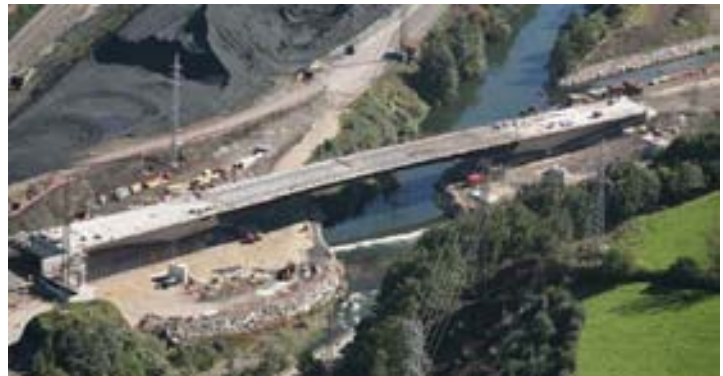
Fig. 12: Vista del primer puente con las prelasas colocadas.
