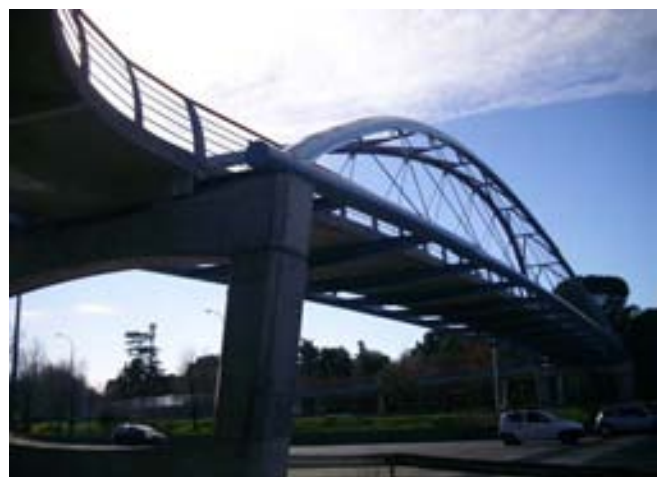
Fig.16 Pasarela sobre la N-VI. Vista inferior
