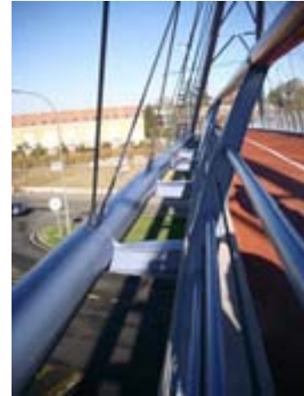
Fig.14 Pasarela sobre la N-II. Detalle lateral
