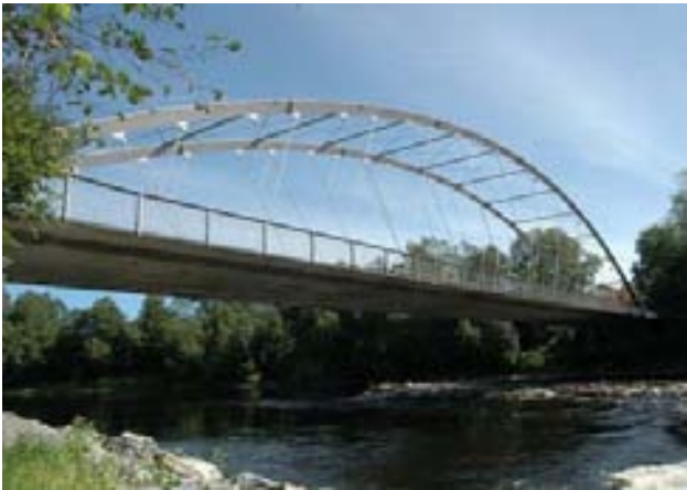
Fig. 1 Puente de Steinkjer (1963)
