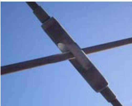
Fig. 19 Pasarela N-II (80 m). Dispositivo de cruce de péndolas
