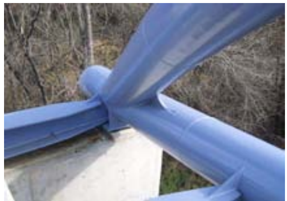
Fig. 20 Pasarela N-VI (60 m). Arranque de arco
