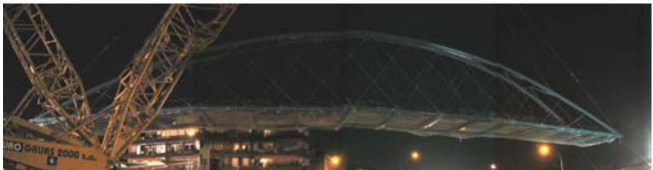
Fig 24 Pasarela sobre la N-II (80 m). Izado
