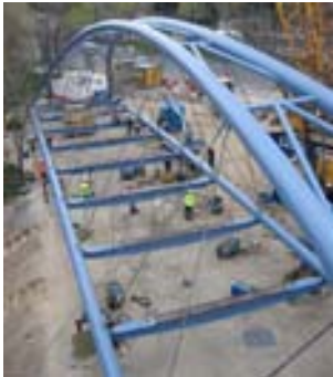
Figs 21, 22 y 23 Pasarela M-500 (52 m) y rampas de acceso. Trabajos metálicos in situ
