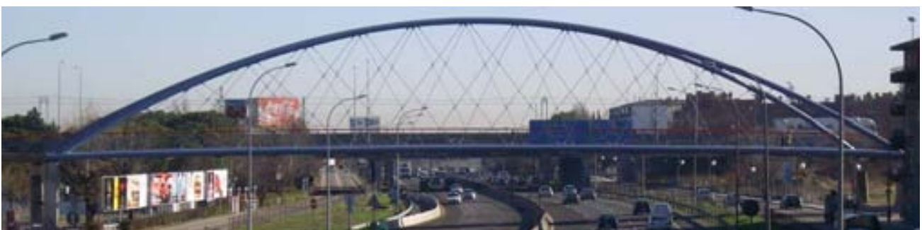
Fig.12 Pasarela sobre la N-II (network, 80 m). Vista frontal (2007)
