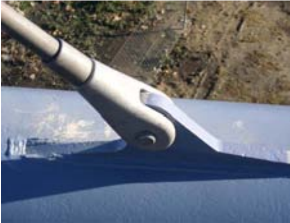
Fig.13 Pasarela sobre la N-II (80 m).Detalle de anclaje de péndola
