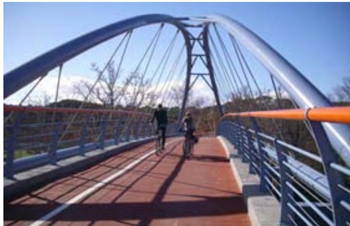
Fig.10 Pasarela sobre la M-500 (52 m). Vista transversal (2007)
