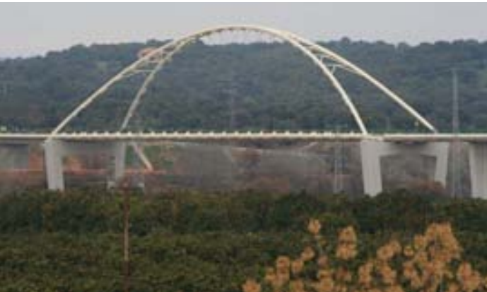
Fig.8 Puente de Palma del Río. Vista frontal (2008)
