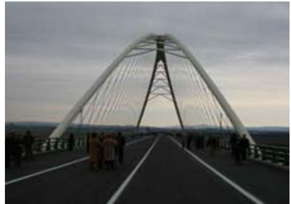
Fig.9 Puente de Palma del Río. Vista transversal (2008)
