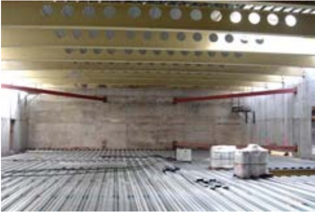
Fig. 11. Estructura mixta niveles superiores. Ejecución y galería de exposiciones terminada.
