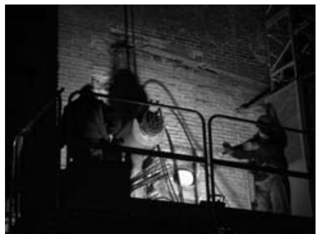
Figura 28. Ejecución del tesado del muro perimetral.
