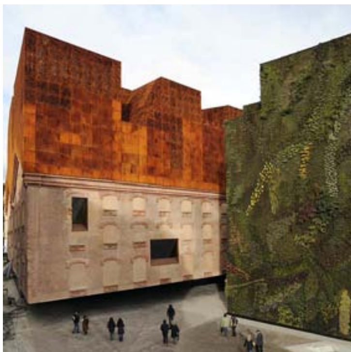
Fig. 1. Vista del edificio terminado. (Fundación la Caixa).
