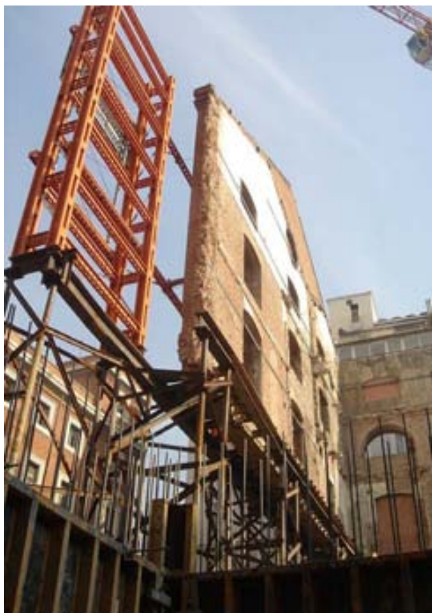
Fig. 4. Sistema provisional de estabilización y apeo de la fachada existente.
