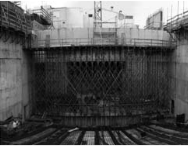
Figura 3. Ejecución de la losa de platea y los muros.
