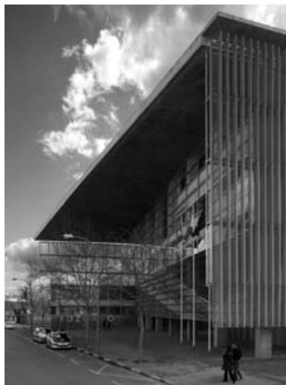
Figura 13. Vista lateral del voladizo de cubierta.
