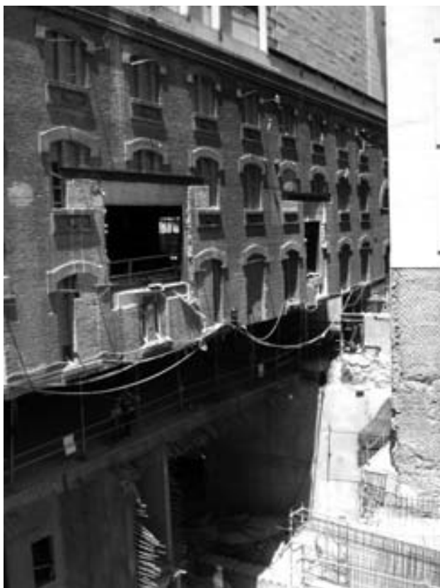
Figura 25. Muro perimetral postesado una vez desapareado.
