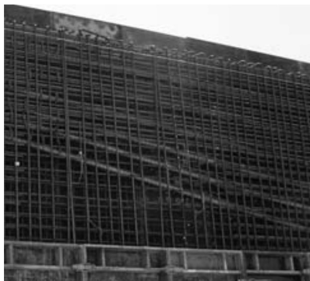
Figura 9. Vainas y armadura del muro lateral.
