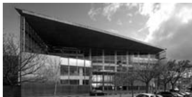
Figura 10. Nuevo edificio de Juzgados de Ciudad Real.
