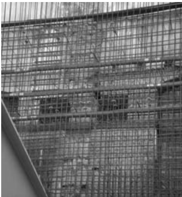
Figura 27. Colocación de las vainas de postesado en el muro perimetral.
