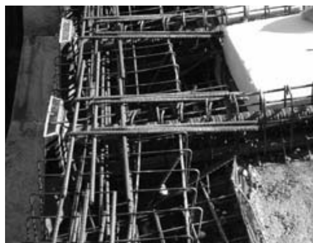
Figura 6. Detalle del anclaje pasivo.
