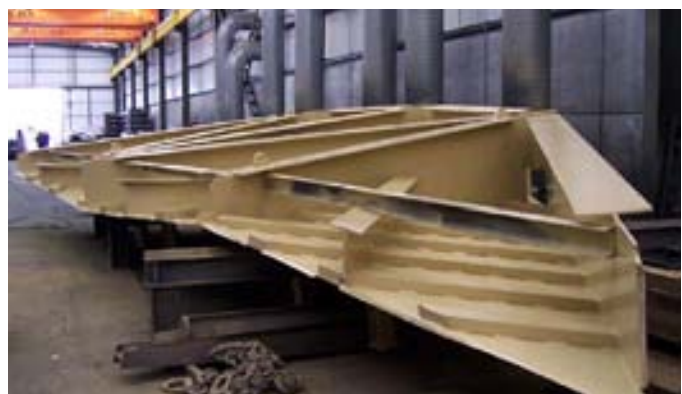
Fig. 13. Estructura mixta nivel 1. Módulo tipo: elementos principales y ejecución en taller.
