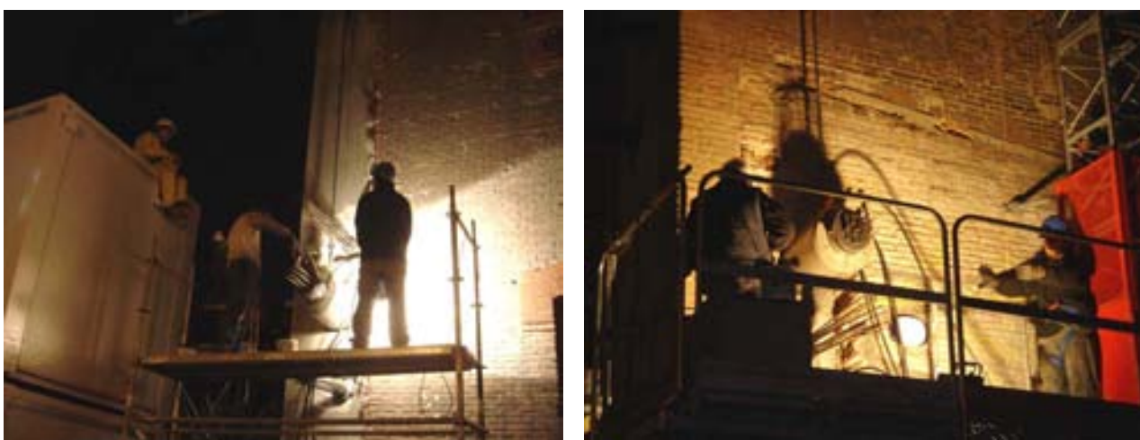
Fig. 10. Ejecución de tesado del muro perimetral.
