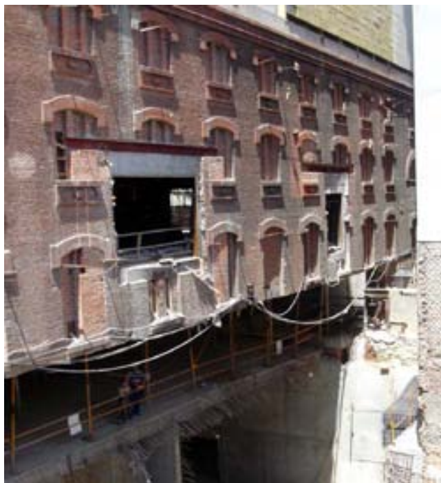
Fig. 9. Muro perimetral postesado, una vez desapeado.
