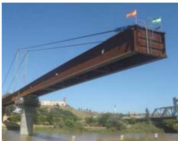
Fig. 15 Vista de la ménsula entre la pila 8 y la pila 9, sobre el cauce del río.
