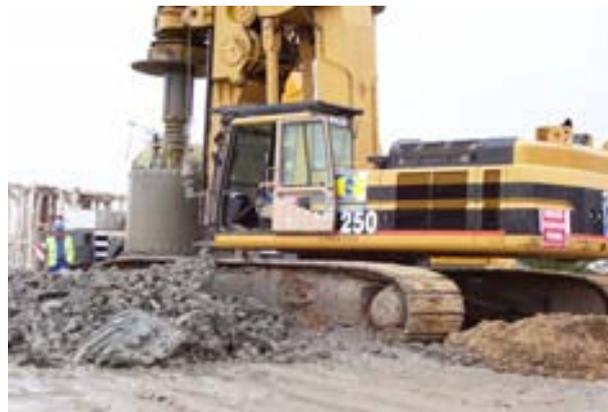
*Fig. 10 Pilotera perforando*
