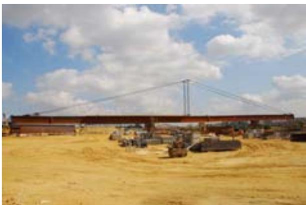
Fig. 14 Disposición general del empuje
