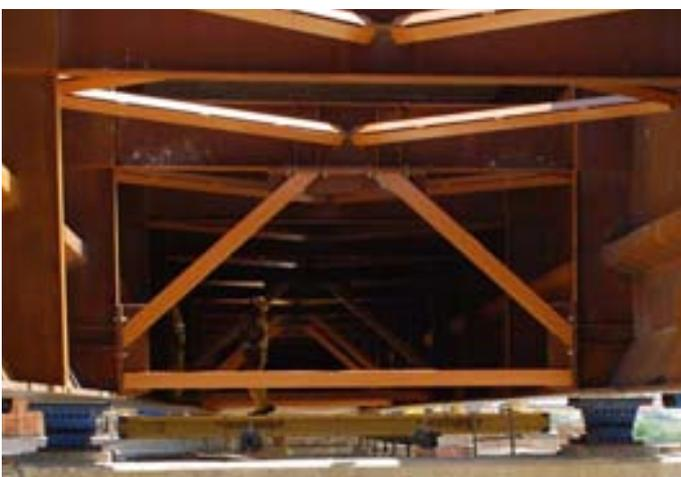
Fig. 5 Pieza delta para arriostramiento en apoyos frente a viento transversal durante el proceso de lanzamiento.
