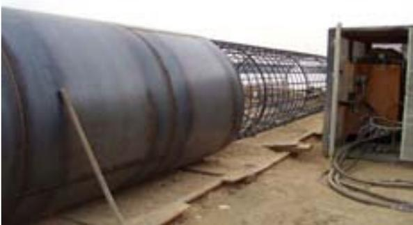
*Fig. 9 Camisa perdida con armadura colocada interiormente*
