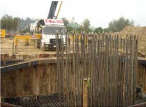
Fig. 11 Esperas con empalme mecánico 40-32
