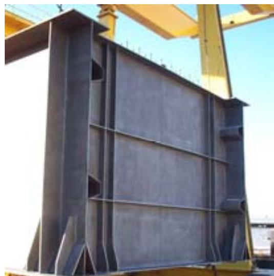
Fig. 6 Diafragma de pila extrema.
