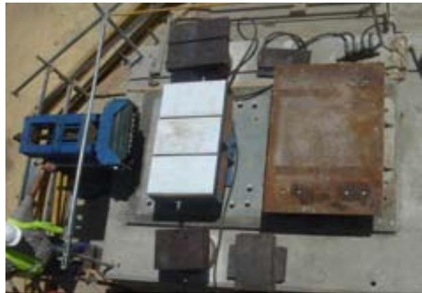
Fig. 12 Instalación de apoyos y guías en pilas.
