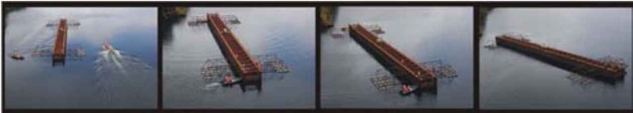
Fig.4 Flotación del cajón metálico
