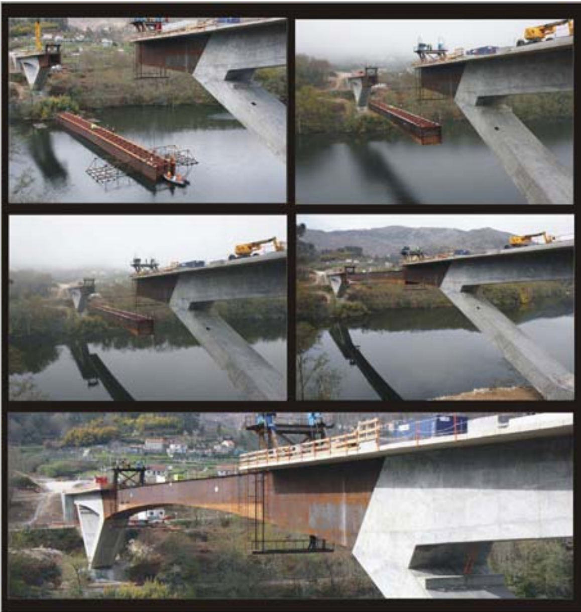
Fig.5 Izado del cajón metálico
