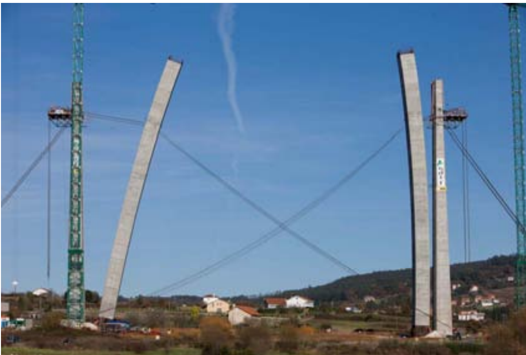
Fig. 8 Cables auxiliares ya liberados
