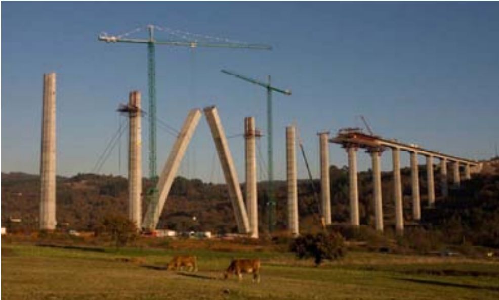
Fig. 5 Semiarco en proceso de abatimiento
