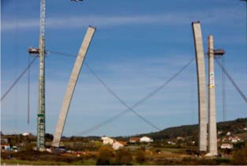
Fig. 9 Proceso de abatimiento del primer semiarco
