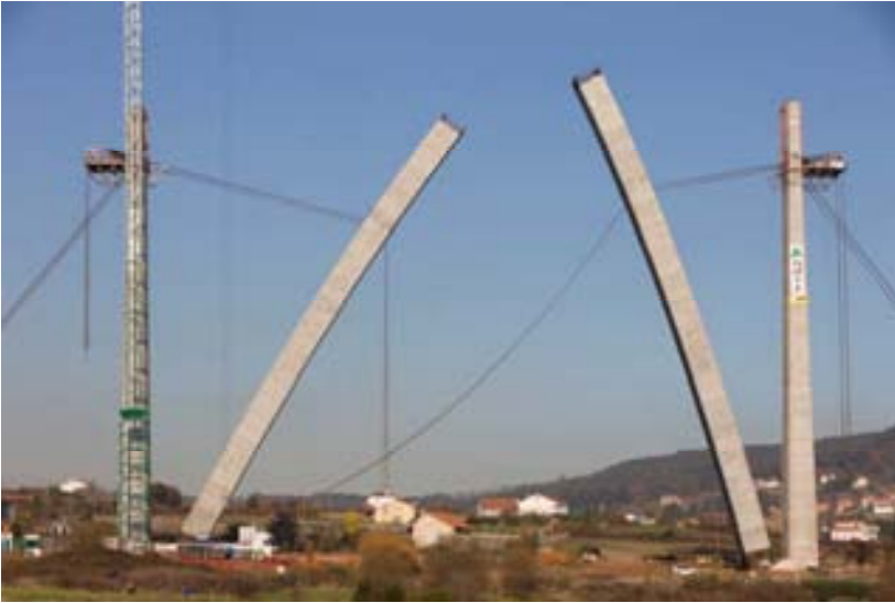
Fig. 12 Proceso de abatimiento del segundo semiarco
