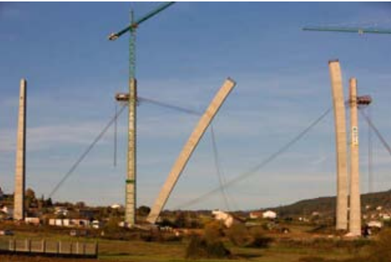
Fig. 10 Primer semiarco en posición definitiva
