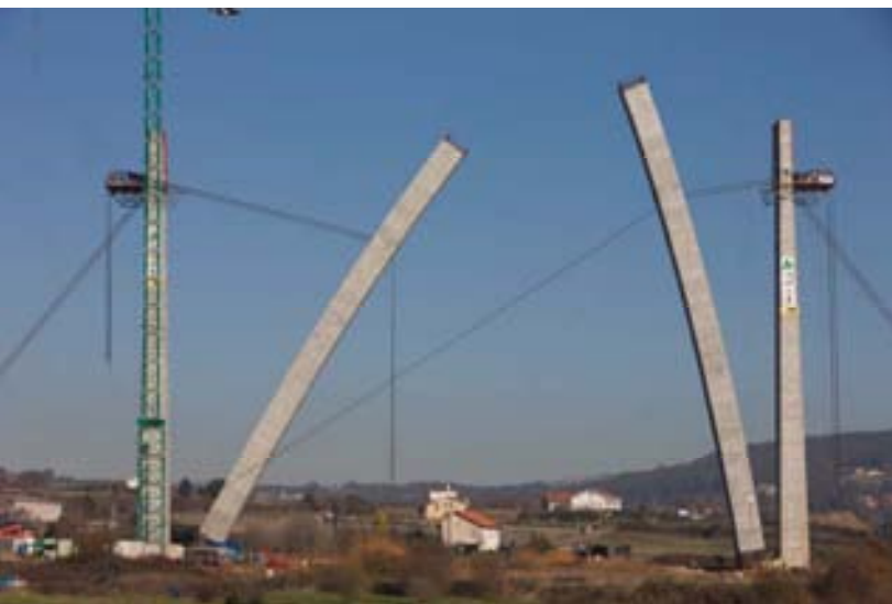
Fig. 11 Actuación en cables de descenso y auxiliares en el segundo semiarco
