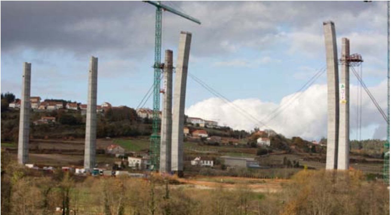
Fig. 6 Arco en posición inicial
