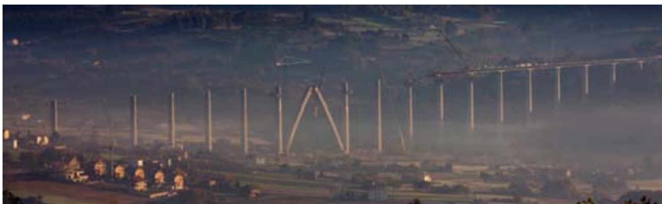
Fig. 1 Viaducto de O Eixo
