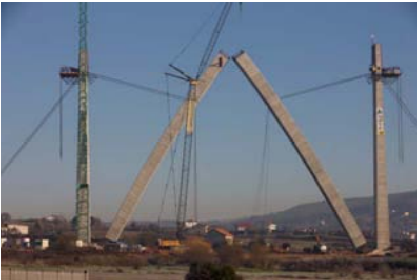
Fig. 13 Semiarcos en posición final
