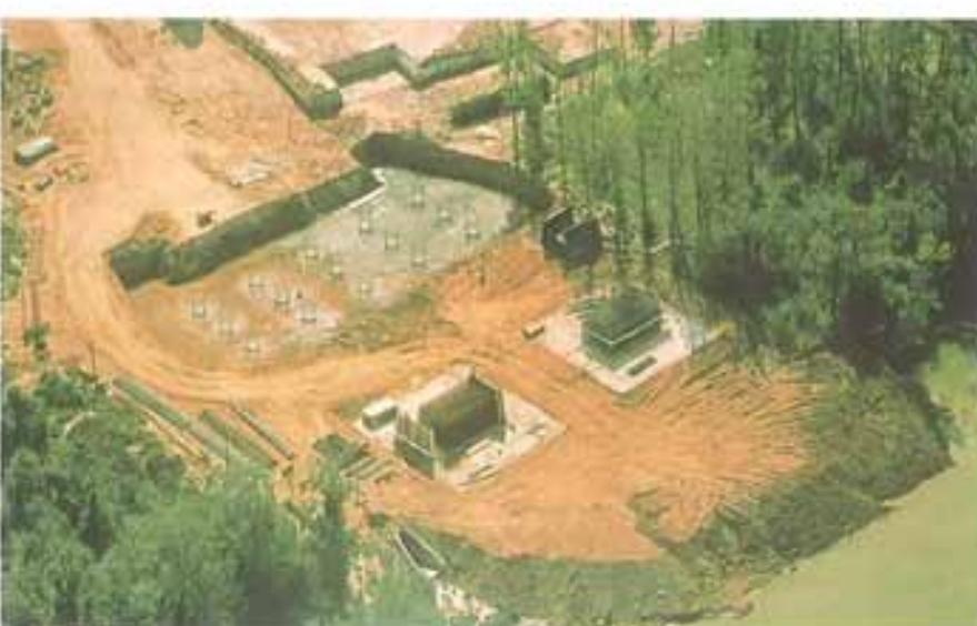
Foto 1. Cimentación del contrapeso y armadura de los pilotes de pilas en la margen izquierda del río.
