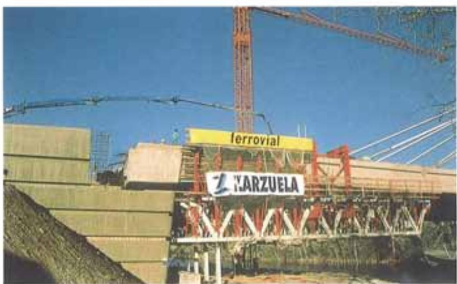
Figura 8. Llenado de la última dovela, que contacta con el diafragma de apoyo sobre el estribo de margen derecha.
