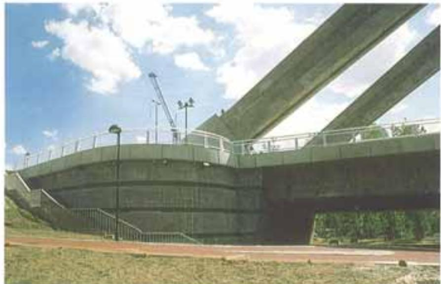
Figura 15. Vista del contrapeso final con los arranques de velas en el puente acabado.
