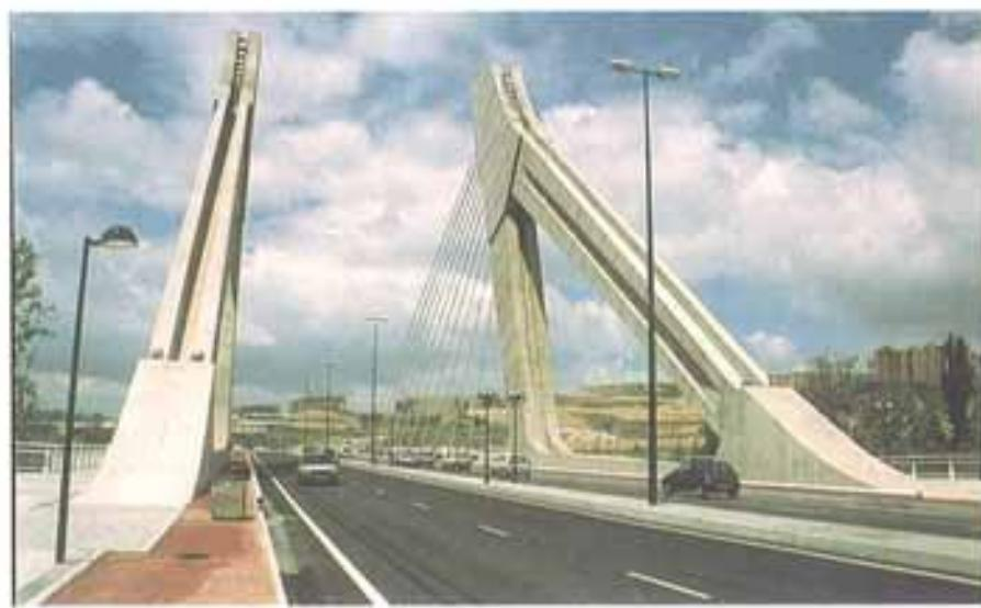
Figura 10. Pórticos triangulares de la margen izquierda.
