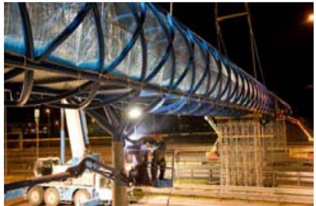
*Fig. 29 Soldadura de brazos superiores de pila a su fuste*
