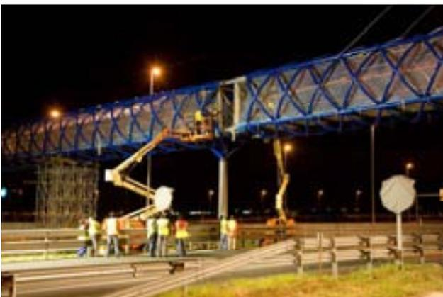
*Fig. 28 Zona de unión de tramos izados*
