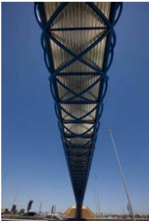
Fig. 6 Forjado de chapa colaborante
