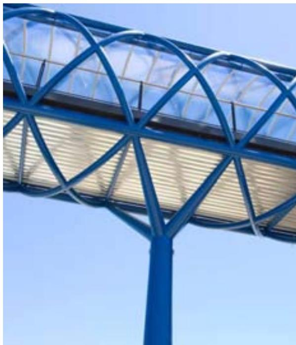
Fig. 7 Pila mixta
