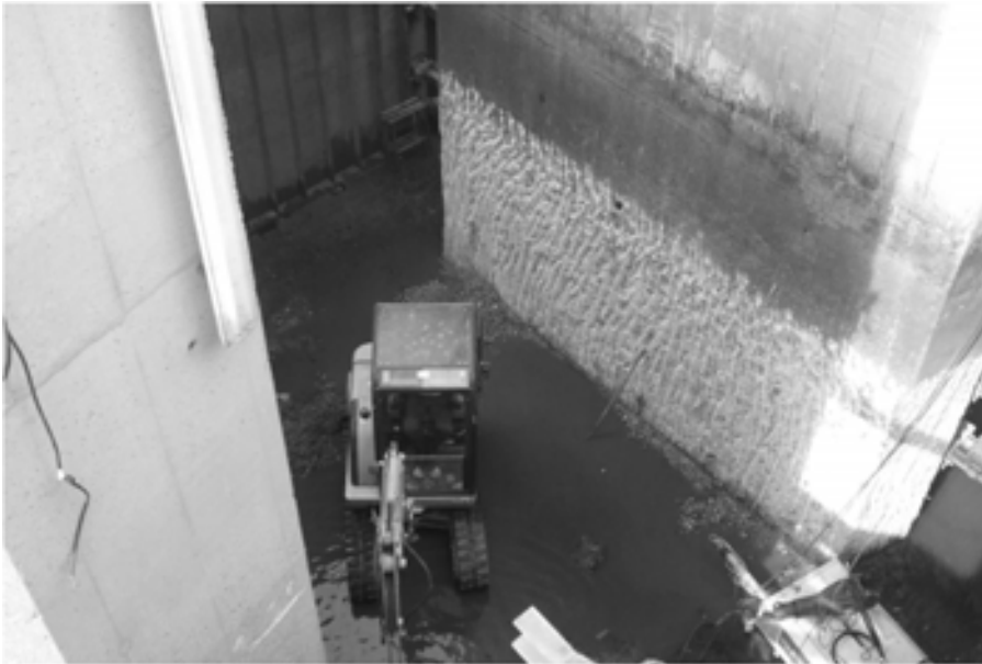
Fig. 3. Vista del espacio entre dos pantallas. Se aprecian las superficies de hormigón tratadas para aumentar la rugosidad.
