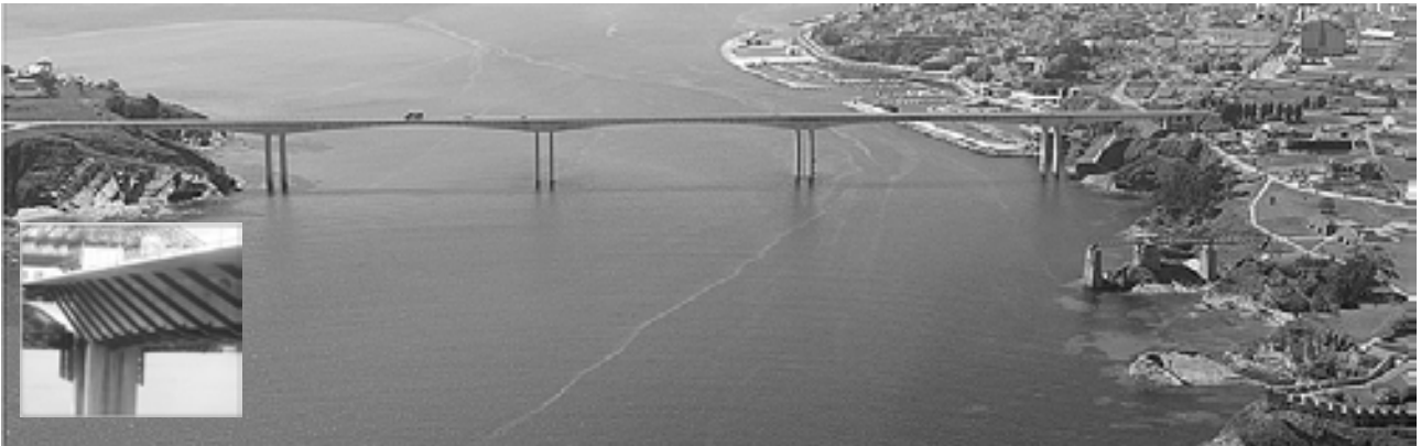
Fig. 1 Vista general del Puente de Los Santos antes del inicio de las obras de ampliación y con las obras avanzadas
