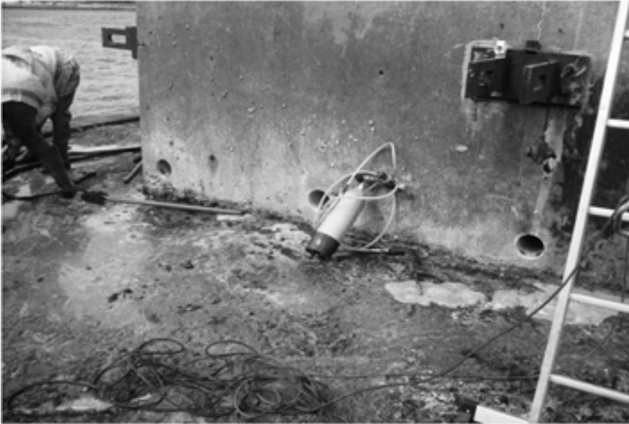
Fig. 4. Refuerzo de las cimentaciones de las pilas laterales. Ejecución de taladros.
