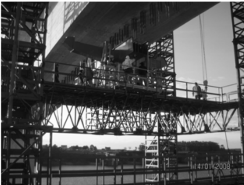
Fig. 11. Colocación de la estructura metálica (Travesía)
