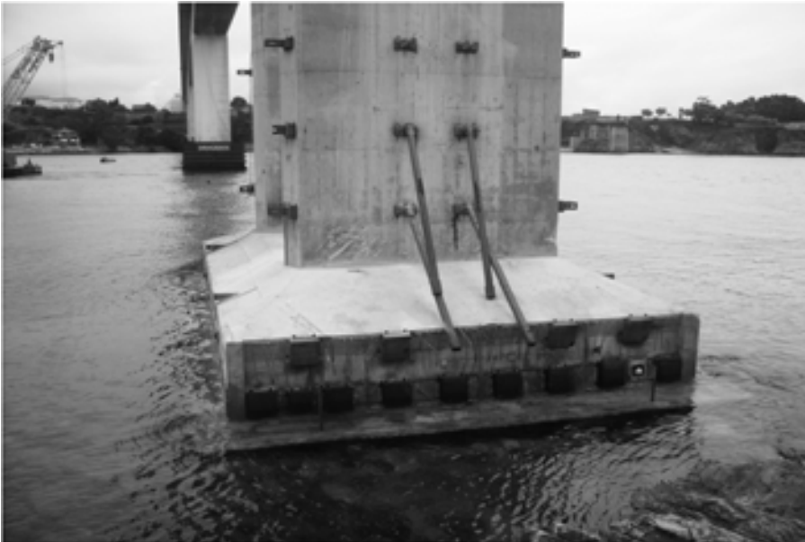
Fig. 5. Aspecto final de la zapata pretensada de la pila 1.
