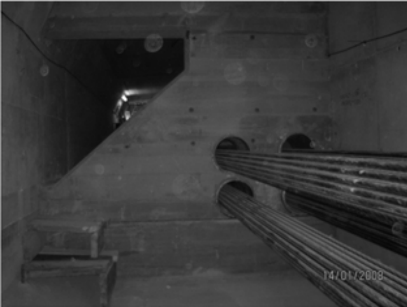
Fig. 12. Vista del pretensado exterior atravesando un diafragma pensado para limitar la distorsión del tablero.
