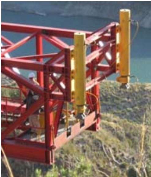
Figs. 6 y 7 Gatos de recuperación de flecha en la punta de la nariz
