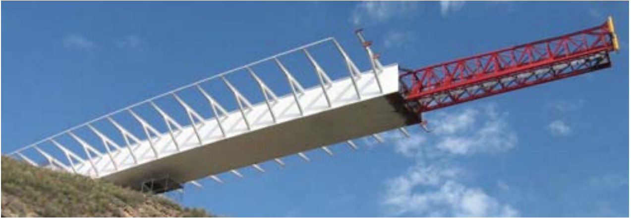
Figs. 8 Vista general del tablero durante el proceso de empuje
