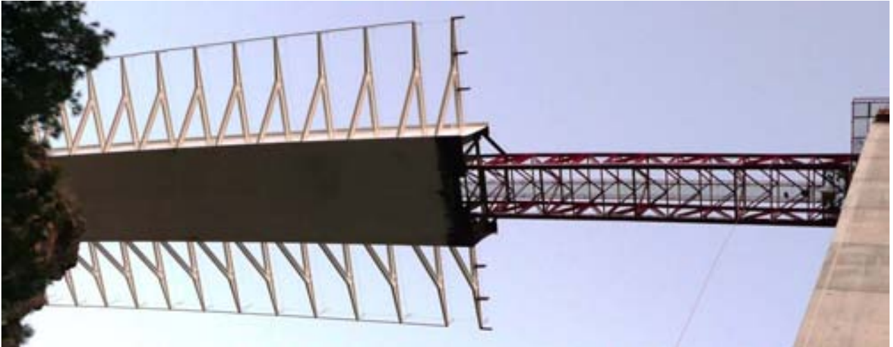
Fig. 4 Vista inferior del tablero metálico durante el proceso de empuje. Alcance de P1.
