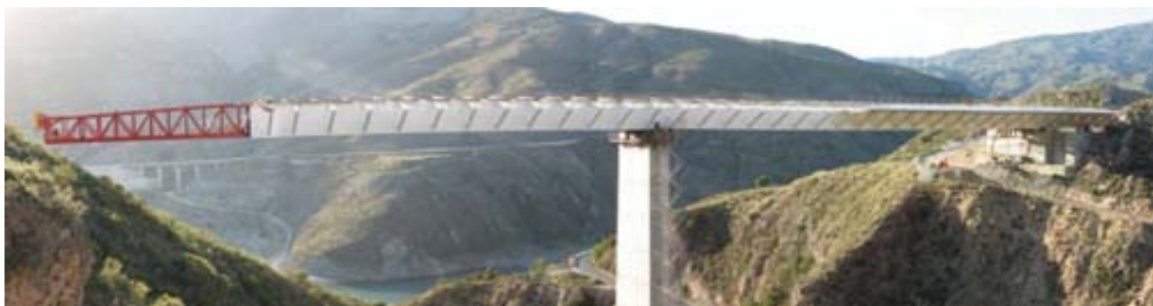
Fig. 1 Alzado del viaducto durante el proceso de empuje del tablero metálico. Alcance de E2.
