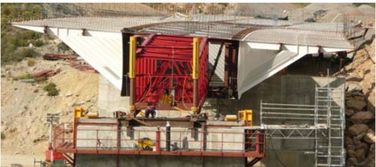
Fig. 3 Vista frontal del tablero metálico durante el proceso de empuje. Alcance de P1.
