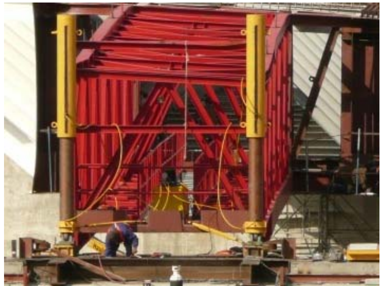
Figs. 6 y 7 Gatos de recuperación de flecha en la punta de la nariz
