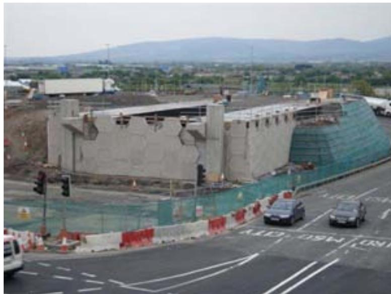
*Fig 20- Construcción del estribo sur y de la plataforma de lanzamiento.*
