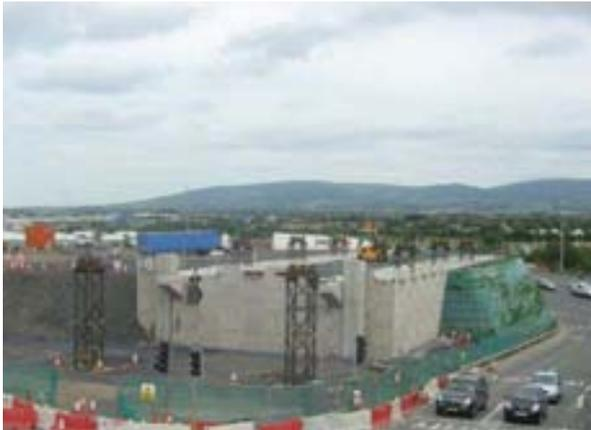
Fig 21- Plataforma auxiliar con torres temporales.
