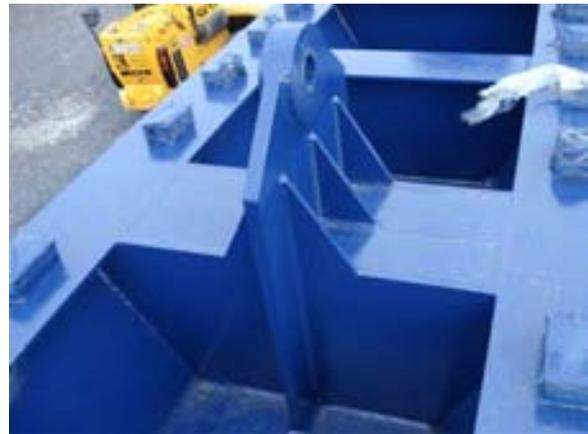
Fig 8.- Detalle orejeta de tablero.
