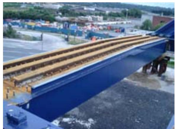
Fig 10.- Viga transversal en arranques
