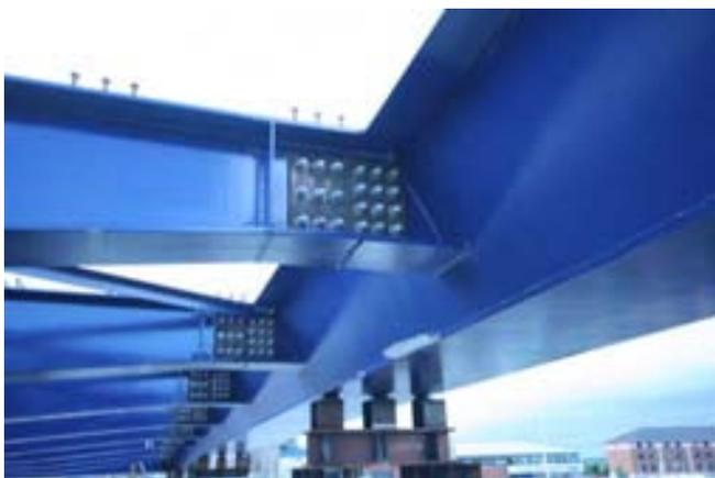
Fig 9.- Viga longitudinal y transversal
