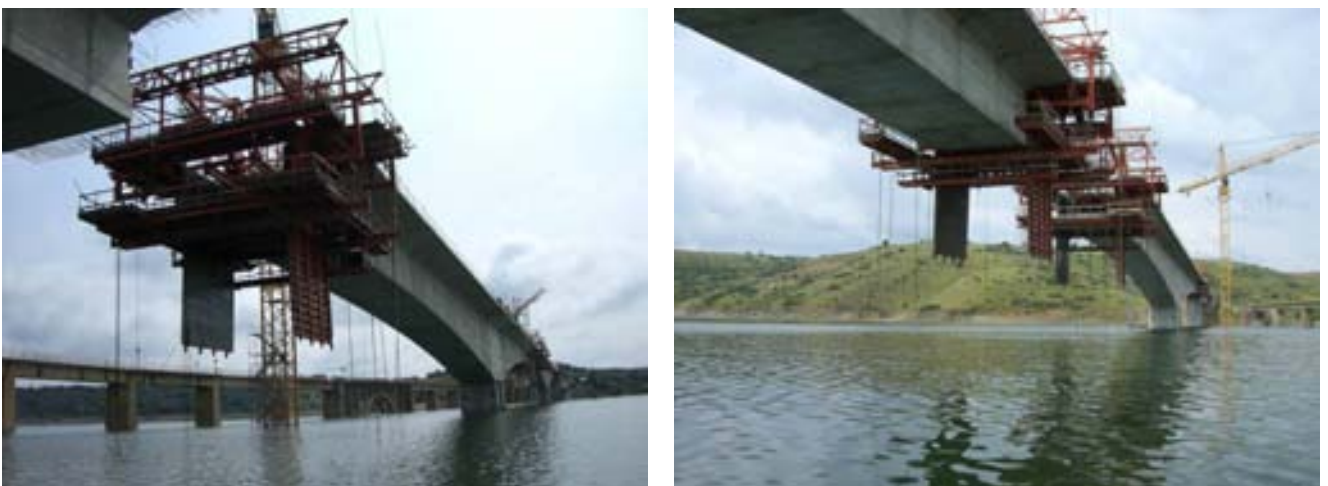
Fig.15 Extremos de las T's antes de la ejecución de las dovelas de cierre en vanos 2 (izquierda) y central (derecha)
