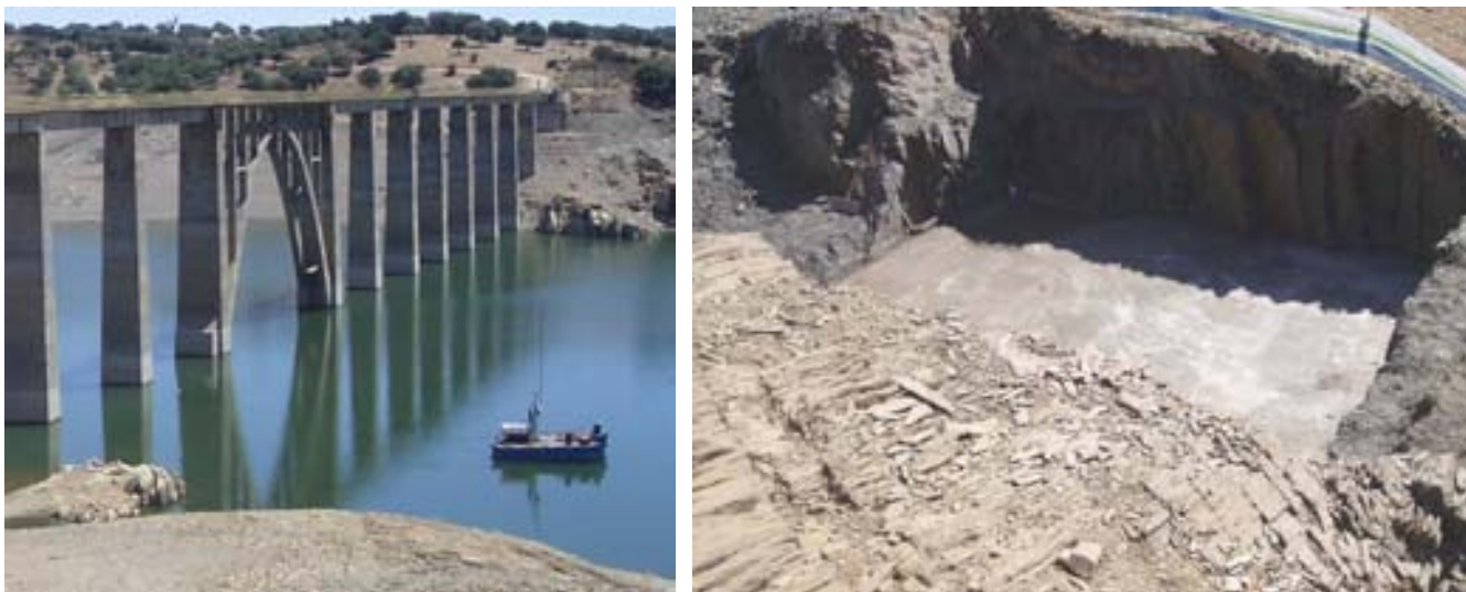
Fig. 7 Vista de la ejecución de sondeo en embalse desde estribo 1 y excavación en cimentación de pila 1
