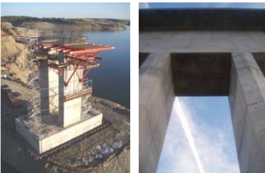
Fig. 6 Izquierda, ejecución de pila 3, y recinto de tablestacas en península rodeando el encepado. Derecha, pila 2 finalizada.
