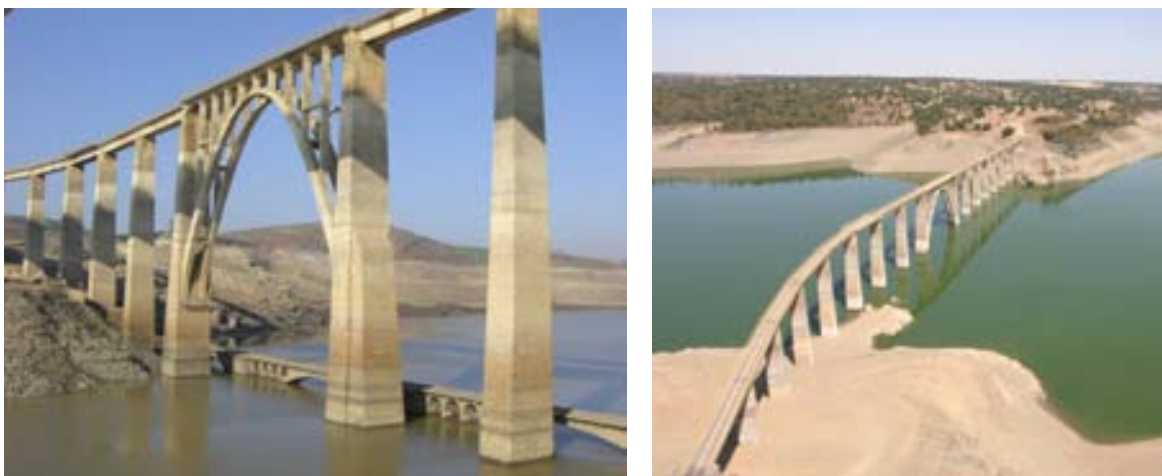
Fig. 1 Tramo central del puente de 1935 y detrás el de 1927 parcialmente sumergido. A la derecha vista aérea del puente existente.
