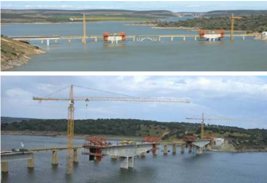
Fig.13 Dos fases del avance en voladizo. Ejecución de dovelas 2 (arriba) y dovelas 8 (abajo)
