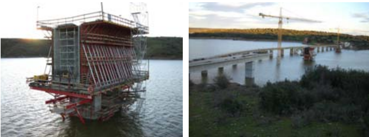
Fig.10 Dovela cero sobre pila 2 antes del hormigonado de la losa superior, y vista general durante la ejecución de dovelas cero
