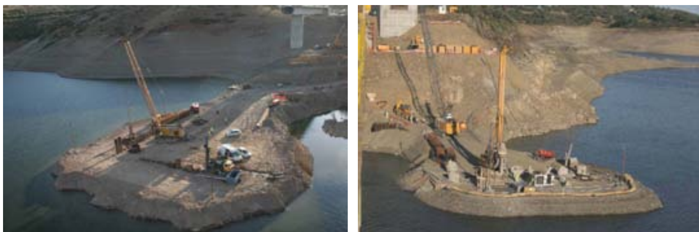
Fig. 8 Vista de las penínsulas desde el puente existente, hincado de camisas en península 1 y excavación en península 2
