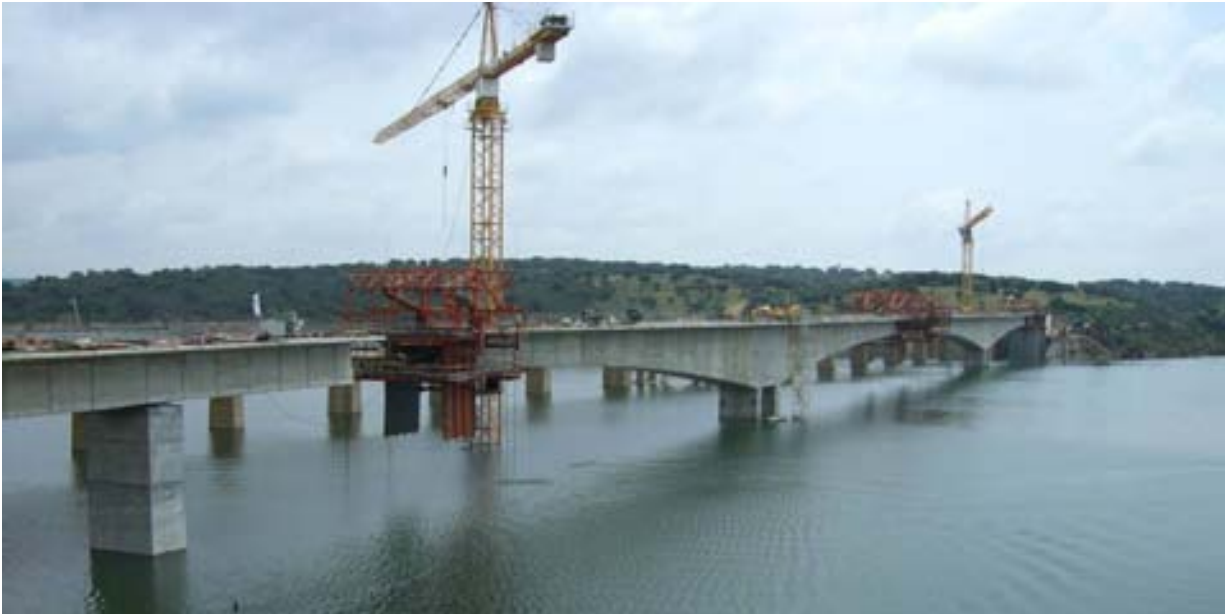
Fig.14 Fase final del avance en voladizo, previa a la ejecución de las dovelas de cierre
