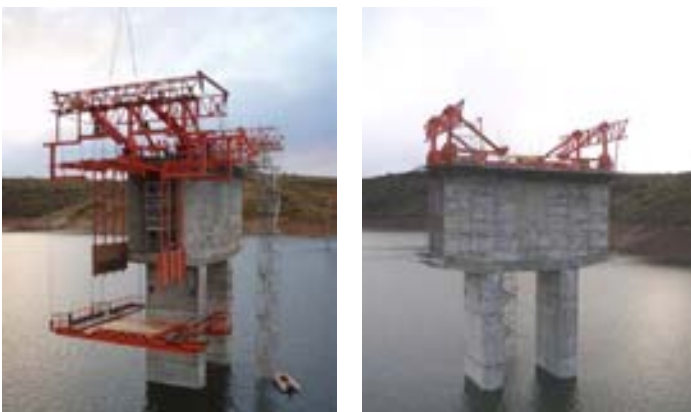
Fig.11 A la izquierda, carro de avance montado sobre pila 3 y a la derecha fase inicial de montaje en pila 2
