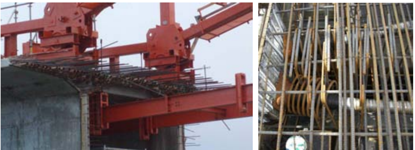
Fig. 4 Vainas de pretensado de voladizos en tala superior de la dovela cero, y detalle de dos anclajes en una dovela
