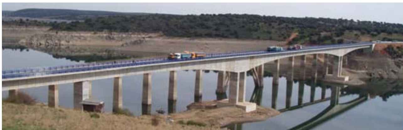
Fig. 2 Vista del Nuevo Puente de Manzanal del Barco.
