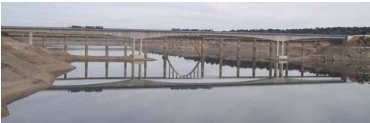
Fig.16 El nuevo puente terminado, durante la prueba de carga
