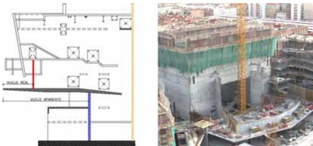
Figura 3. Esquema e imagen de la estructura colgada del Teatro Principal
