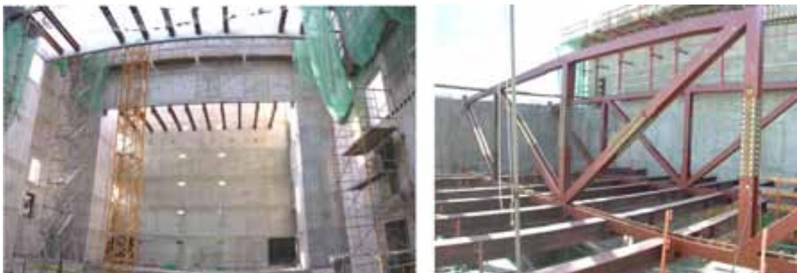
**Figura 7. Interior de la caja escénica del Teatro Configurable. Estructuras mixtas.**
