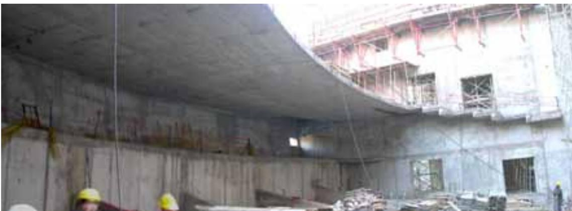
**Figura 5. Vista inferior del sistema estructural que conforma el anfiteatro**
