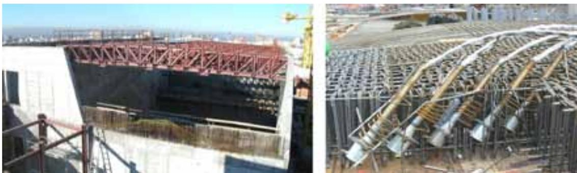
**Figura 6. Celosías mixtas de cubierta. Anclajes de pretensado de pantallas**
