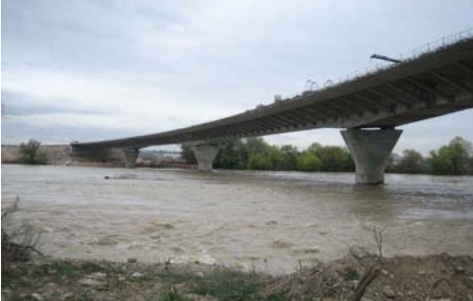
Fig. 9 Vista general del viaducto en construcción (Núcleo central)
