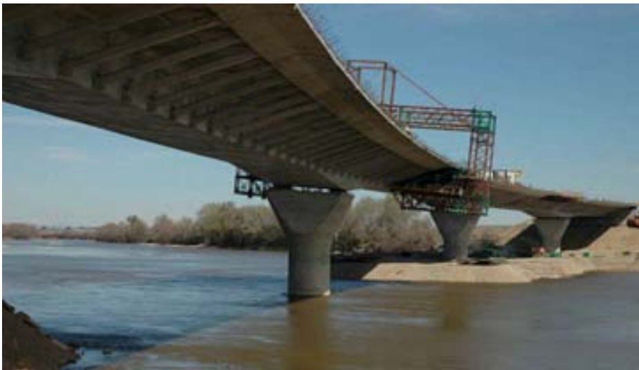
Fig. 10 Vista general del viaducto en construcción (voladizos laterales)
