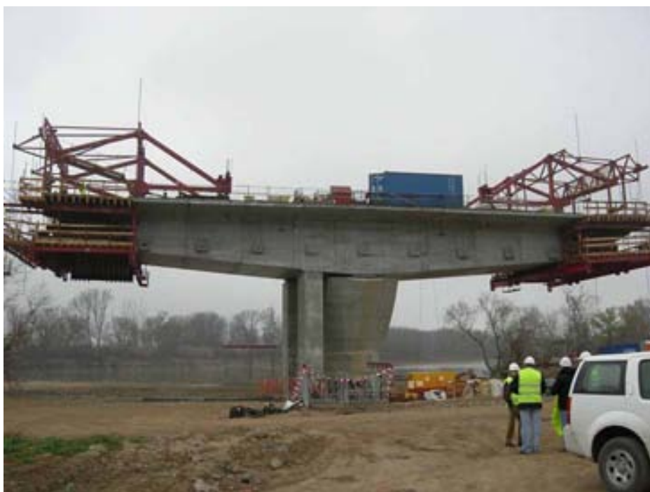
Fig. 8 Avance en voladizo: Pila y tabique provisional
