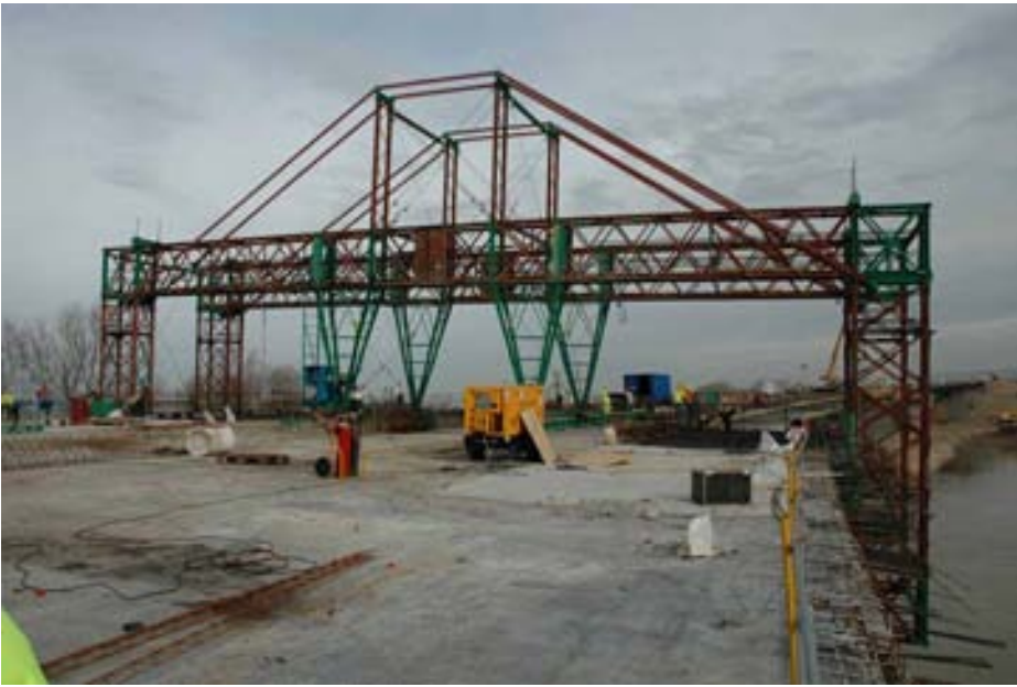
Fig. 11 Carro para construcción de voladizos laterales.
