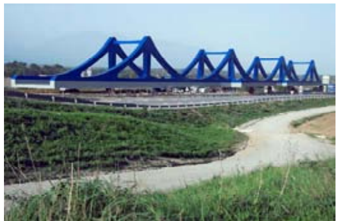
Fig. 7. Vista general de la estructura.
