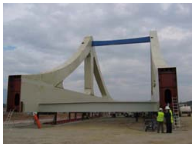
Fig. 5. Vista de la estructura durante construcción.
