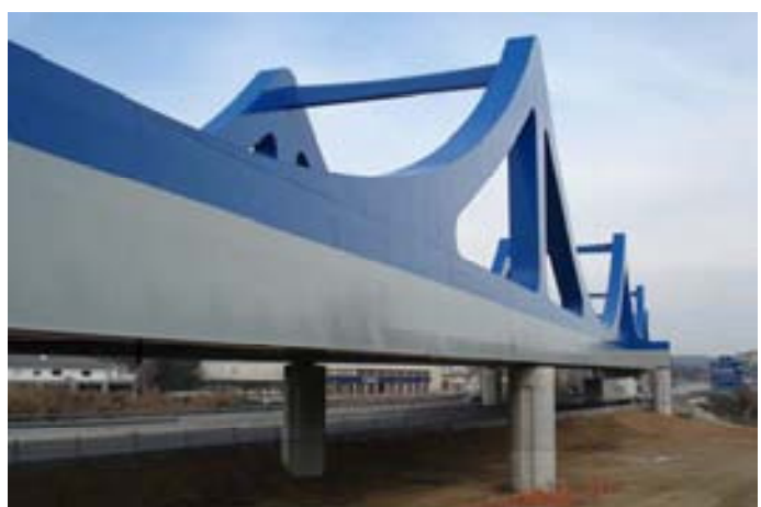
Fig. 9. Vista del tablero en posición definitiva.
