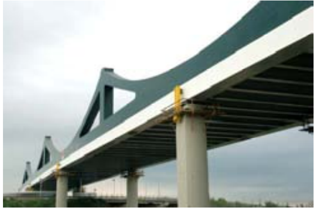
Fig. 12. Vista del tablero en posición definitiva.
