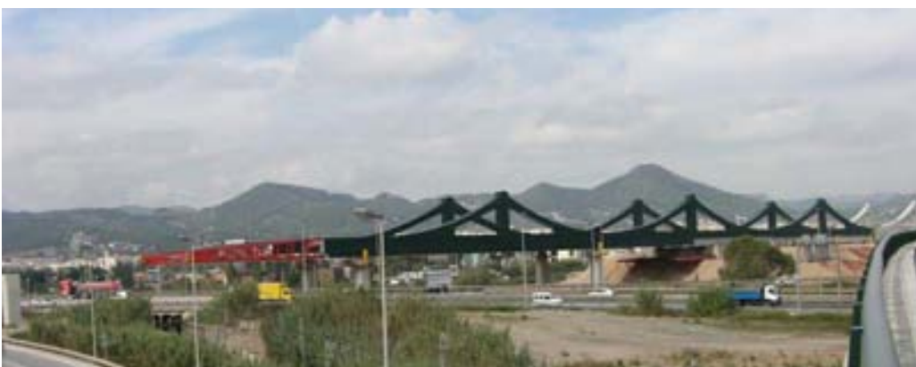
Fig. 14. Tablero metálico y nariz de empuje durante su lanzamiento.
