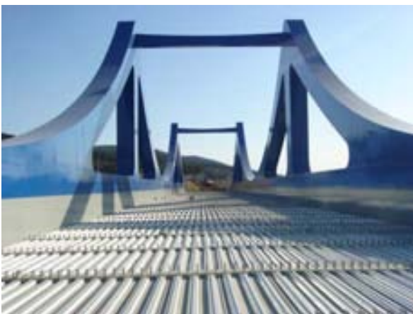
Fig. 6. Vista interior del puente en construcción.
