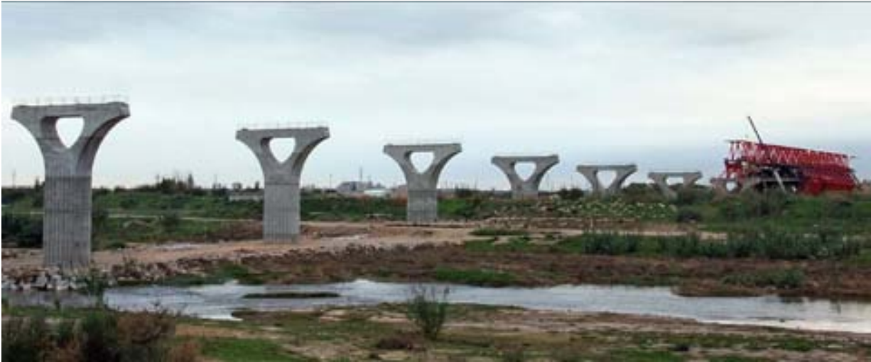
Fig. 13. Pilas del tablero de hormigón y vista de la autocimbra.
