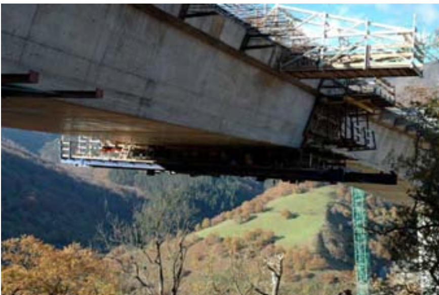
Figura 15. Detalle de cierre de vano 5 sobre el bosque mixto de Montabliz
