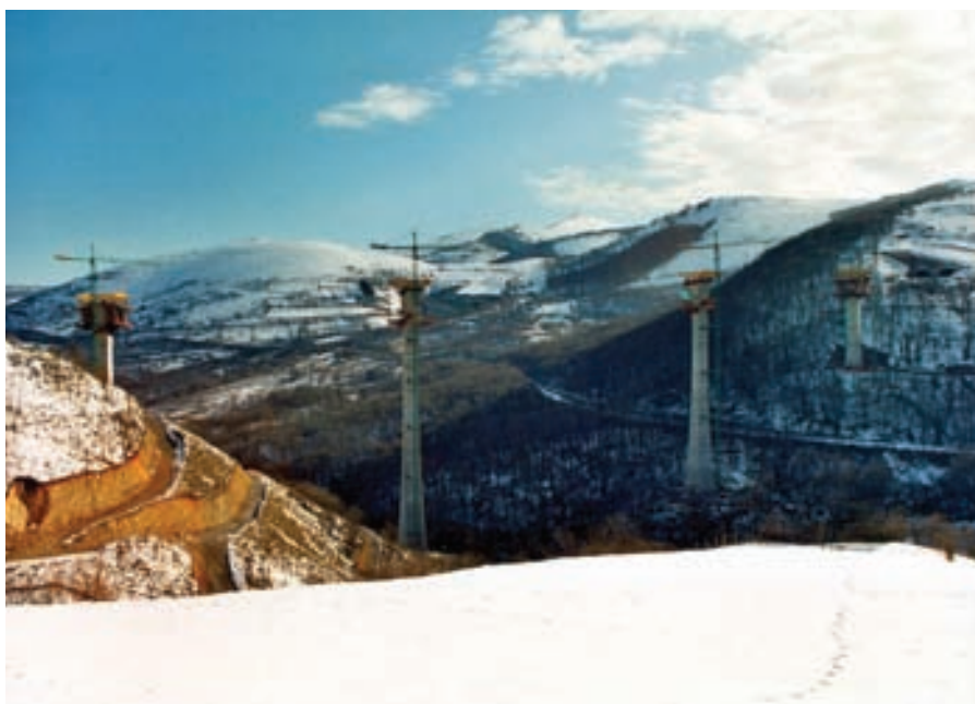
Figura 26. Alzado longitudinal de pilas con dovelas "0" terminadas. Figure 26. Longitudinal elevation of the piers with "0" segments finished.
