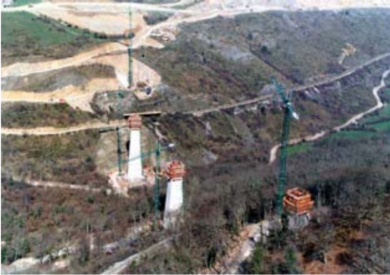
Figura 12. Vista general de ejecución de alzados de pilas
