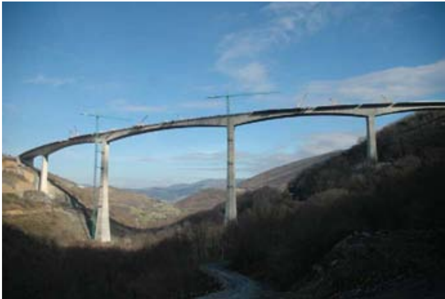
Figura 16. Vista general del viaducto
