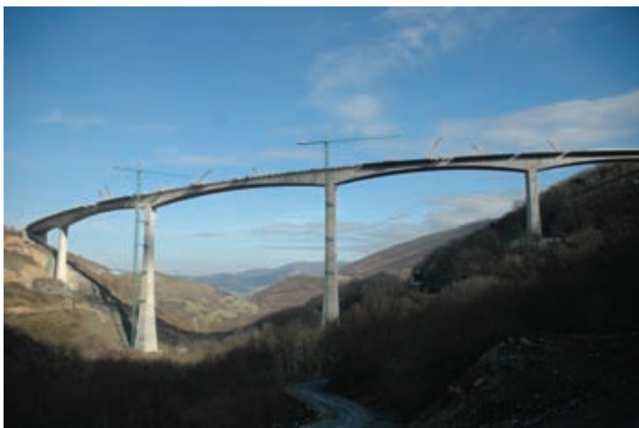
Figura 36. Vista general del viaducto.
