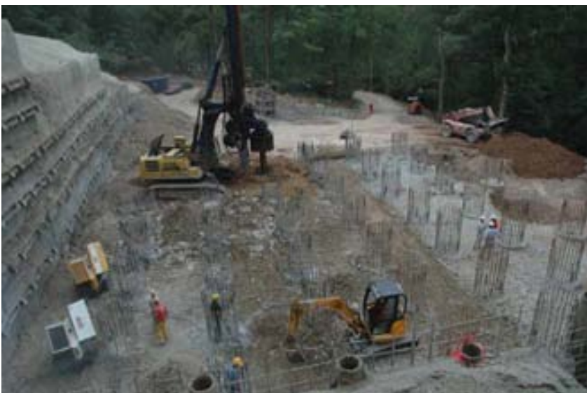
Figura 7. Descabezado de pilotes en pila 3
