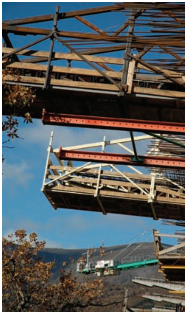
Figura 35. Carros de nervios transversales de voladizos.
