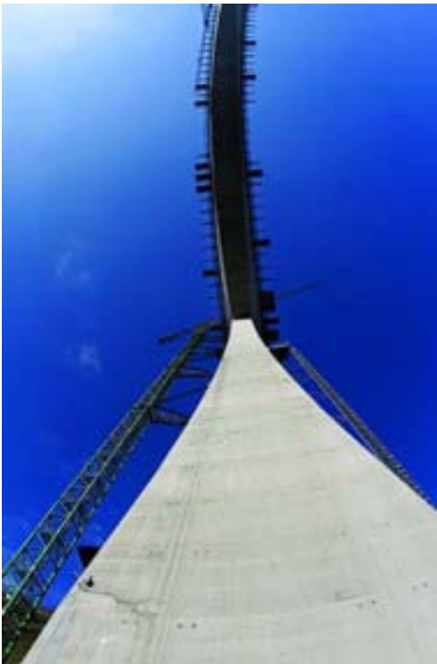
Figura 9. Vista inferior de fondo de tablero desde pila 2
