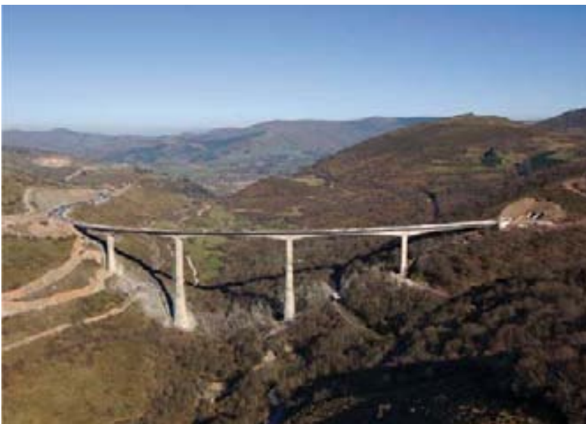
Figura 1. Vista general del alzado del viaducto
