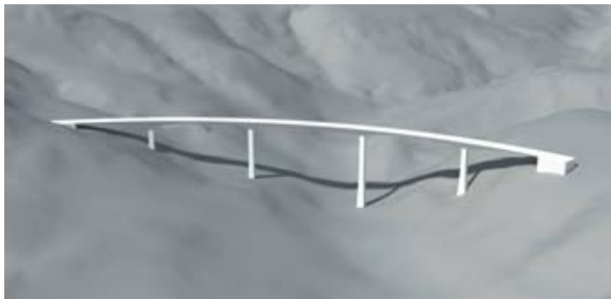
Figura 3. Vista general del viaducto
