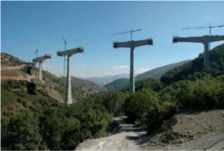
Figura 14. Avance progresivo de las "Ts" de la estructura
