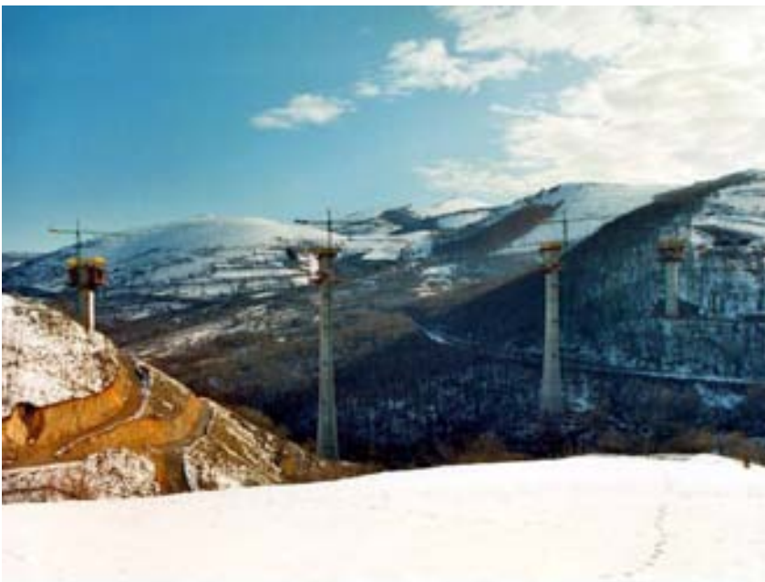
Figura 13. Alzado longitudinal de pilas con dovelas "0" terminadas
