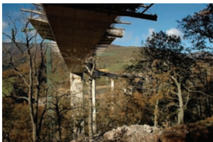
Figura 34. Vista inferior de tablero desde estribo 2.
