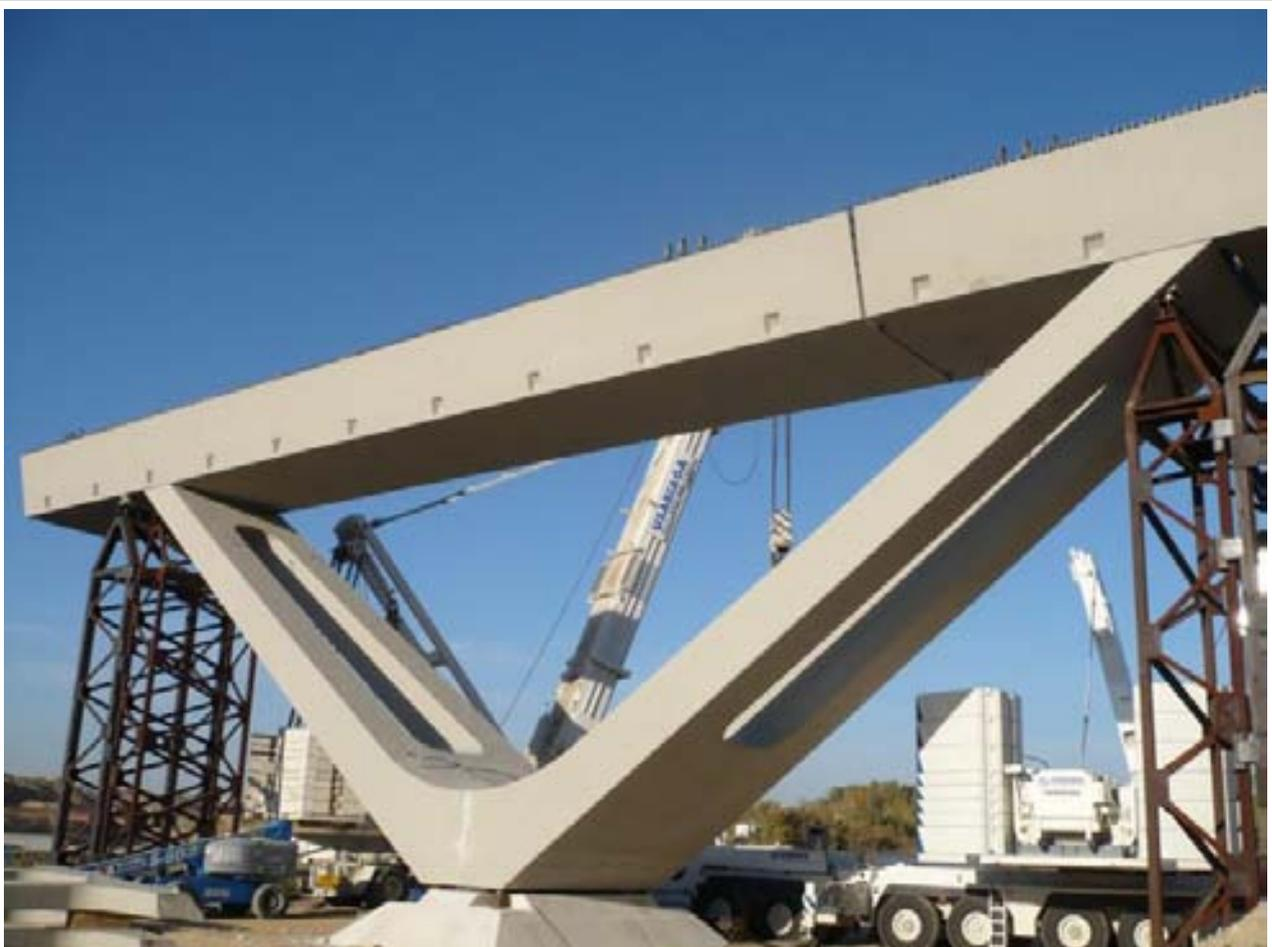
*Fig 9 Conexión entre vigas para conseguir igual longitud en todas.*
