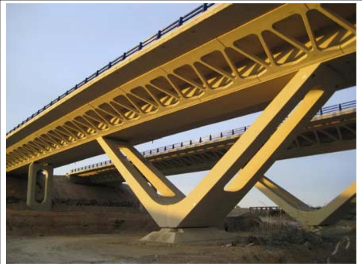
*Fig 12 Vista detalle pila en V*
