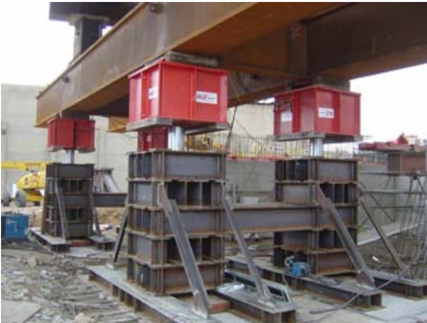
Fig.XX Estructura utilizado para el gateo (descenso) de la parte trasera de la estructura.
