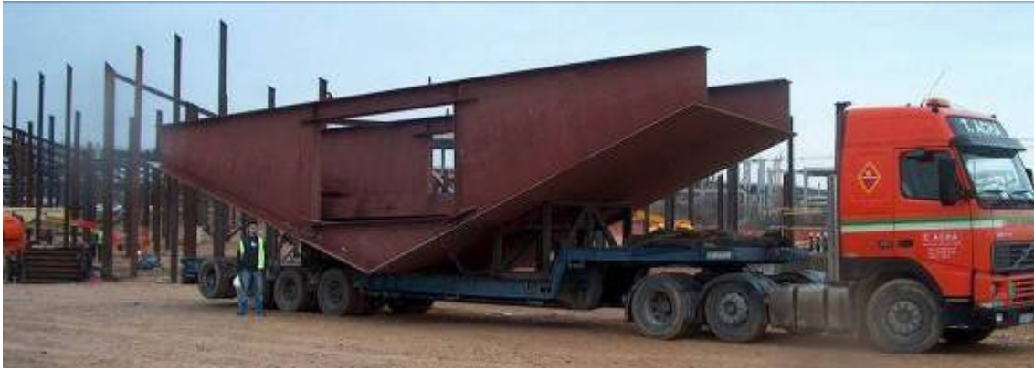
Fig.4 Diafragma interior del cajón.
