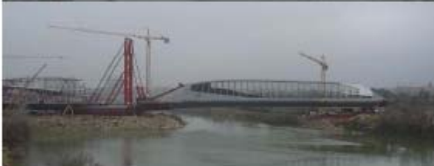
Fig.XX Secuencia de la segunda fase del lanzamiento.
