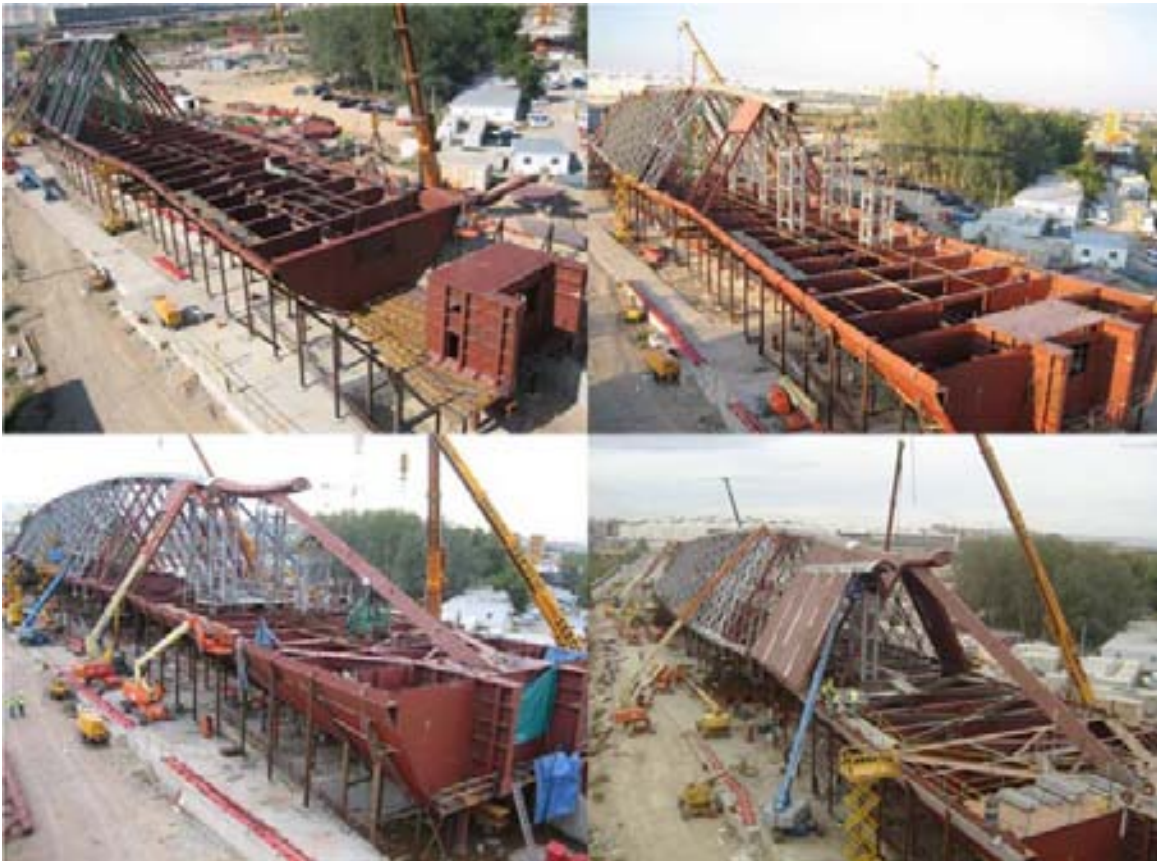
Fig.8 Montaje de la parte sur de la estructura. Cajón, cordón superior, patas, costillas y paneles de fachada.
