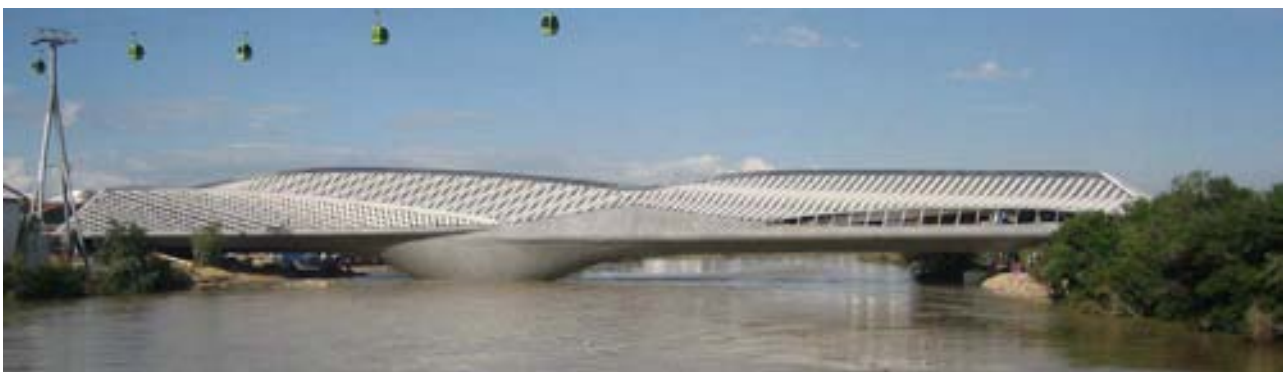
Fig.5 Vista del puente terminado desde aguas arriba.
