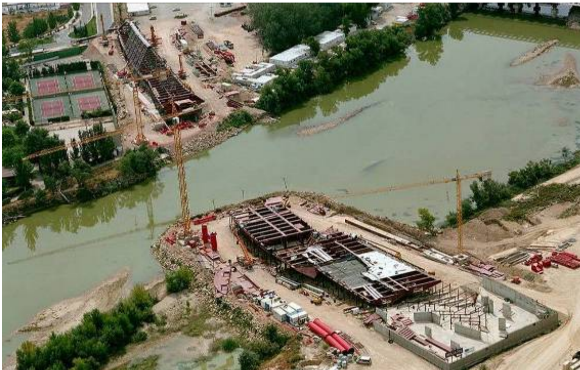
Fig.3 Agosto 2007. Montaje de la estructura metálica en ambas márgenes.
