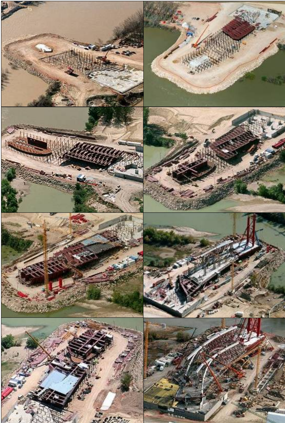
Fig.XX Secuencia constructiva del vano norte desde febrero de 2007 hasta diciembre de 2007.
