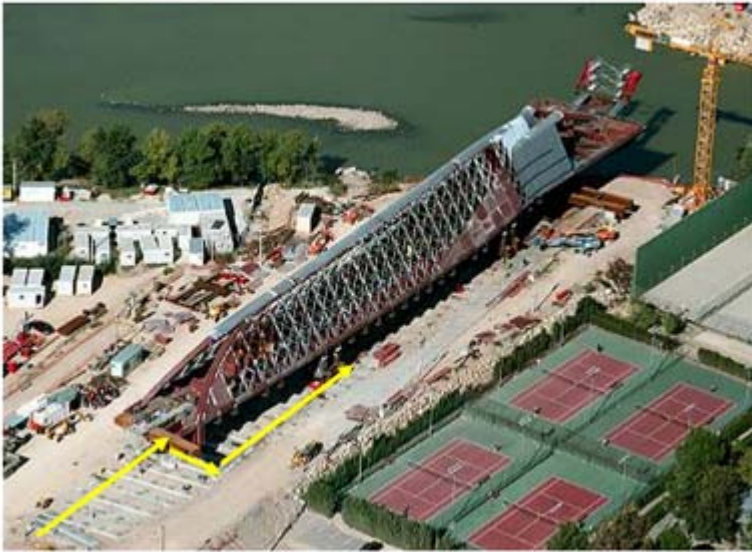
Fig.XX Los tres movimientos que constituyeron la primera fase del lanzamiento.
