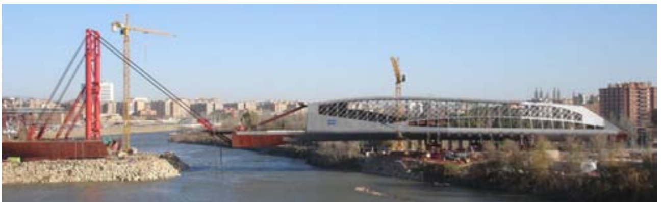
Fig. 1 Vista de una fase de lanzamiento
