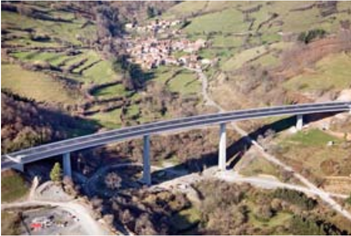
Fig. 1 Vista aérea del Viaducto de Pujayo
