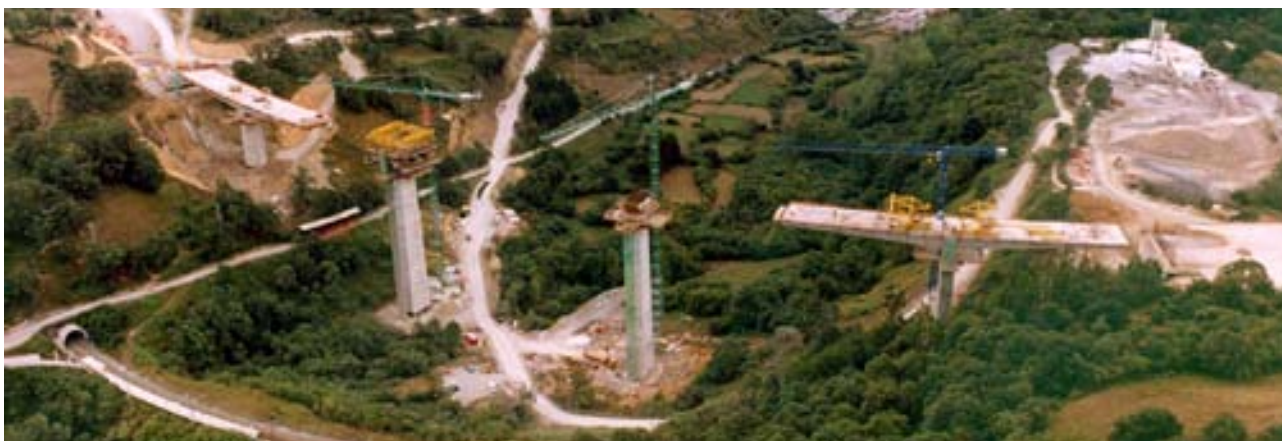
Fig. 7 T de pilas 1 y 4 acabadas. Avance en voladizo en T de pila 2
