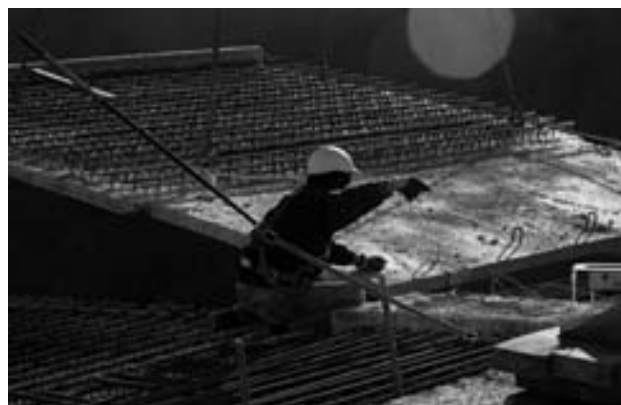
Figura 13. Prelas para hormigonado in situ de voladizos laterales.
