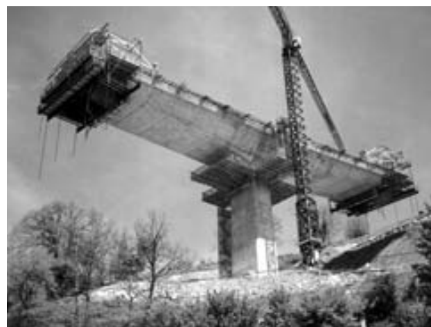
Figura 15. Construcción de la T de la pila 1.
