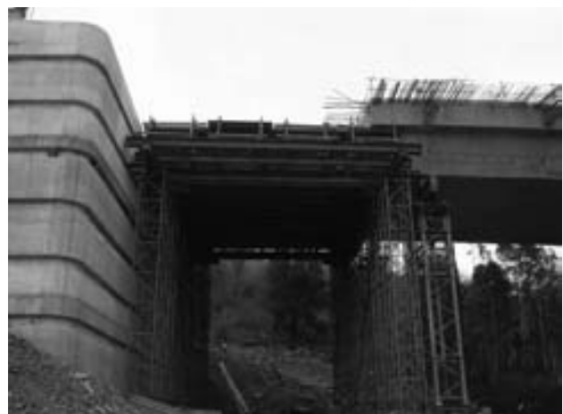
Figura 7. Cimbra fase lateral vano 5.
