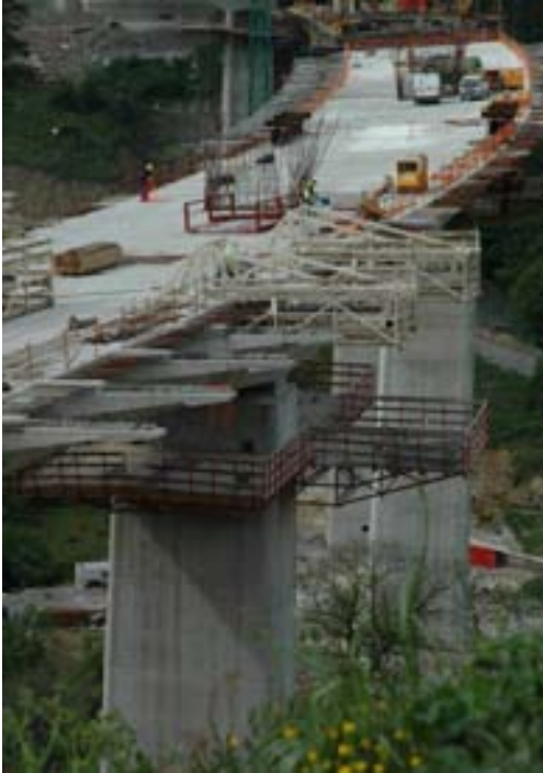
Fig. 14 Construcción de nervios laterales
