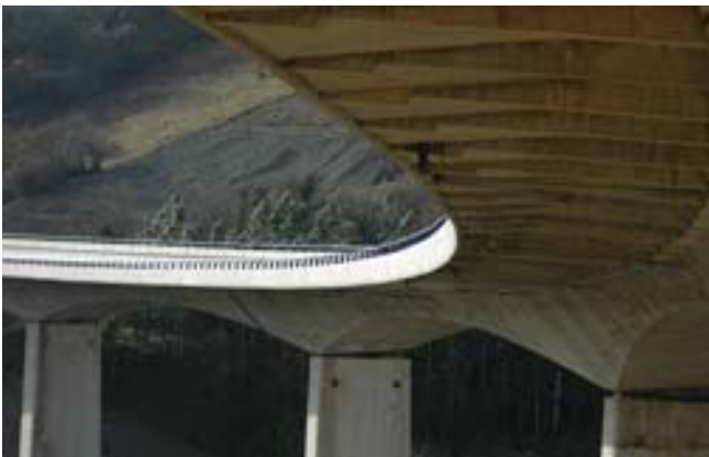
Fig. 4 Detalle del tablero
