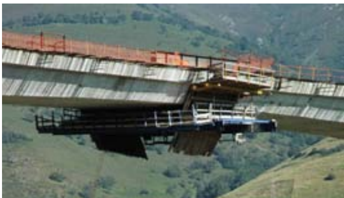
Fig. 11 Dovela de cierre de vanos centrales
