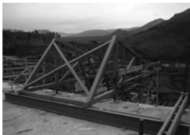
Figura 10. Carro para hormigonado de nervios laterales.
