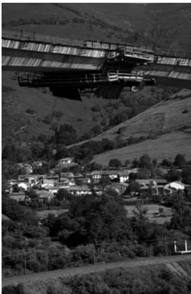
Figura 8. Estructura de cierre.
