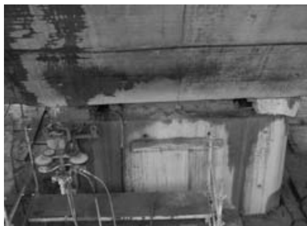
Figura 9. Corte de blocaje provisional de pila.
