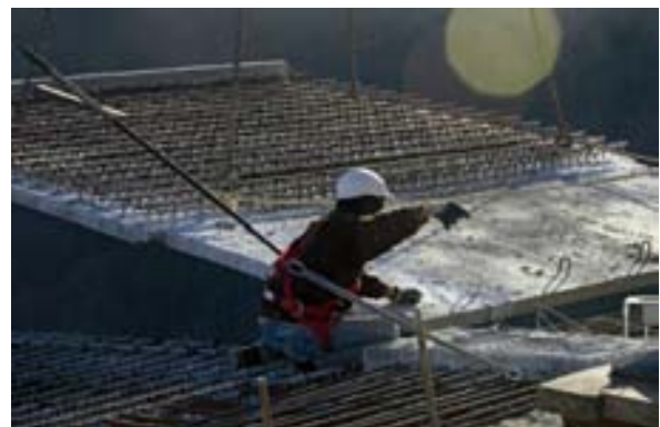
Fig. 17 Prelas para hormigonado de voladizos laterales
