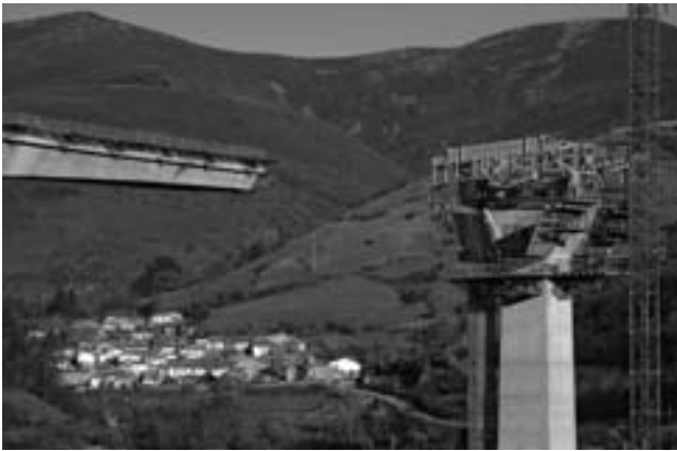
Figura 5. Montaje de carros de avance sobre dovela 0.
