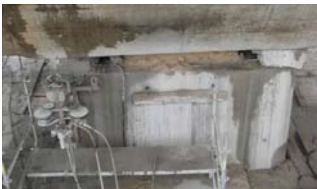
Fig. 12 Corte del blocaje provisional de pila 2
