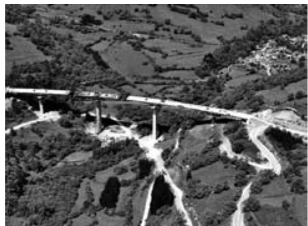
Figura 20. Vista aérea del viaducto durante su construcción.
