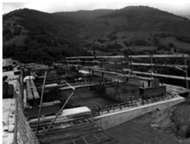
Figura 12. Encofrado para hormigonado in situ de voladizos laterales.
