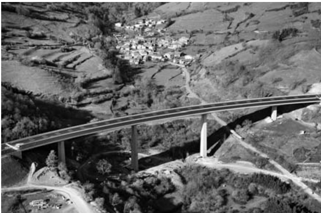
Figura 1. Vista aérea del viaducto, con el pueblo de Pujayo al fondo.
