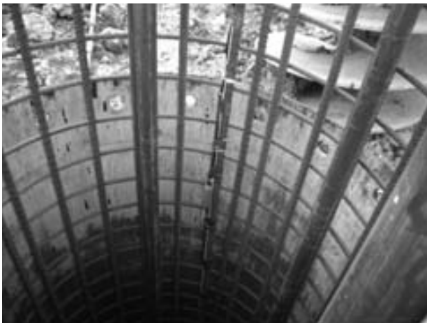
Figura 28. Colocación de extensómetros en pilotes de la pila 4.
