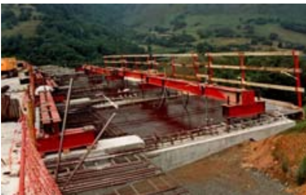
Fig. 16 Encofrado para hormigonado de voladizos laterales
