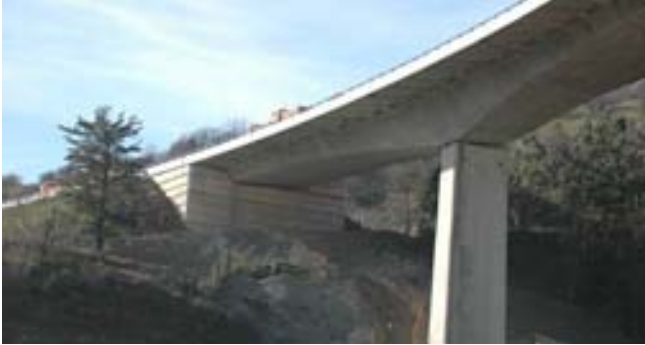
Fig. 3 Vista del estribo 2
