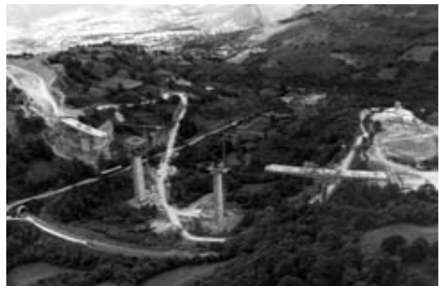
Figura 6. Construcción de la T de la pila 2.
