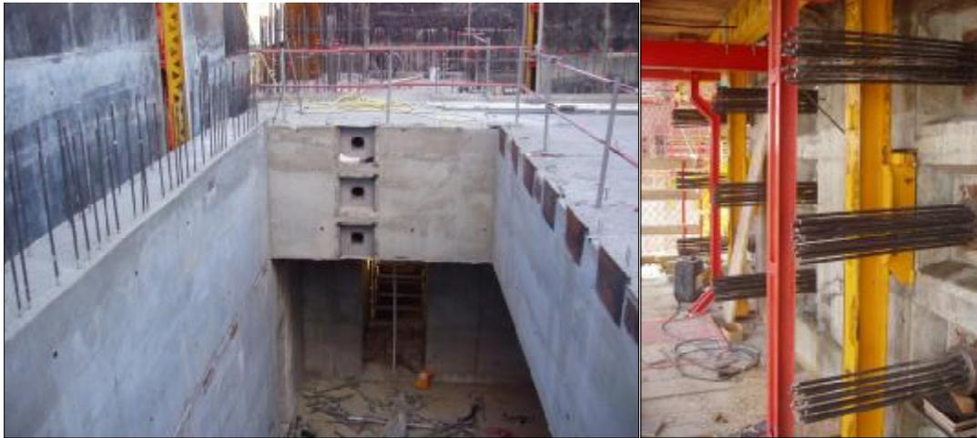
Fig. 18 – Losa desencofrada. Vista antes y después del tesado de cables
