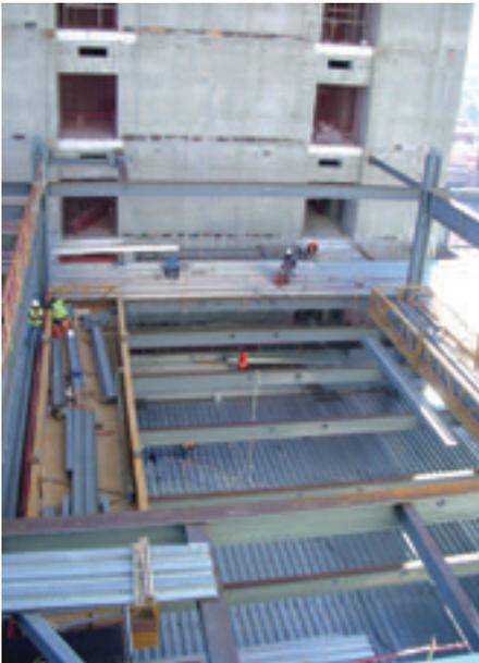
Figura 24. Batea de acopio intermedio en montaje de estructura de plantas.
