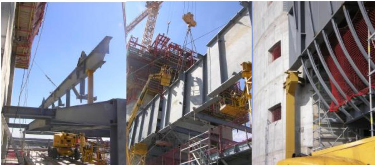
*Fig. 25 – Fases de montaje de las jácenas y la estructura del arco*
