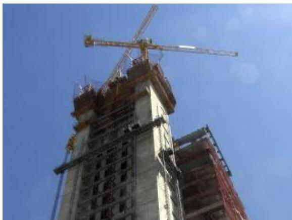
Fig. 6 – Plataformas eléctricas de fachada
