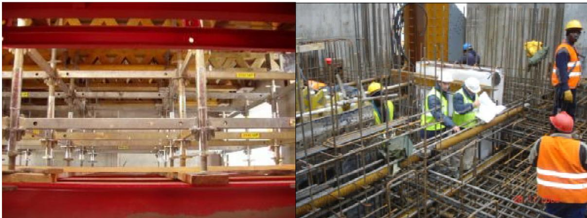
Fig. 16 – Cimbra de apoyo del encofrado
