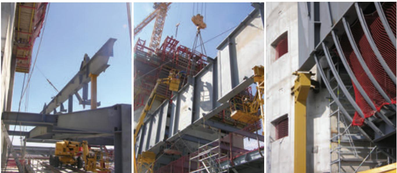
Figura 25. Fases de montaje de las jácenas y la estructura del arco.
