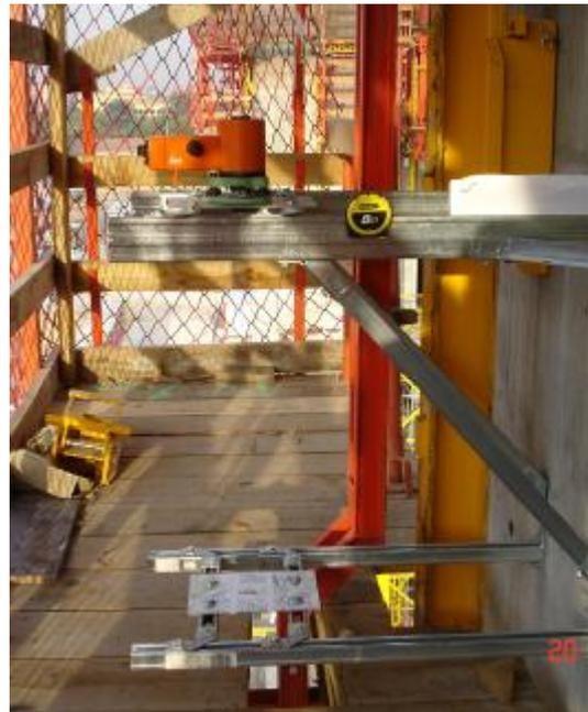
Fig. 3 – Bases fijas de replanteo. Posición y detalle
