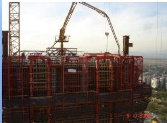
Fig. 7 – Distribuidor de hormigón
