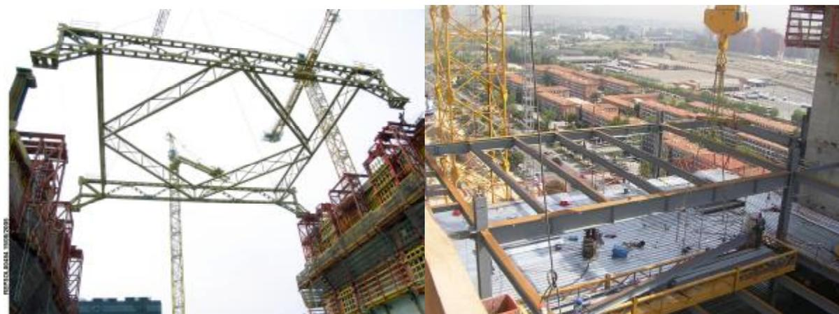
Fig. 23 – Escantillón para replanteo de pilares embebidos
