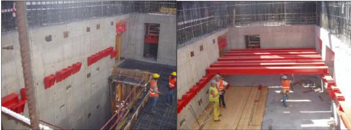
Fig. 15 – Estructura soporte del encofrado de losa de 1,90
