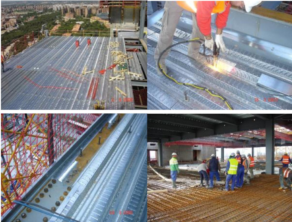
Fig. 26 – Fases de ejecución de los forjados colaborantes
