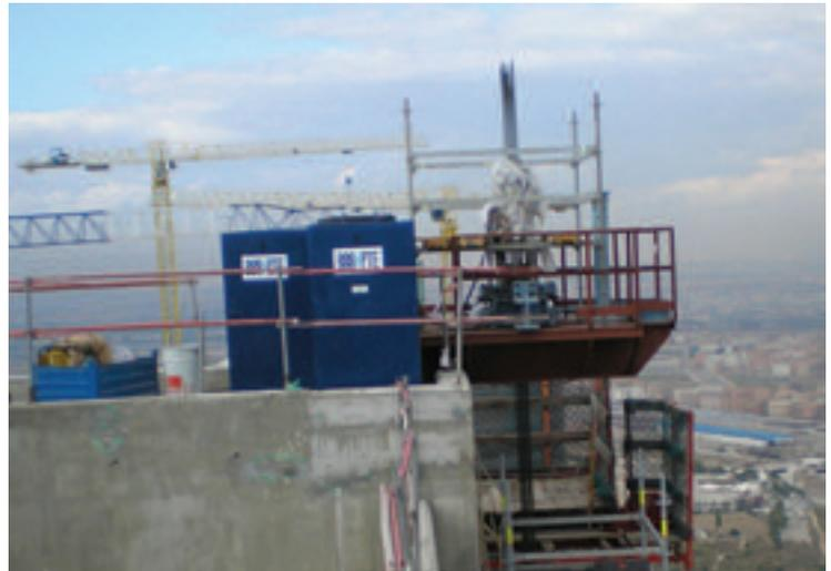
Figura 28. Plataforma de gatos en coronación de núcleo.
