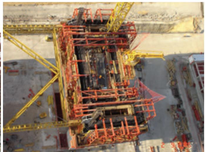
Figura 12. Estructura del encofrado autotrepante
