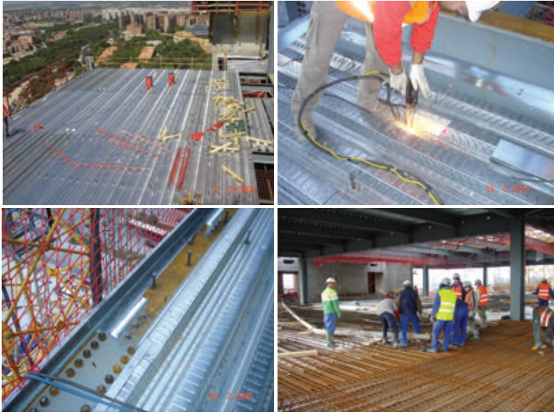
Figura 26. Fases de ejecución de los forjados colaborantes.
