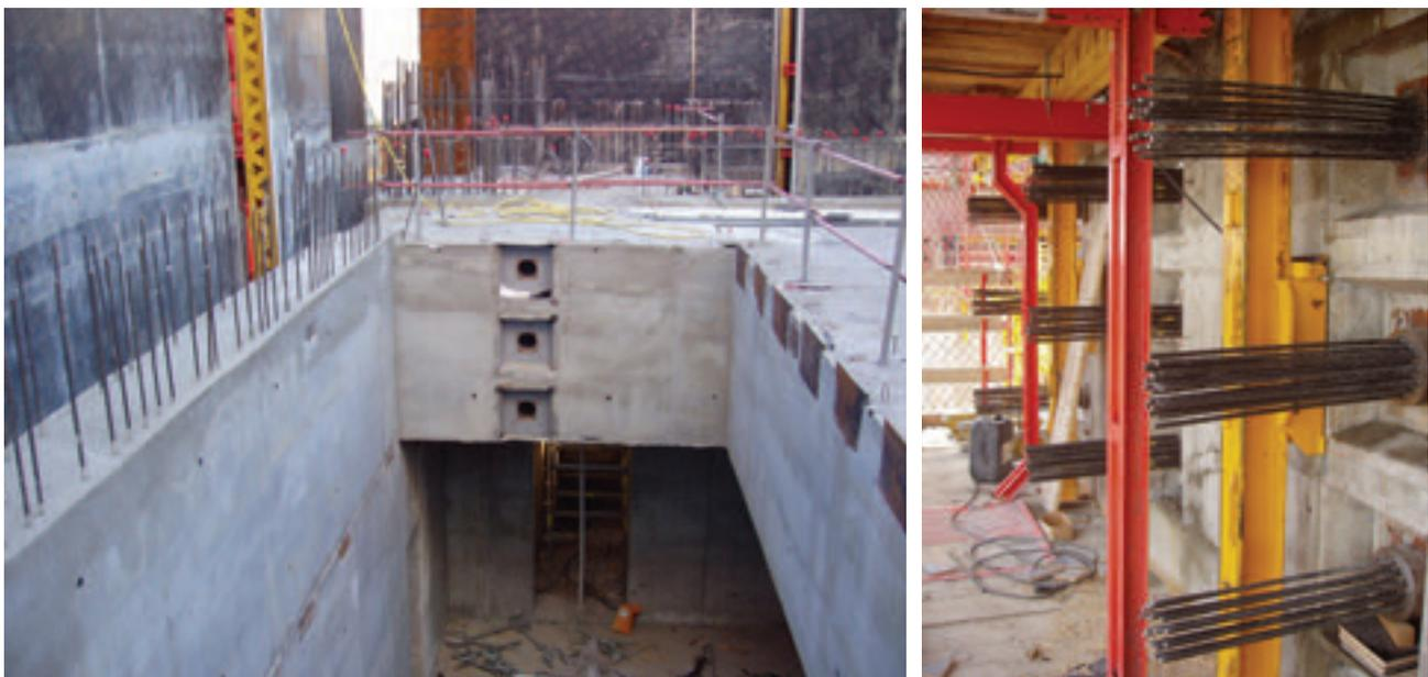
Figura 18. Losa desencofrada. Vista antes y después del tesado de cables.
