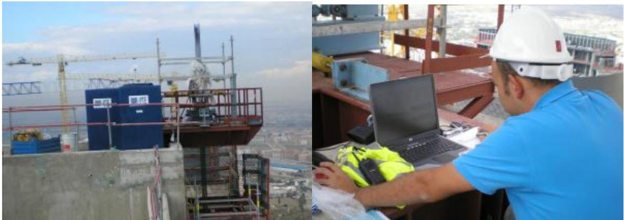
*Fig. 28 – Plataforma de gatos en coronación de núcleo*
