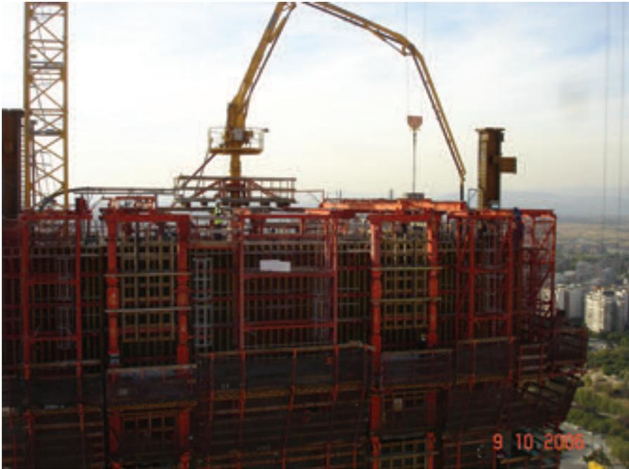
Figura 7. Distribuidor de hormigón.
