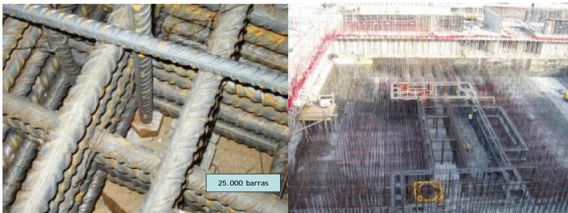
Fig. 10 – Terminal mecánico de anclaje en barra de cortante
