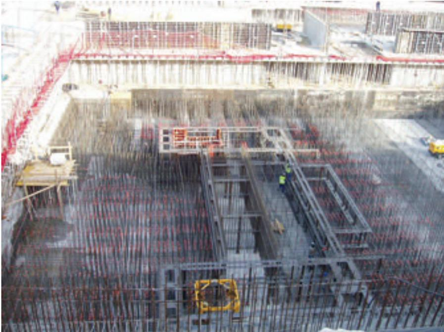
Figura 11. Plantilla para armaduras de espera de núcleo.
