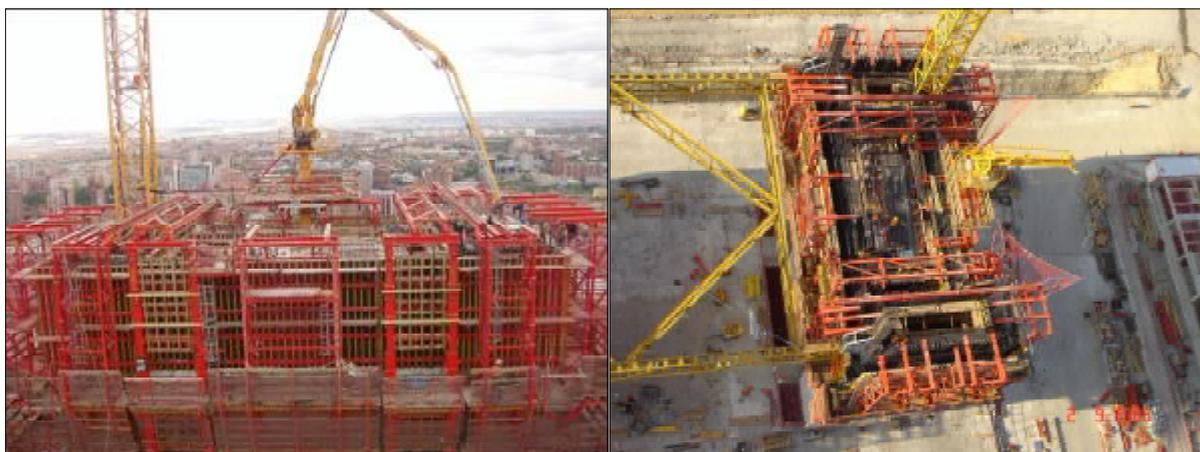
Fig. 12 – Estructura del encofrado autotrepante
