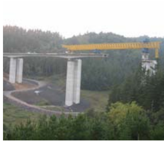
Fig. 7: Viaductos de Zarimutz en construcción
