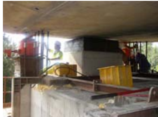
Fig. 22. Apoyos provisionales y definitivos en obra
