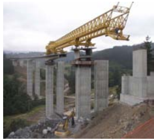
Fig. 5: Viaductos de Mazmela en construcción
