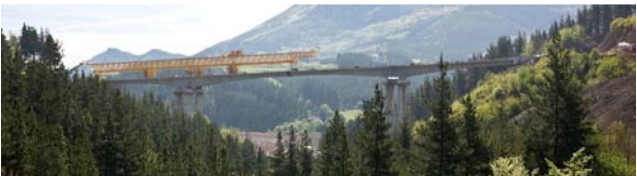
Fig. 16. Forma de la calzada derecha del viaducto de Uztarreta antes de la retirada del lanzador.
