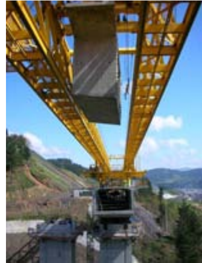
Fig. 15. Lanzamiento de dovela
