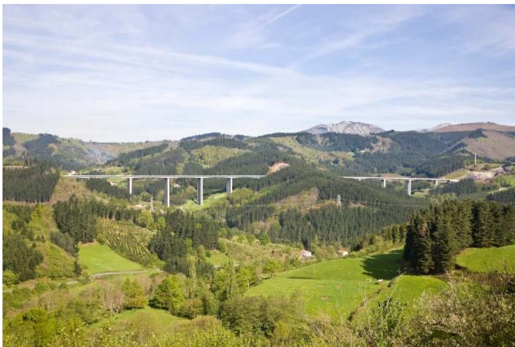
Fig. 1: Vista general de los viaductos de Marín y Zarimutz
