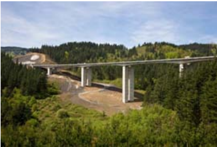
Fig. 6: Vista general del viaducto de Zarimutz
