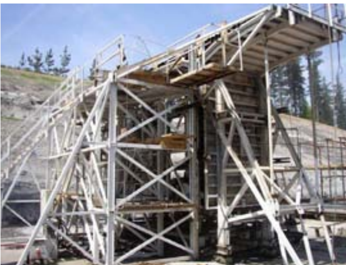
Fig. 10. Molde de hormigonado
