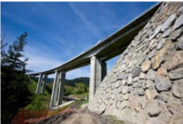
Fig. 4: Vista general del viaducto de Mazmela
