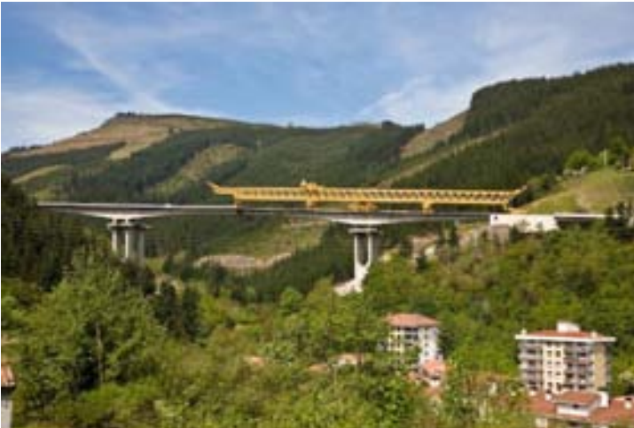
Fig. 8. Vista general del viaducto de Uztarreta
