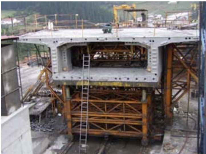
Fig. 12. Control geométrico de dovela recién hormigonada
