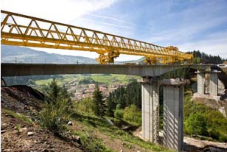
Fig. 14. Ejecución del viaducto de Uztarreta
