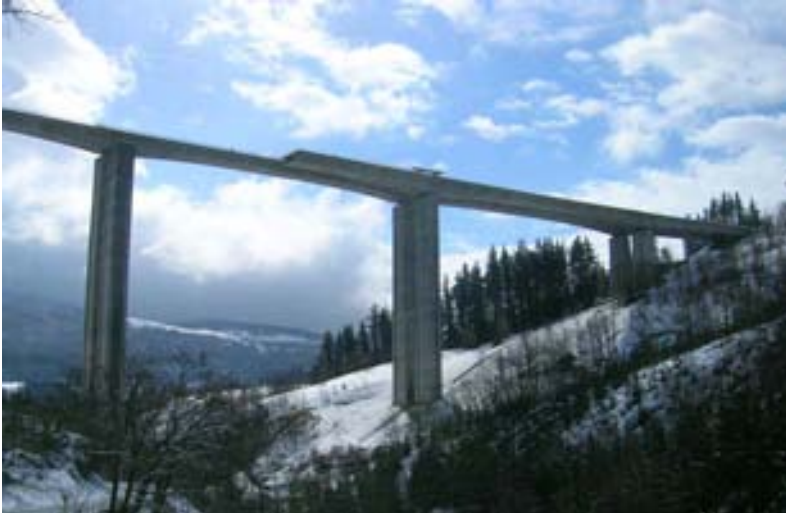
Fig. 2: Vista general del viaducto de Marín
