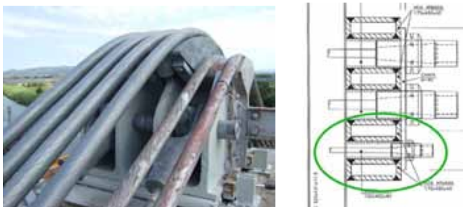
Fig. 18: Cables nuevos y antiguos sobre la silla y 2ª fase de rehabilitación del emparrillado
