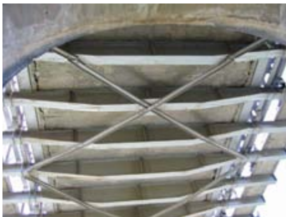
Foto 1. Vigas metálicas transversales arriostradas por perfiles oblicuos
