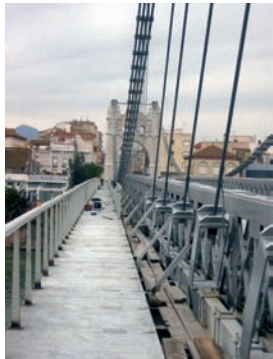
Figura 26. Nuevos tirantes y sus terminales. Figure 26. New stays and terminals.
