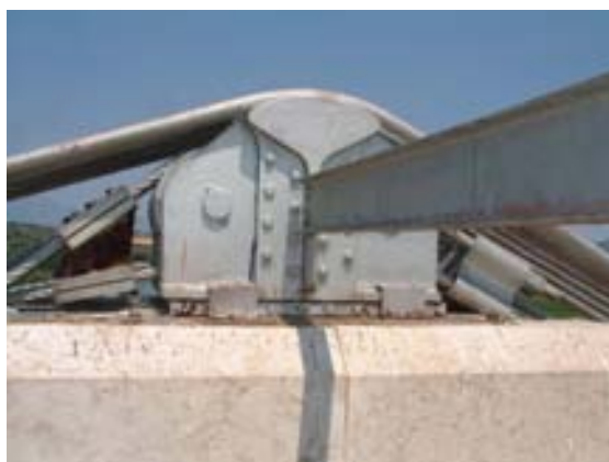
Foto 6 v 7. Detalle sillas sobre pilonos
