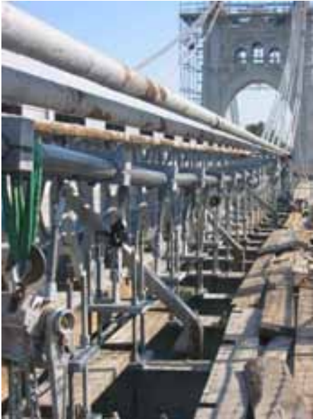
Fig 16 y 17: Vista de cables principales nuevos y péndolas de barra nuevas centrales
