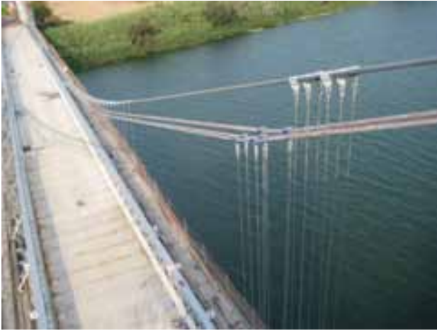
Fig 19: Vista de péndolas provisionales largas nuevas y antiguas
