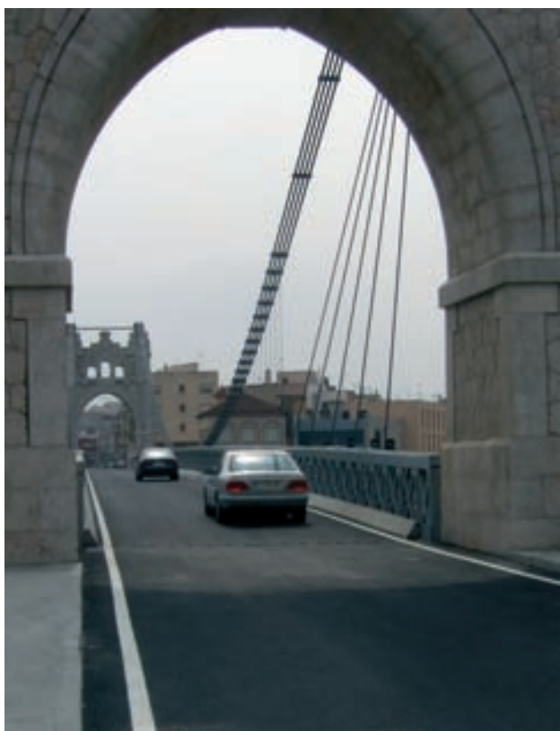
Figura 39. Tablero terminado. Figure 39. Finished deck.
