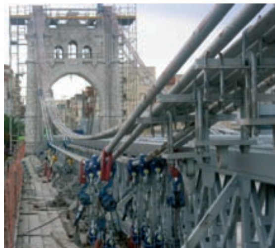
Figura 14. Retirada de péndolas con eslingas y polipastos.
