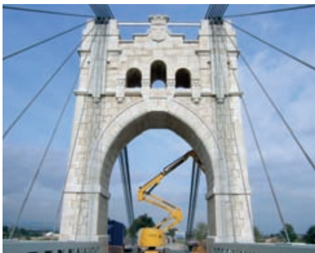
Figura 34. Pilono una vez rehabilitado. Figure 34. Rehabilitated pier.
