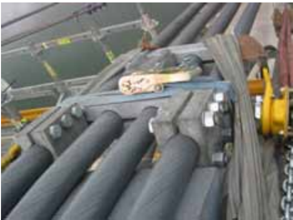
Fig 14: Sistema antideslizamiento de cables en sillas
