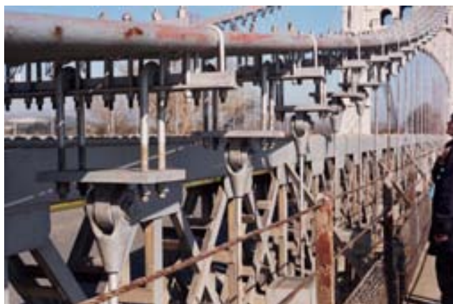
Foto 15. Detalle sujeción péndolas a cables
