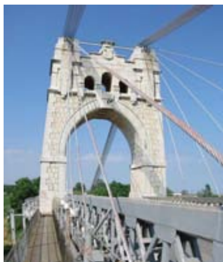
Foto 4. Tirantes inclinados que parten de cada pilono, transmitiendo la carga del tablero
