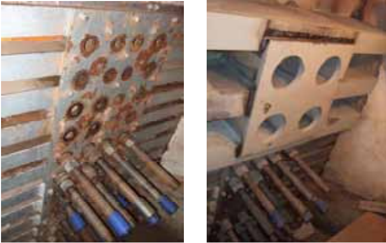
Fig. 12: Rehabilitación de emparrillado de anclaje
