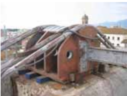
Figs 11, 12 y 13: Trabajos de rehabilitación de sillas
