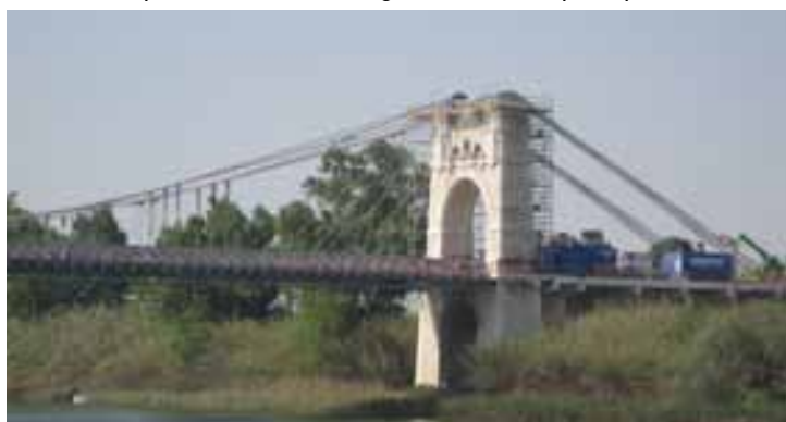
Fig. 1 Vista general de pilonos, cables principales, péndolas, tirantes y retenidas.
