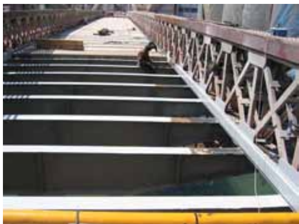
Fig. 2 Refuerzo de estructura metálica y sustitución de losa de calzada
