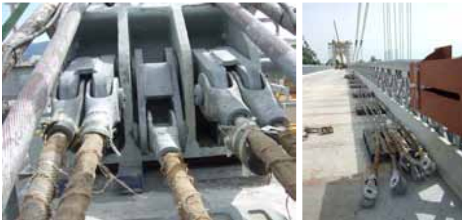
Fig. 13: Instalación de 5 tirantes nuevos
