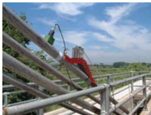
Foto 10. Ensayo de cuerda vibrante en tirantes
