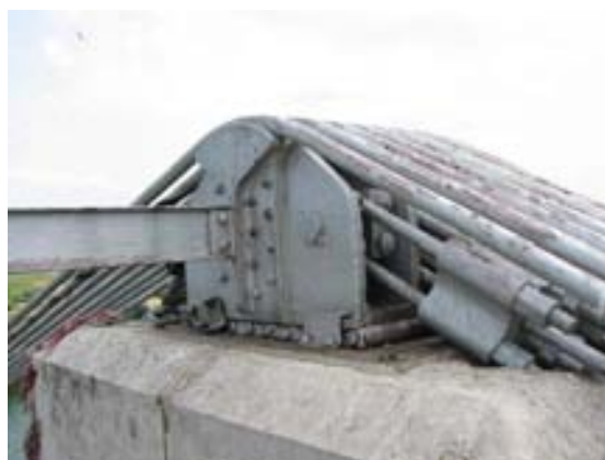
Foto 6 v 7. Detalle sillas sobre pilonos
