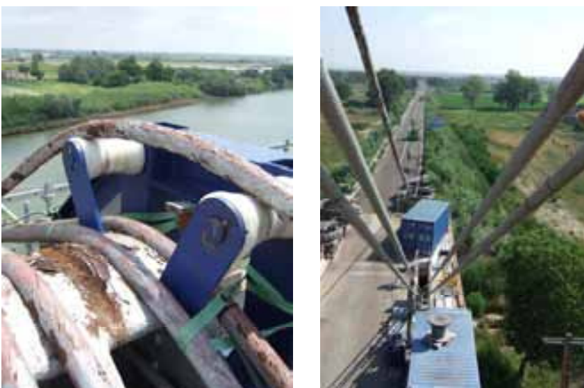
Fig. 9: Estación de poleas y retirada de cable principal
