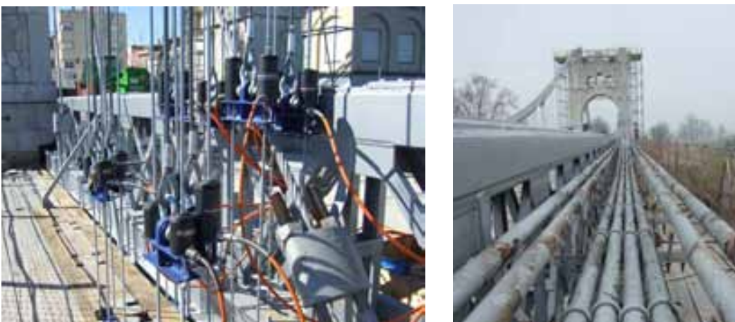
Fig. 5: Transferencia de carga al sistema provisional
