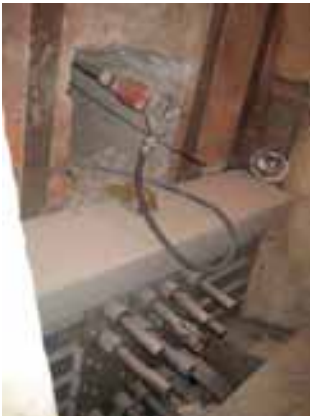
Figs 9 y 10: Trabajos de rehabilitación de emparrillados de anclaje
