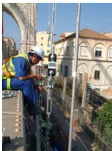
Foto 8. Ensayos sobre péndolas
