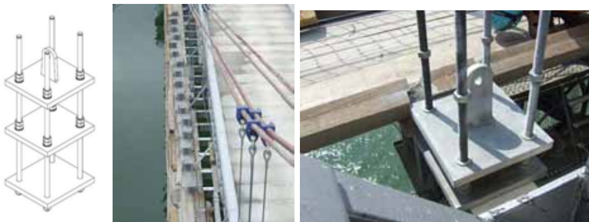
Fig. 11: Instalación de conexiones de péndolas nuevas
