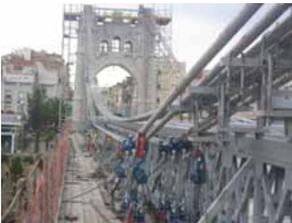
Figs. 4 y 5: Distintas vistas del puente durante la transferencia de carga a los cables antiguos exteriores
