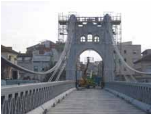
Fig 15: Vista de cables principales nuevos a peso propio
