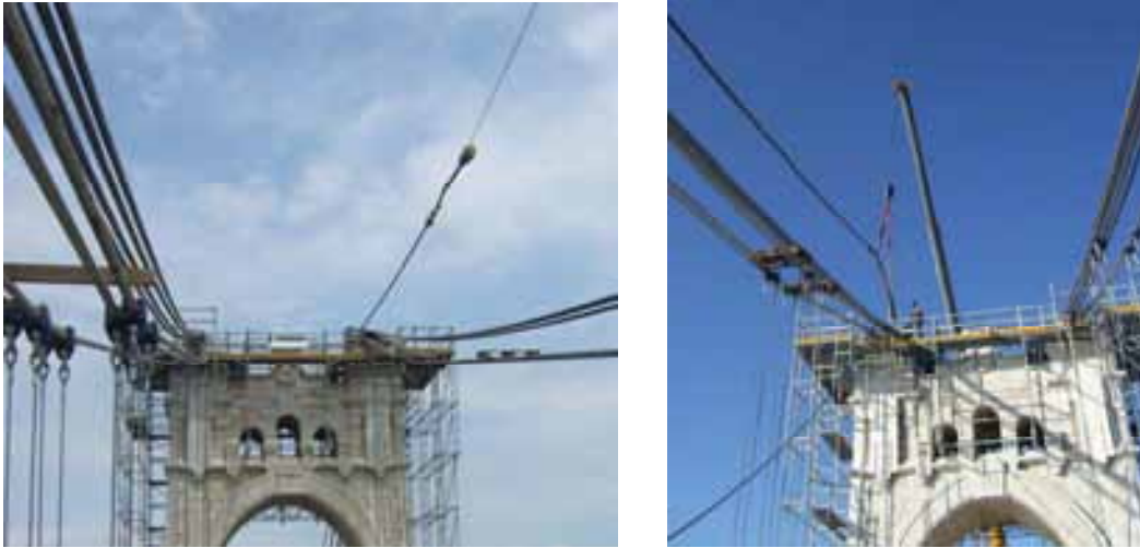
Fig. 15: Instalación del cable principal nuevo
