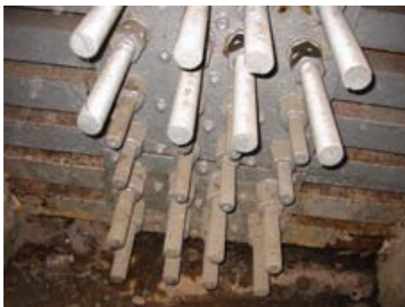
Foto 5. Emparrillado de perfiles metálicos y placa de reparto
