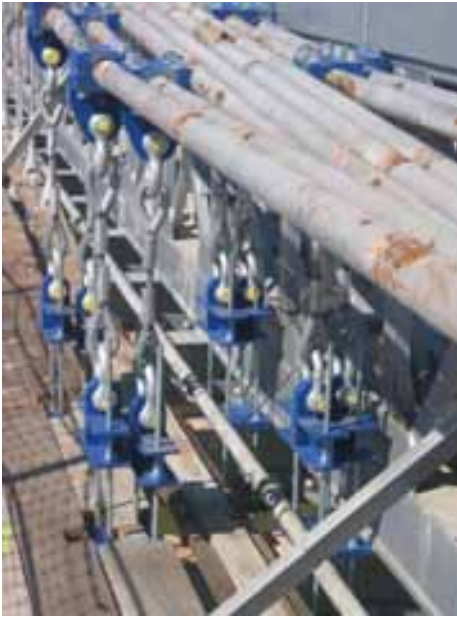
Figs. 3: Detalle de péndolas de transferencia
