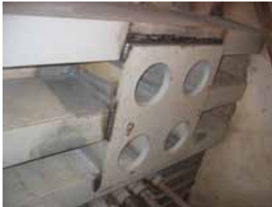
Figs 9 y 10: Trabajos de rehabilitación de emparrillados de anclaje
