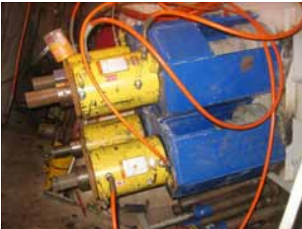
Fig 18: Vista de gatos para ajustes de cargas en cables principales desde cámara de anclajes
