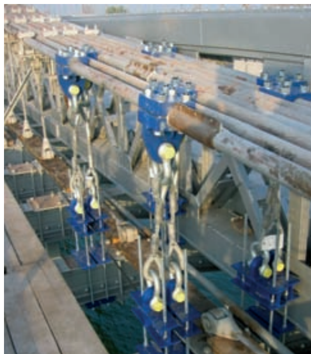
Figura 8. Péndolas provisionales cortas. Figure 8. Provisional short suspenders.
