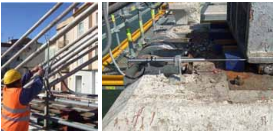
Fig. 3: Instalación del sistema de instrumentación y sensor de desplazamiento
