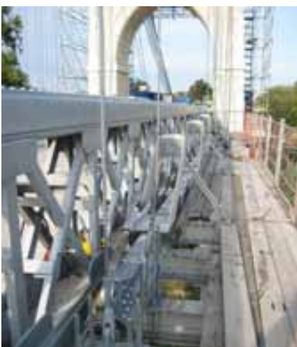
Fig 20 y 21: Nuevos terminales de tirantes y de cable horizontal
