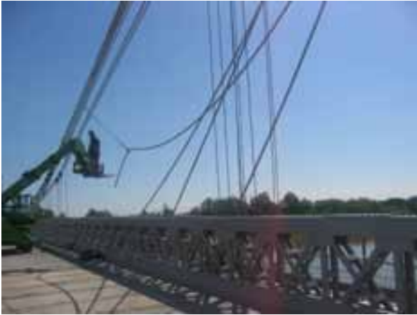
Figs. 6 y 7: Retirada de tirantes y actuación en cámara de anclajes
