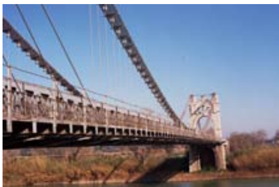
Foto 2. Vista general de péndolas y cables
