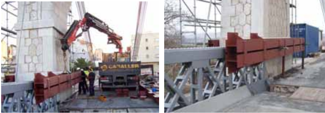
Fig. 2: Instalación de los arriostramientos provisionales
