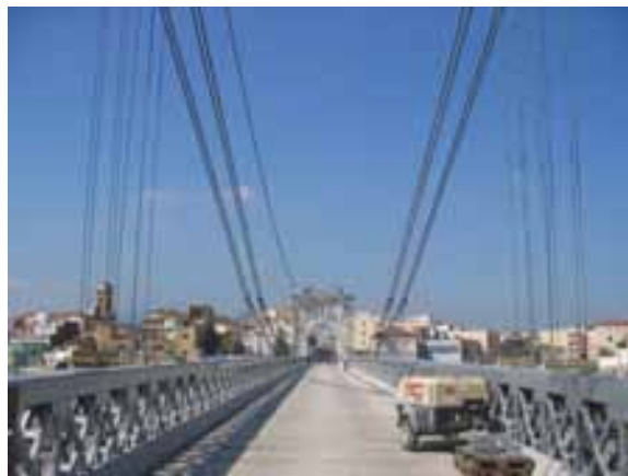
Figs. 4 y 5: Distintas vistas del puente durante la transferencia de carga a los cables antiguos exteriores
