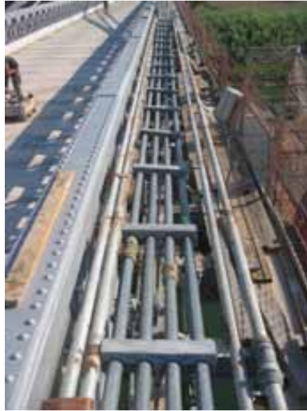
Fig 16 y 17: Vista de cables principales nuevos y péndolas de barra nuevas centrales
