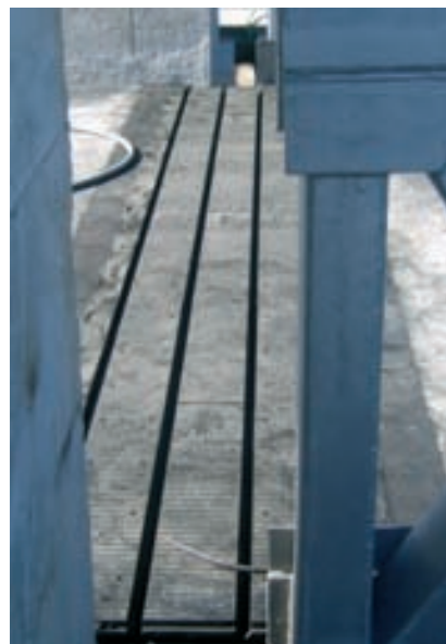
Figura 37. Junta de la calzada. Figure 37. Carriageway joint.
