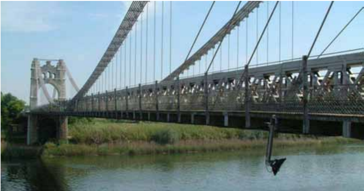
Fig. 1: Vista general del puente colgante
