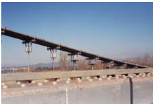
Foto 3. Detalle superior sujeción péndolas
