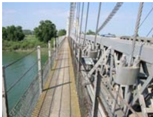
Foto 12. Aceras y unión péndolas-tablero
