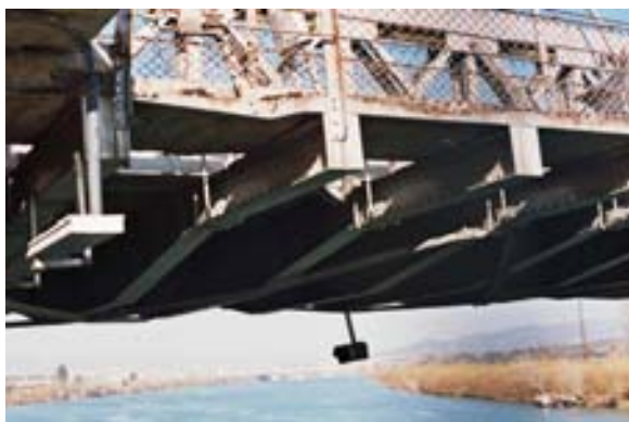
Foto 11. Detalle vista inferior del puente
