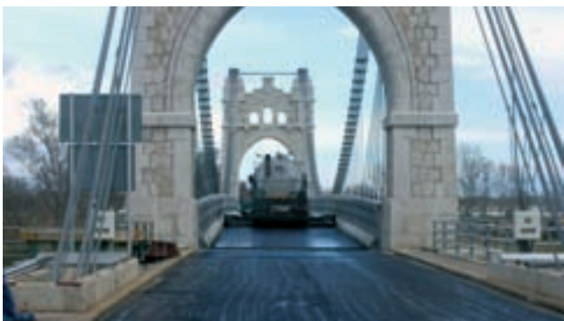
Figura 35. Trabajos de pavimentación. Figure 35. Paving operations.
