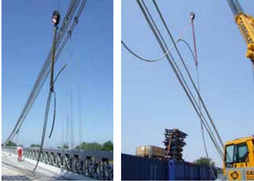
Fig. 7: Retirada de tirantes y extracción del extremo de cable principal
