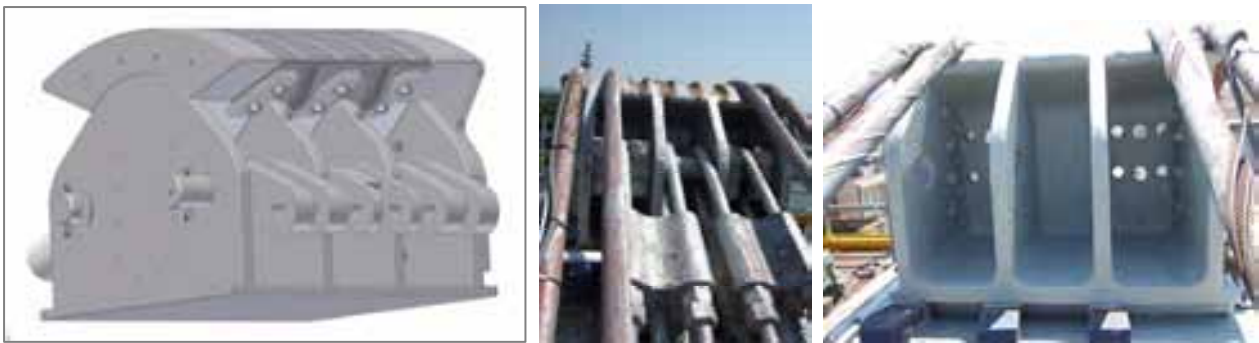
Fig. 10: Rehabilitación de la silla
