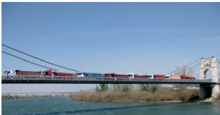
Figura 38. Prueba de carga. Figure 38. Load test.
