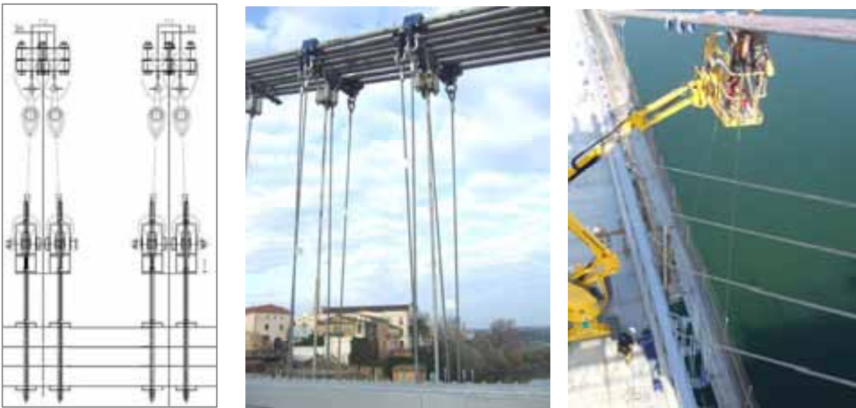
Fig. 4: Instalación de péndola provisional
