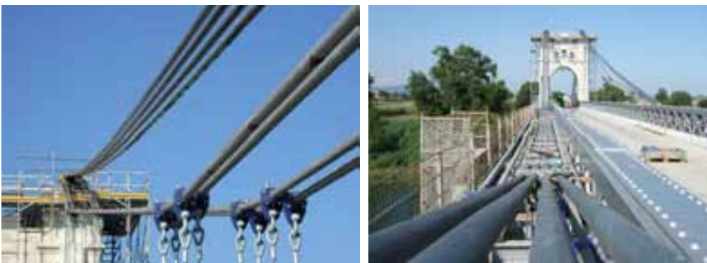
Fig. 16: Sistema de cables nuevo y provisional. Ensamblaje de péndolas nuevas
