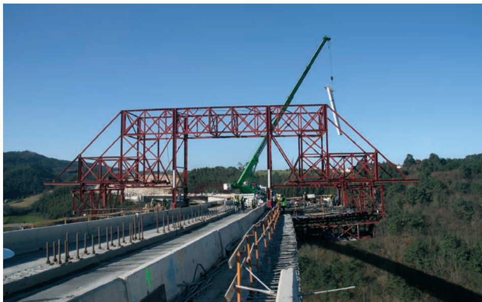
Figura 38. Carro n° 3 y colocación de un nuevo jabalcón Figure 38. Movable scaffolding n. 3 assembling a steel strut
