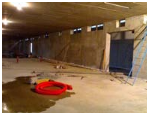
Fig. 15 Versatilidad de la losa ante la apertura de huecos en su borde apoyado en un muro
