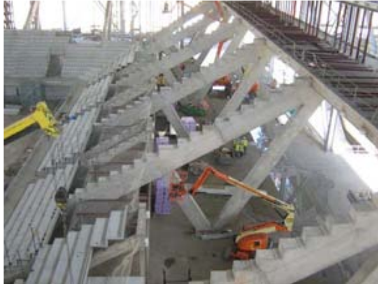
Fig. 3. Graderío este, pórticos tipo
