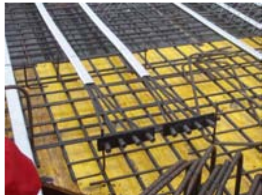
Fig. 9 Detalle anclaje pasivo
