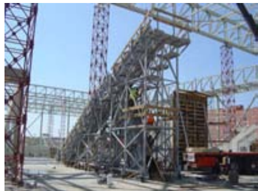
Fig. 23 Encofrado de primera fase de pórtico tipo
