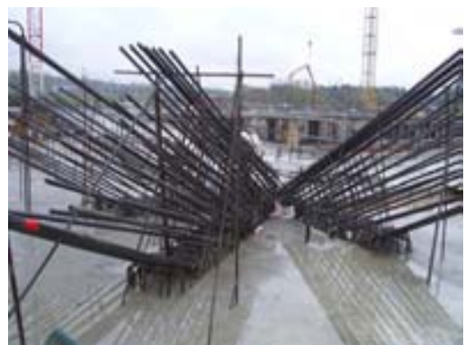
Fig. 11 Detalle arranque de pórticos tras el hormigonado
