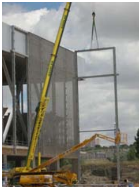
Fig. 9. Montaje de un módulo de estructura de malla
