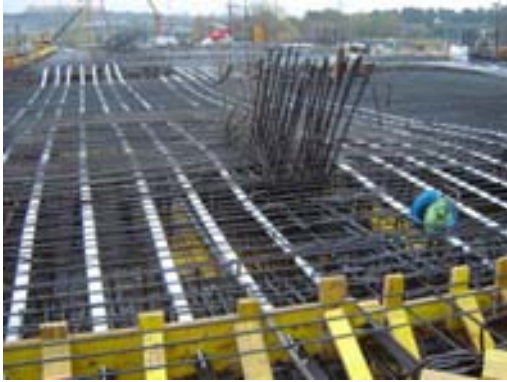
Fig. 6 Armado de losa nivel 571.20
