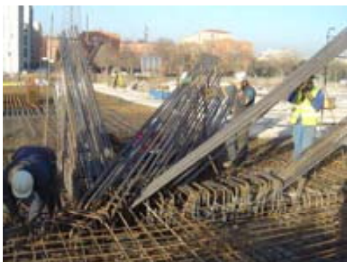
Fig. 10 Detalle arranque de pórticos antes de hormigonar
