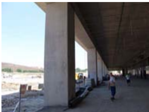
Fig. 14 El techo plano sin vigas descolgadas facilita el montaje de instalaciones
