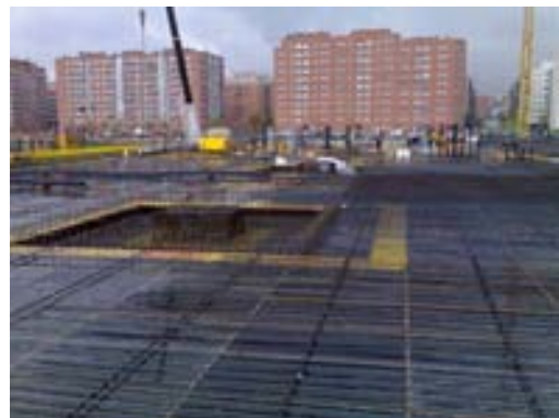
Fig. 5 Ferrallado de los ábacos
