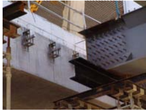
Fig. 3 Junta entre estadio 1 y pasarela
