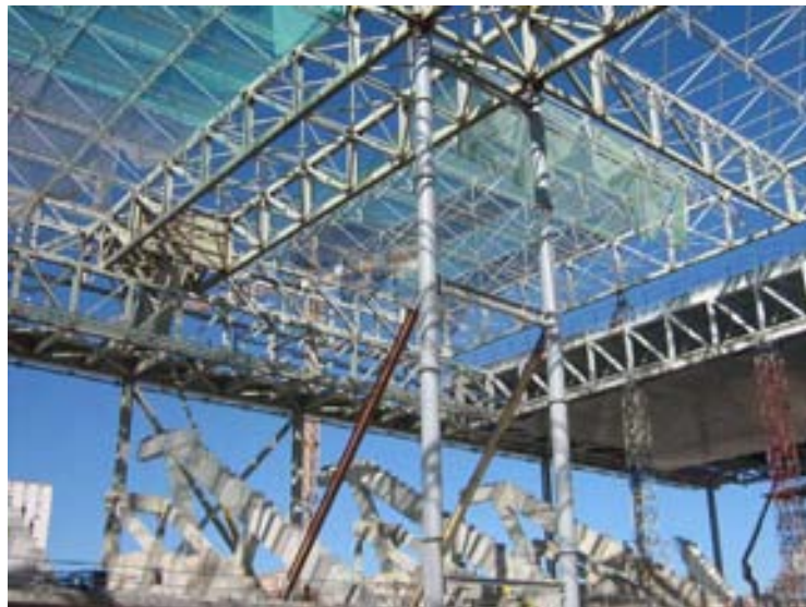
Fig. 8. Montaje de la estructura de la Cubierta Móvil 1.
