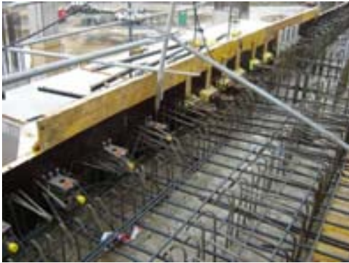
Fig. 2 Junta entre estadio 1 y estadios 2 y 3
