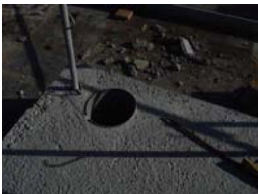
Fig. 12 Hueco para instalaciones ejecutado a posteriori
