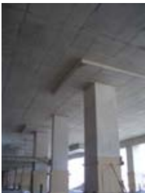
Fig. 4 Vista de los ábacos terminados
