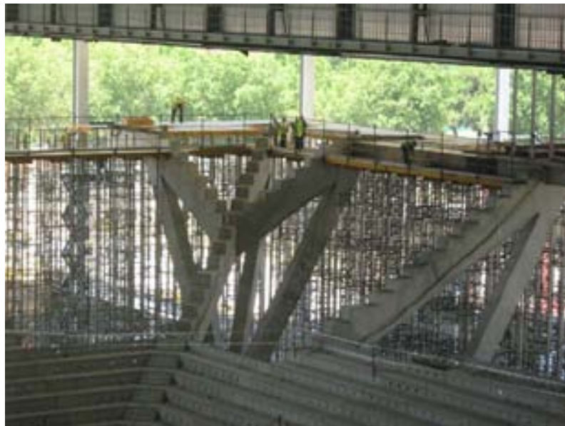
Fig. 6. Cimbra en altura para losa postesada de Sky-Lounge
