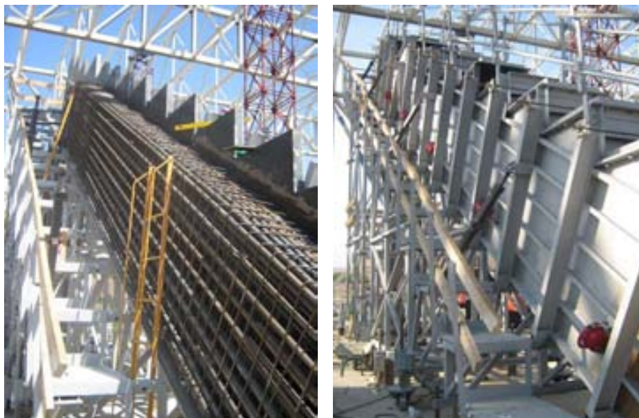
Fig. 4. Armado y encofrado de pórtico tipo
