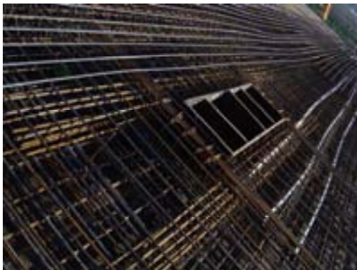
Fig. 8 Pretensado en zona de losa con huecos
