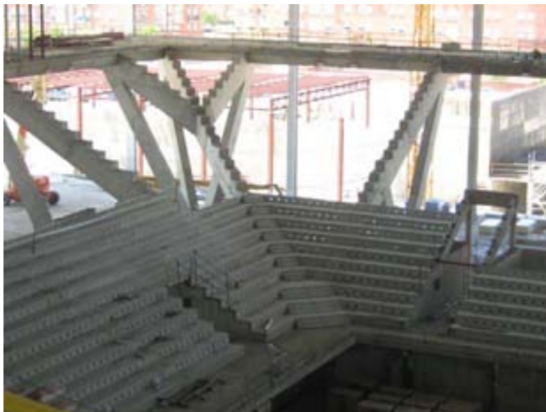
Fig. 5. Vista general de graderío, pórticos de esquina y losa de Sky-Lounge
