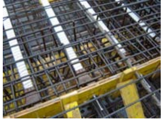
Fig. 7 Detalle acopladores de pretensado
