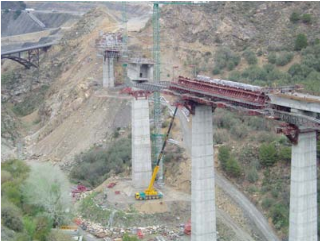
Fig. 7 Vista de la autocimbra durante la construcción de la última fase
