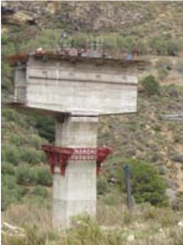
Fig. 8 Dovela inicial de 16.0 m sobre la pila 2 (izquierda) y fase final de la construcción por voladizos en la pila 1 (derecha)
