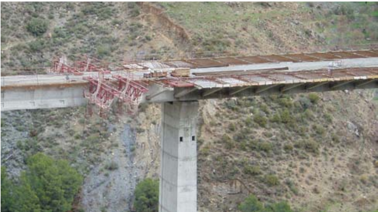
Fig. 11 Proceso de colocación de jabalcones, prelosas y ferralla de los voladizos laterales del tablero
