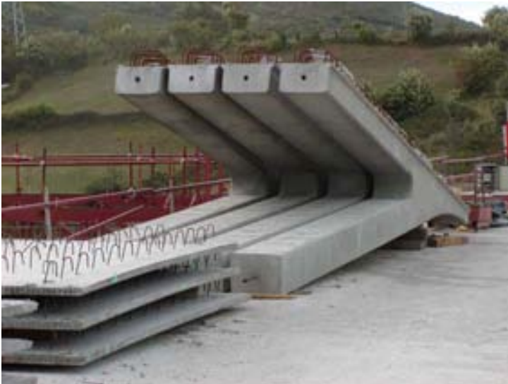
Fig. 10 Jabalcones y prelosas prefabricados
