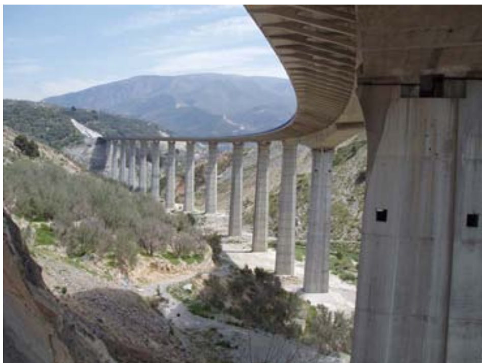
Fig. 1 Vista general del viaducto desde el estribo 1
