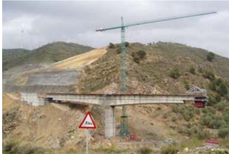
Fig. 8 Dovela inicial de 16.0 m sobre la pila 2 (izquierda) y fase final de la construcción por voladizos en la pila 1 (derecha)
