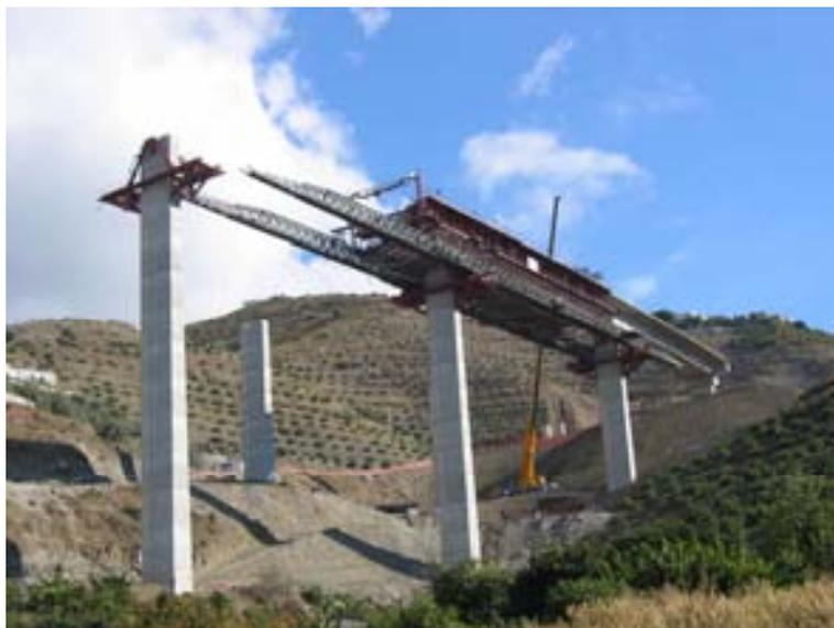
**Figura 8. Vista del proceso constructivo del tablero**
