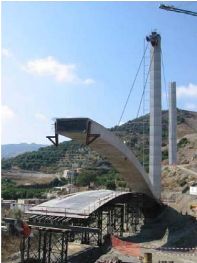
**Figura 5. Vista del izado de un semiarco**
