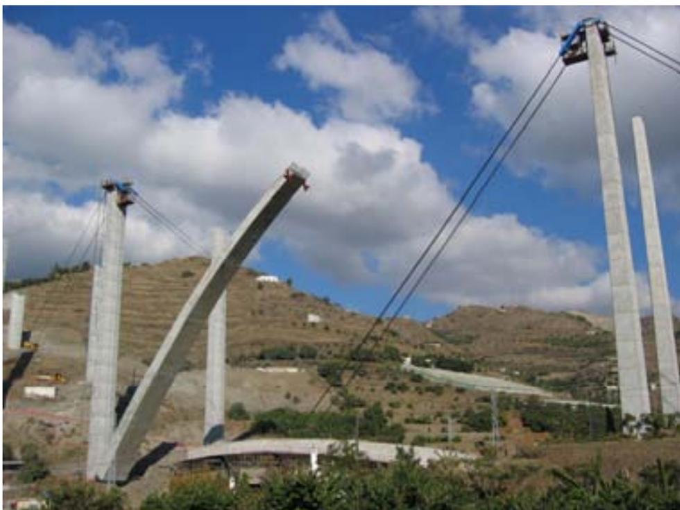
**Figura 6. Vista del proceso de izado del segundo semiarco**
