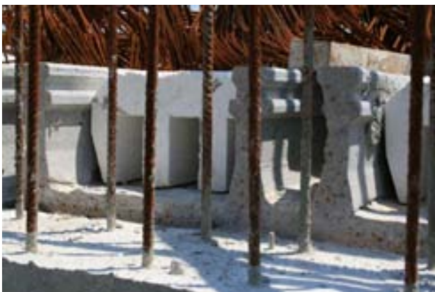
Fig.15: Vista de prelosas prefabricada pretensada con aligeramiento interior.
