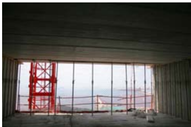
Fig.16: Vista de prelosas prefabricadas y ferralla superior de losa Fig. 17: Vista de prelosas entre dos pantallas situadas a 9 m
