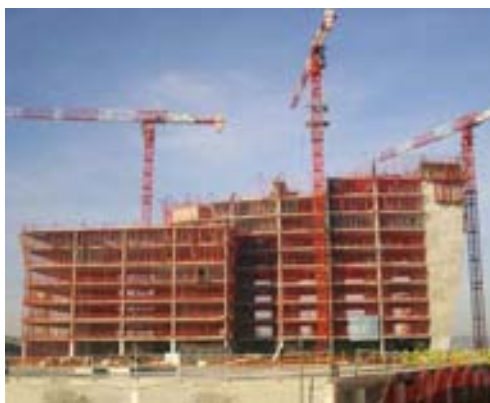
Figs.14a y 14 b: Vista del Atrio concluido y la Torre en ejecución
