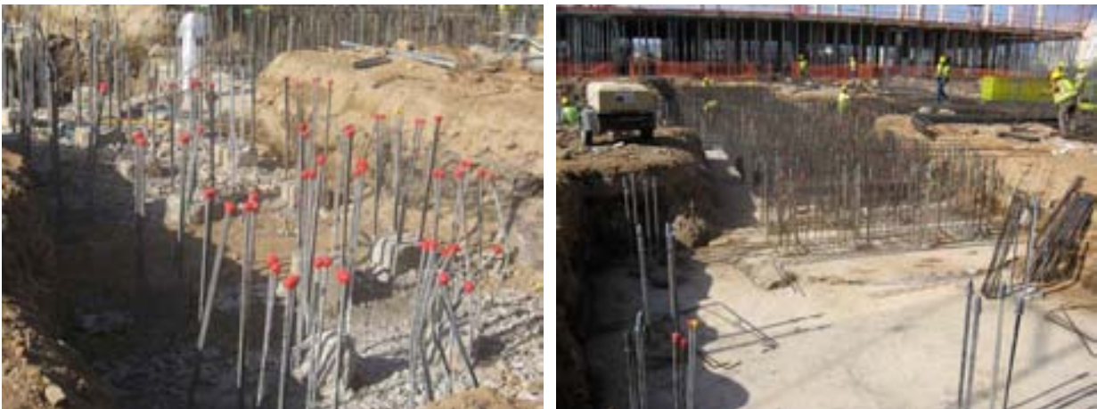
Figs. 8a y 8b: Vista de pilotes prefabricados hincados y encepados de la Torre durante su ejecución
