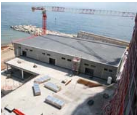
Fig.13: Vista del Podium y cubierta del Ballroom
