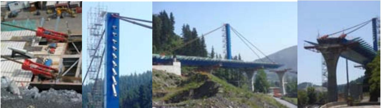
*Anclaje activo tirantes provisionales – Anclaje pasivo – Tablero llegando a P3 – Tablero en P3 (empuje desde estribo 1)*
