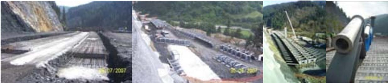
*Playa de empuje E1, cimentación zapatas de empuje - Montaje de tablero - Primer tramo de torre - Anclaje de tirante*
