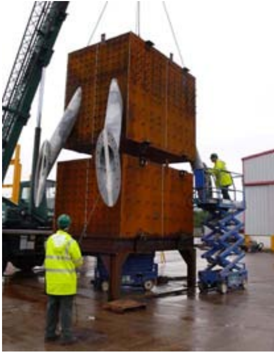
Fig.5. Montaje en blanco de dos segmentos del cajón metálico del mástil
