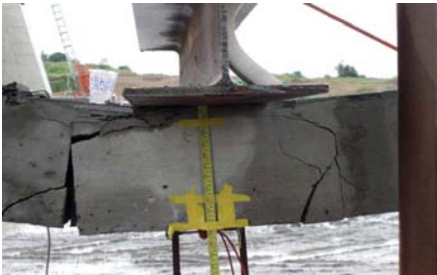
Fig.14. Losas prefabricadas: situación al final del ensayo
