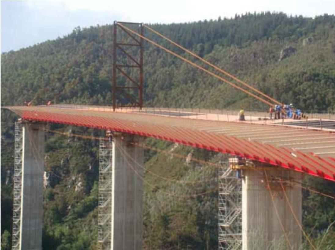
*Fig. 11 Vista de la torre y cables de atirantamiento*
