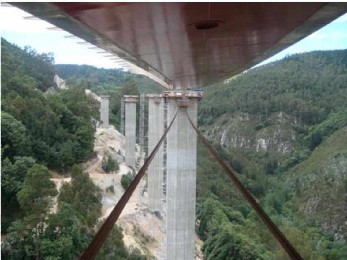
Fig. 8 Banda de inoxidable y arriostramiento entre pilas
