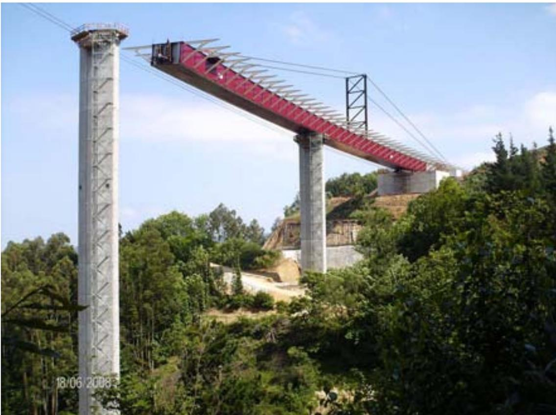
*Fig. 14 Punta de avance llegando a pila 2*
