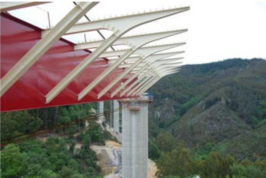
*Fig. 4 Jabalcones y dintel metálicos*
