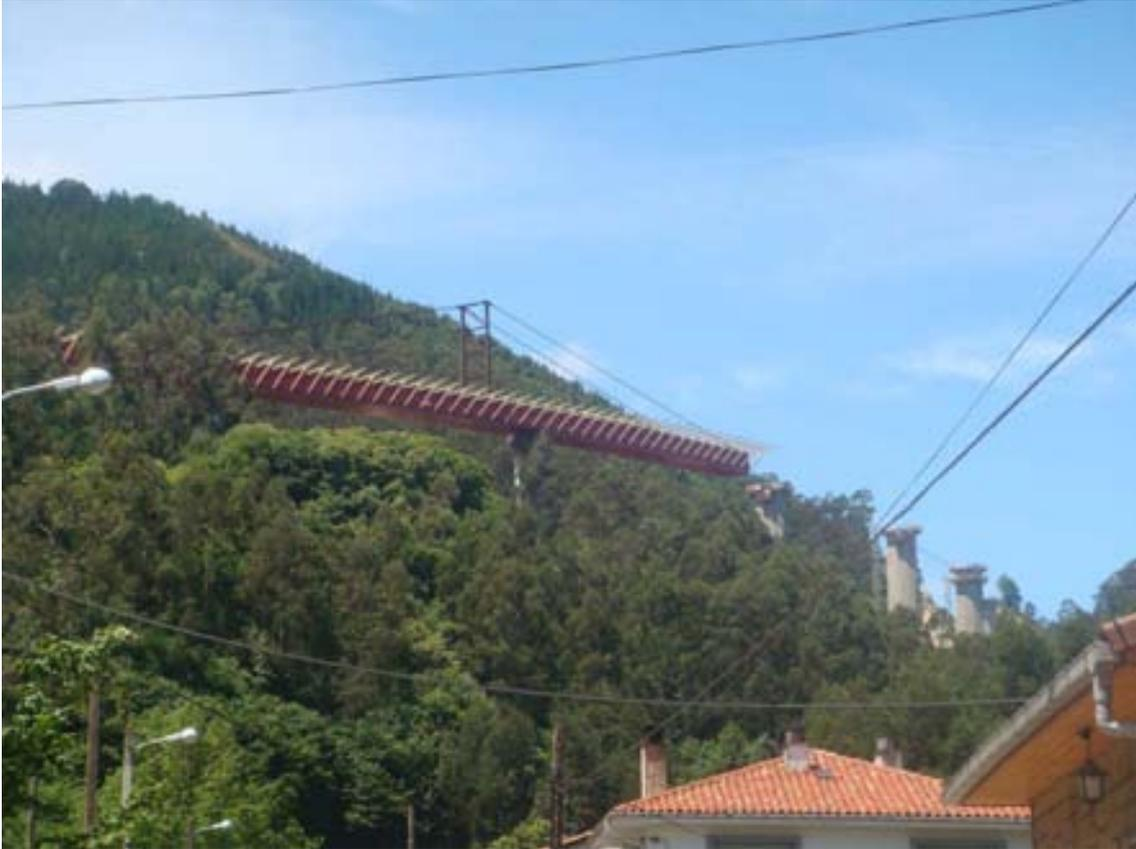
*Fig. 15 Punta de avance llegando a pila 3*
