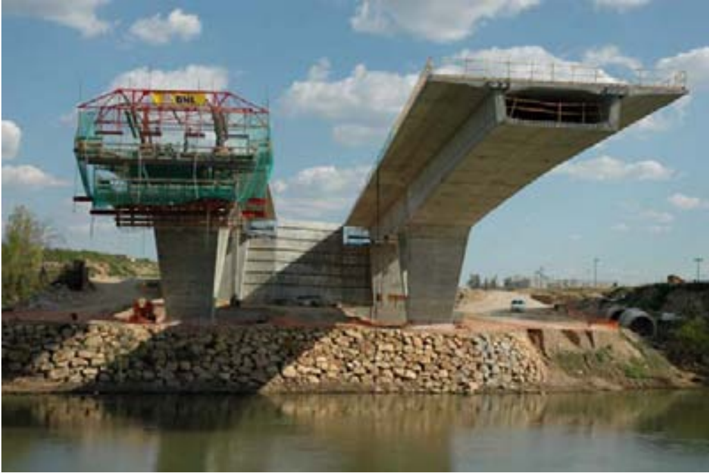
Fig. 7 Vista en sección del puente en construcción
