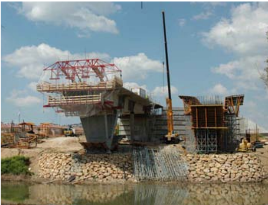
Fig. 6 Construcción de vano lateral con cimbra y vano central con carros
