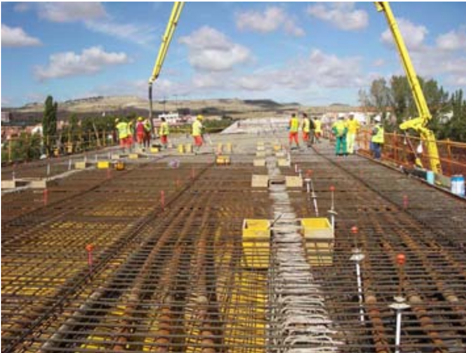
Fig. 5 Hormigonado vano lateral. Cajeados para enfilado de tendones
