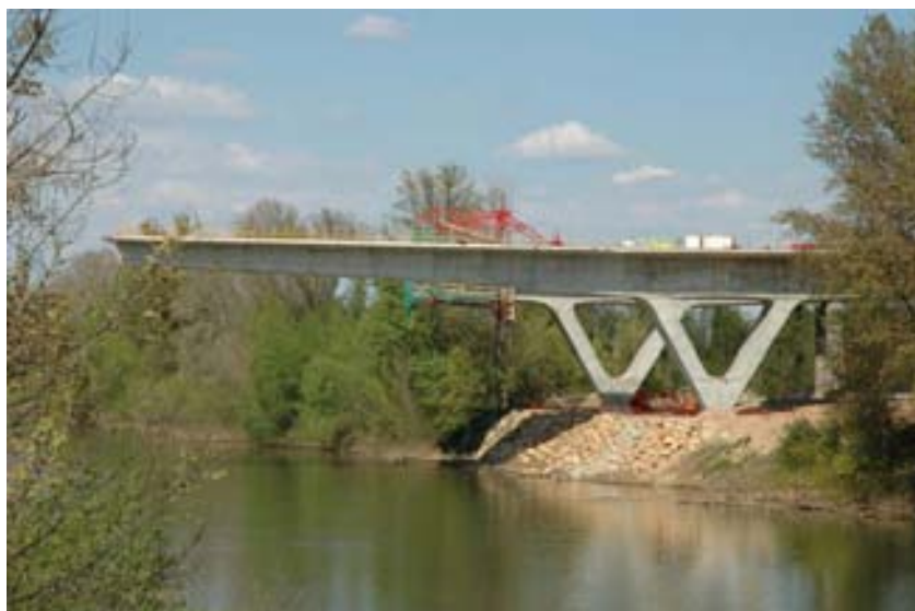
Fig. 1 Vista en alzado del puente en construcción
