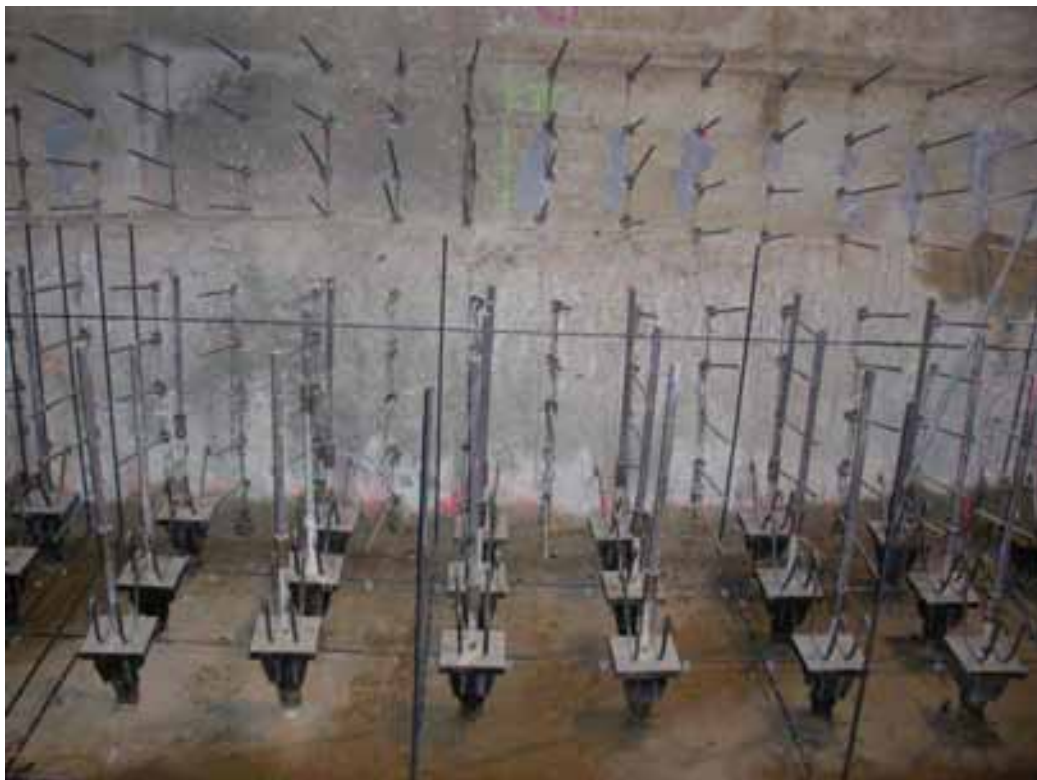
Figura 10 – Ampliación de la cimentación existente
