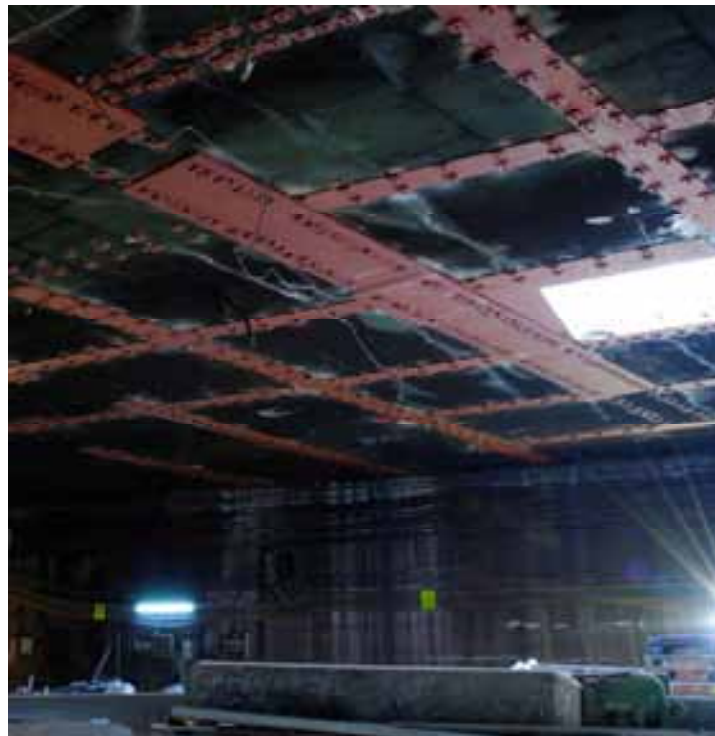
Figura 5 – Disposición de refuerzos a flexión y de cortante de los nervios
