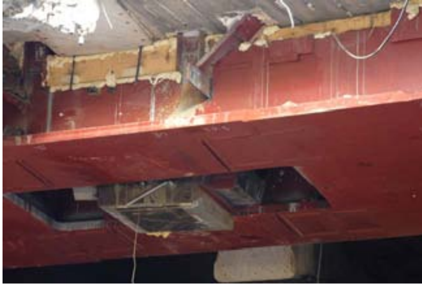
Figura 11 – Detalle del corte del soporte apeado
