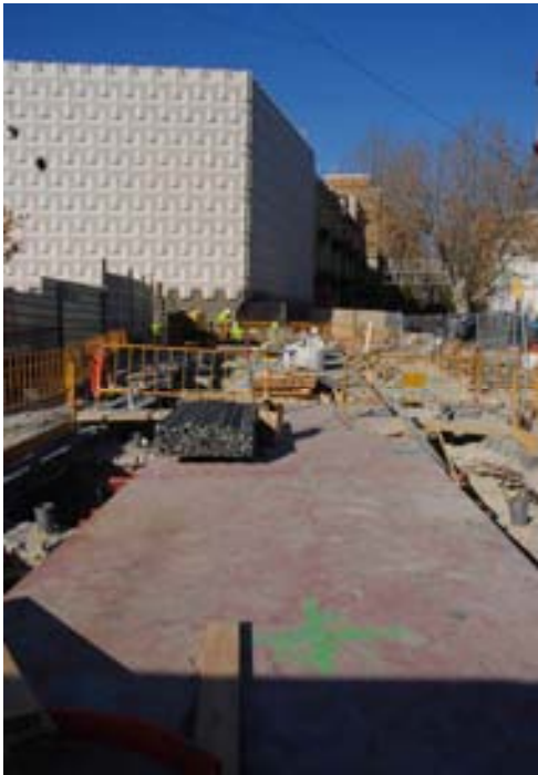
Figura 8 – Vista del cordón superior a nivel de calle
