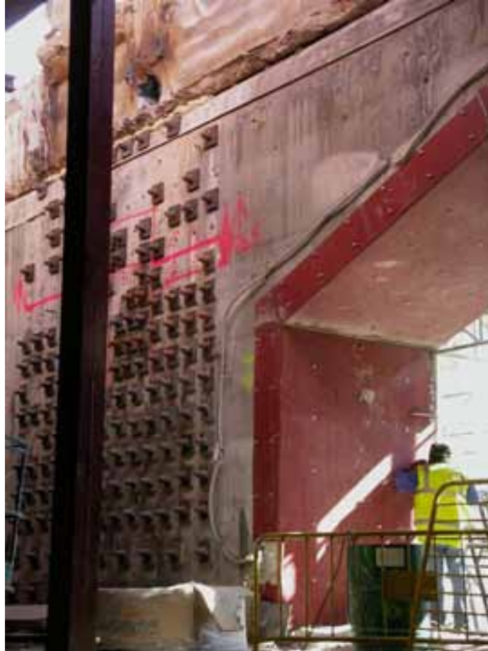
Figura 8 – Zunchado del muro M7 en ejecución
