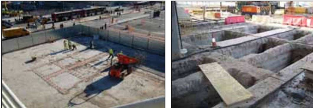
Fig. 9. Refuerzos de nervios y demolición de la capa superior de la losa y colocación de plantillas para la ejecución de los taladros
