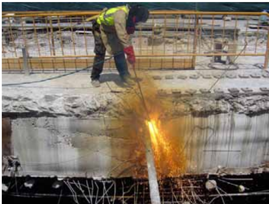
Figura 6 – Fase de corte de cables de postesado
