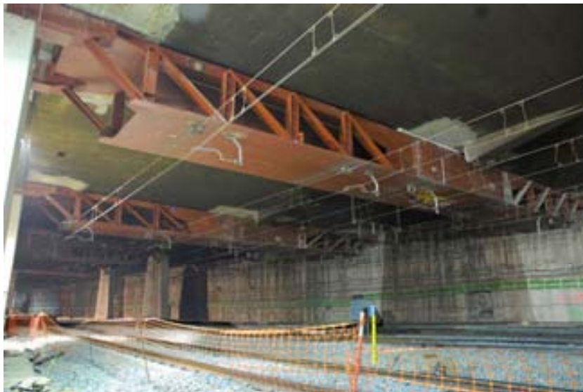
Figura 13 – Dinteles C a F: vista general
