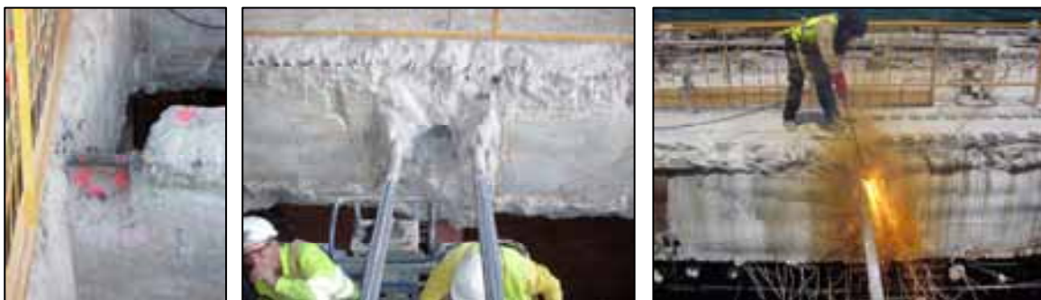
Fig. 9 Varios momentos del proceso de corte de los nervios y tendones
