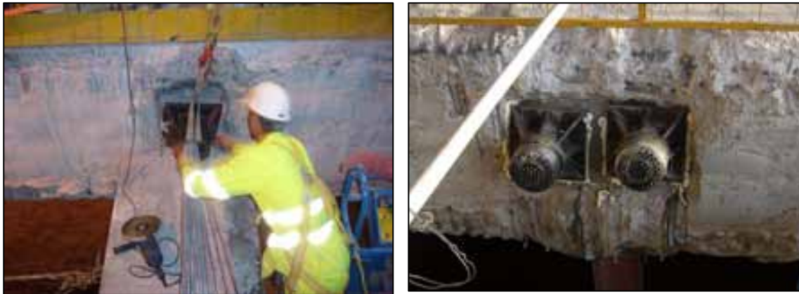
Fig. 11 Colocación de cabezas de retesado
