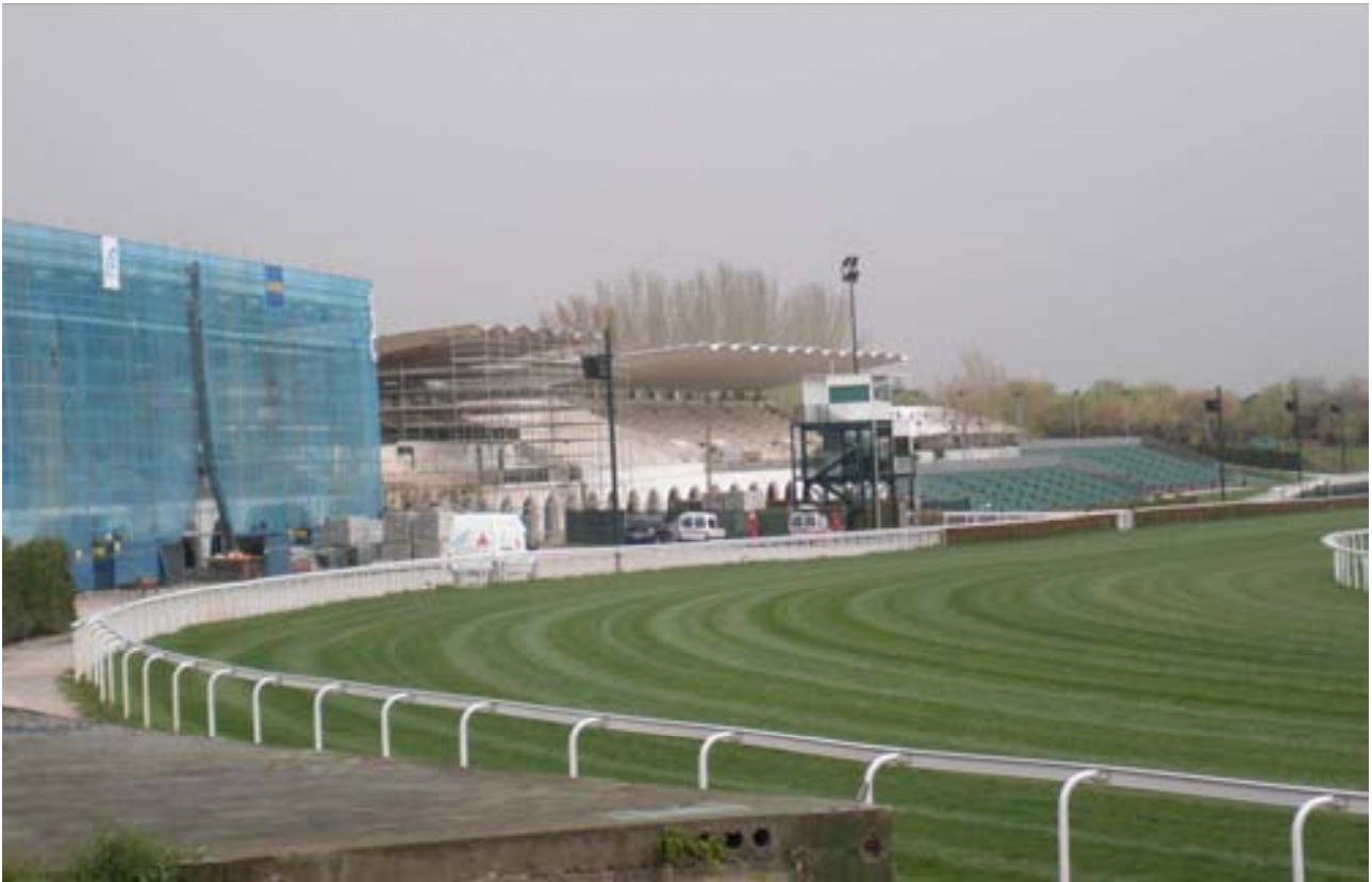
Fig. 11 Vista de las tres tribunas. Tribuna sur en en obras, central sin empezar y norte finalizada
