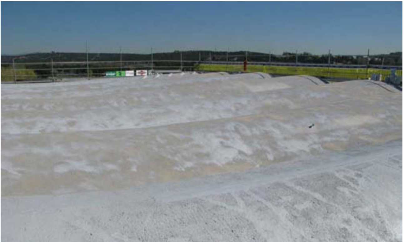
Fig. 9 Estado de la cubierta durante la ejecución de la impermeabilización de poliuretano
