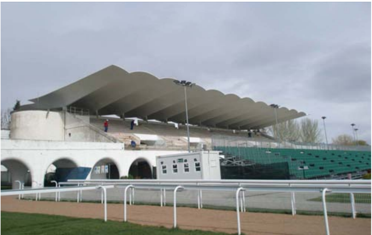
Fig. 12 Vista de la cubierta de la tribuna norte
