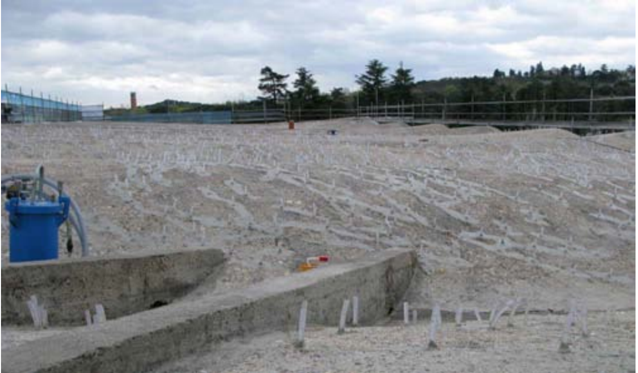
Fig. 8 Cánulas en la parte superior de la cubierta para la inyección de las fisuras
