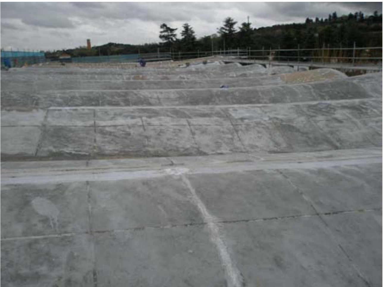
Fig. 10 Juntas en la parte superior de la cubierta
