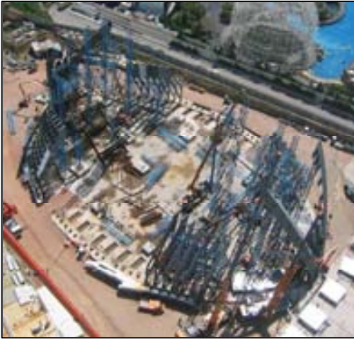
Fig. 5 Estado de la obra en Junio 2008
