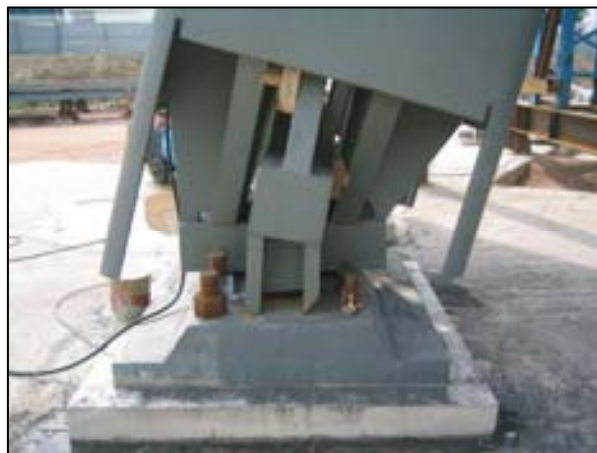
Fig. 7 Apoyo sobre rótula esférica del arranque de arcos. Dibujo y pieza montada.
