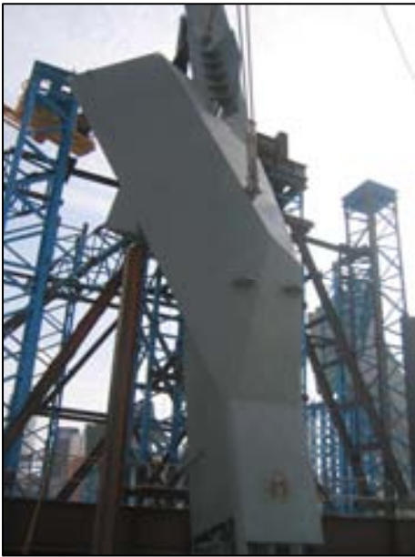
Fig. 6 Montaje de uno de los 4 arranques de arcos
