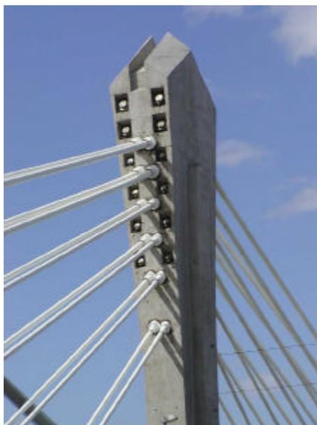
*Ilustración 6.- Disposición de tirantes en torre*
