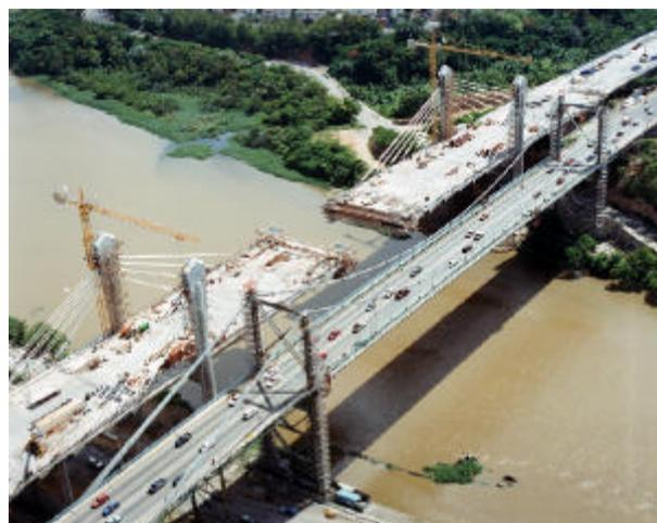
*Ilustración 3.- Construcción del vano central*
