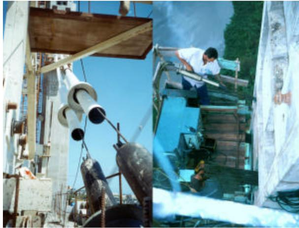
*Ilustración 10.- Enfilado y tesado unifilar*
