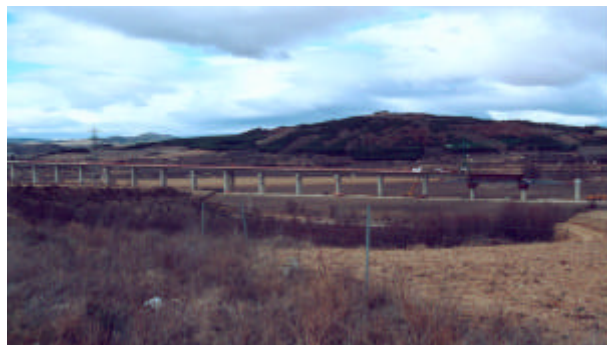
Fig. 1: Alzado del viaducto en construcción
