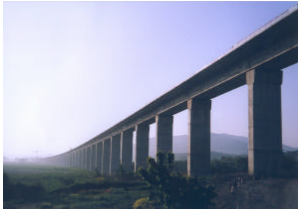
Viaducto sobre el río Jalón
