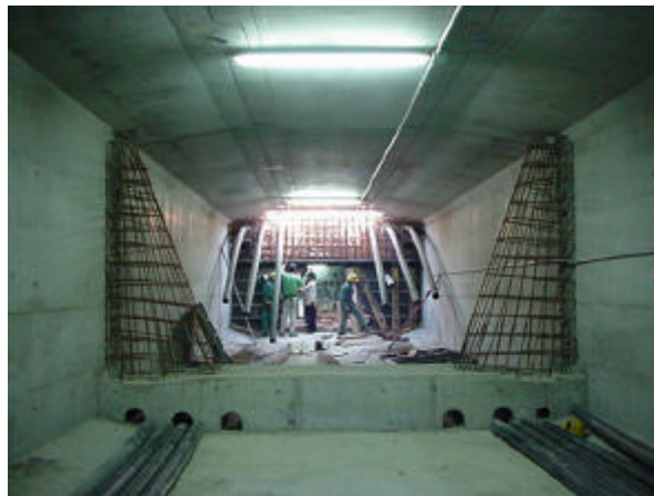
Fig 9: Desviadores de pretensado exterior y mamparo de pila durante la construcción
