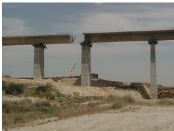
Fig 8: Empuje tramo vano inerte sin nariz
