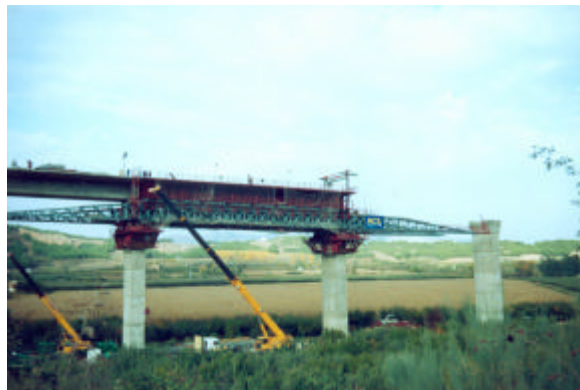
Fig. 5: Autocimbra para la construcción de los vanos isostáticos
