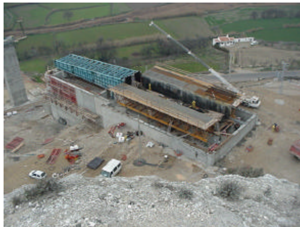
Fig 10: Estribo 2 inicio del empuje
