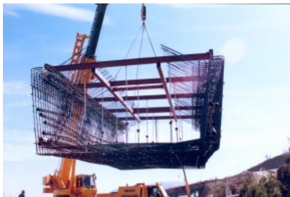
Fig. 3: Montaje de ferralla premontada de vano isostático
