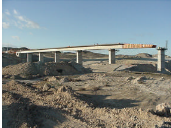
Fig 7: Vista tramo 1 durante el empuje
