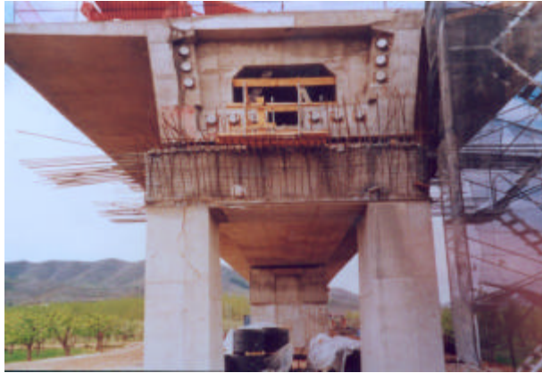
Fig. 2: Vista desde estribo 2
