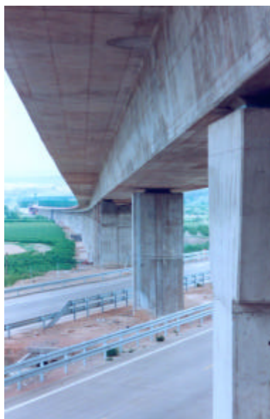
Fig. 4: Vista desde el estribo 1. Viaducto sobre N-II
