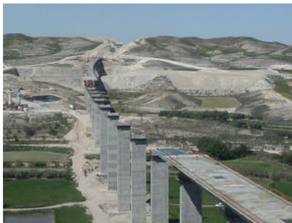
Fig. 6: Vista general desde estribo 2 en construcción
