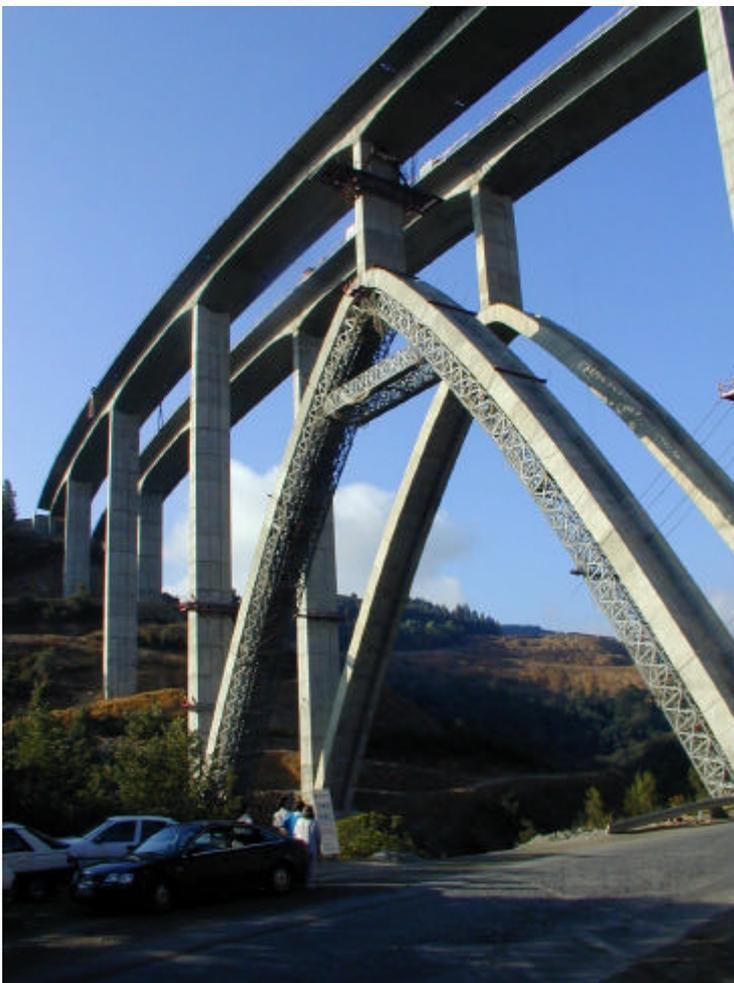
En el viaducto de Narón, los arcos se ejecutan sobre una cimbra, mediante el hormigonado de dovelas de 5 m de forma simétrica. La cimbra fue diseñada expresamente para la construcción de cada uno de estos arcos, teniendo en cuenta el proceso constructivo de los mismos y el proceso de desmontaje, una vez finalizada su construcción.
