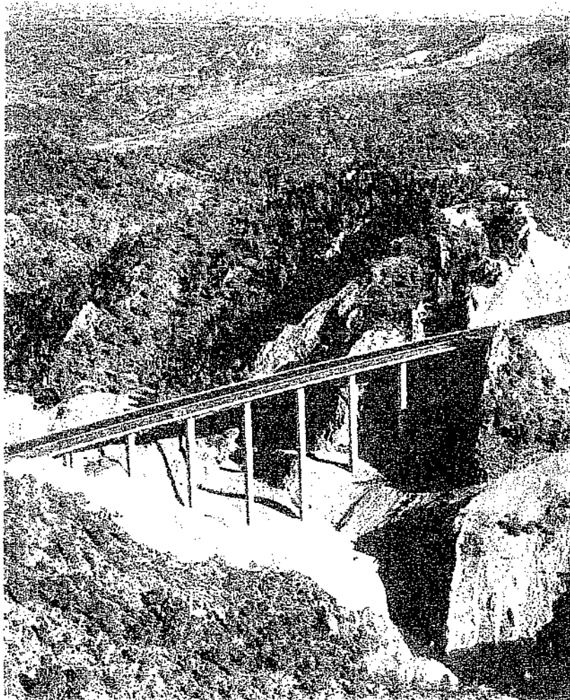
Viaducto del Barranco de la Vid
