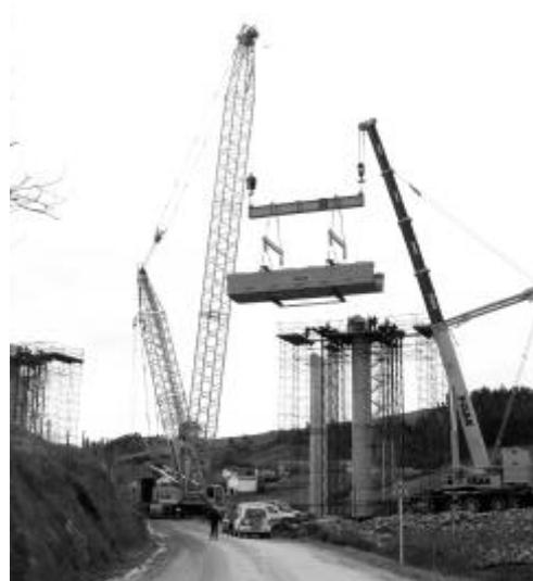
Se apoyaban provisionalmente sobre las torres de apeo tipo A-200 separadas 6.50 m, que llevaban en su coronación cuatro gatos hidráulicos de 150 Tn que recibieron el conjunto de viga + cuna + perfiles soporte de cunas. La posición de los gatos estaba perfectamente replanteada en planta y en alzado.
