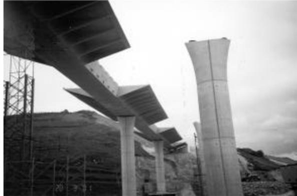
Por ello, el montaje de las células transversales (5.55 m de voladizo x 2.48 m de ancho) se realizó con grúa de 160 Tn, acoplándose a la viga mediante sus dos salientes que penetraban en las huellas impresas en ésta y efectuándose su fijación mediante dos barras Gewi de diámetro 25 mm, con sus respectivas tuercas y contratuercas. Las placas de encofrado perdido de 3.50 m x 1.25 m se montaron con grúas de 60 Tn.
