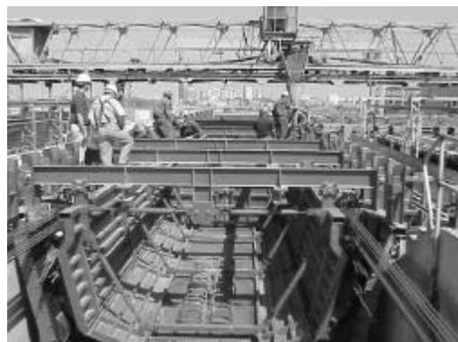
La holgura entre células era de 0,01 m, lo que exigió un diseño muy delicado de todos los encofrados para evitar que cualquier error superior a 1 cm en las dimensiones de las piezas influyese negativamente en los trabajos de montaje.
