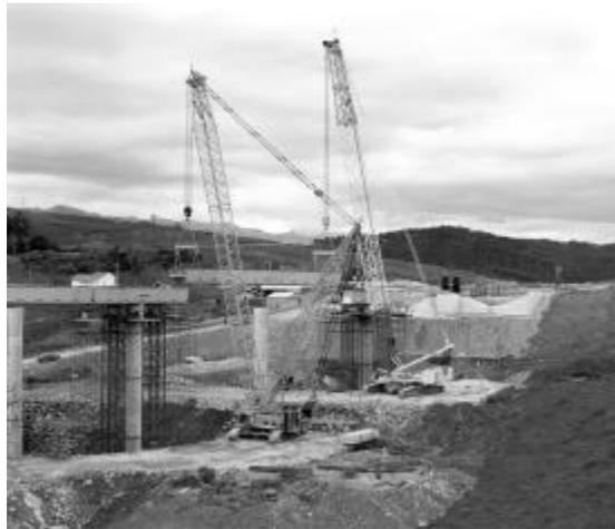
La junta entre vigas fue aproximadamente de 10 cm lo que exigió una gran precisión en la colocación de éstas. Su posición definitiva se consiguió roscando las tuercas que regulan la posición en altura de estos perfiles metálicos (pescantes) hasta que se lograba una perfecta alineación de las huellas de la rótula.
