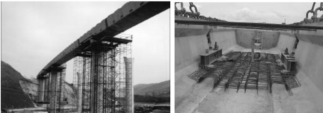
Para completar la anchura total del tablero, se disponen células transversales prefabricadas, de 5,55 m de voladizo y 2,48 m de anchura, aligeradas. Sobre la viga central se coloca una losa prefabricada, de 0,07 m de espesor, que permite situar la armadura pasiva y el hormigón que solidariza el conjunto. Las células, llevan en su parte inferior dos resaltes semicilíndricos que se alojan en los correspondientes negativos, existentes en las vigas.
