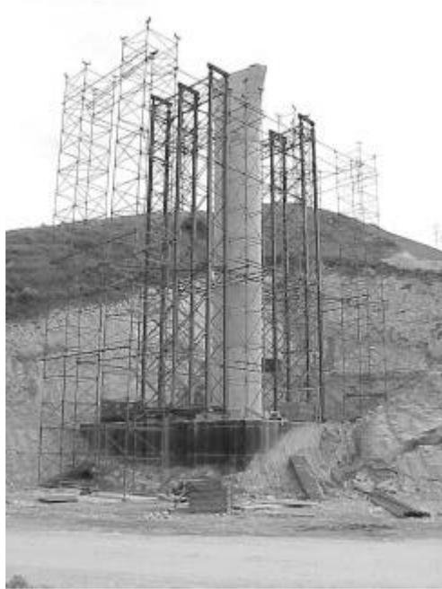
En cabeza, se han dispuesto dos apoyos de neopreno de 900 mm de diámetro y la cimentación está constituida por zapatas rectangulares de 9,00 x 8,50 m y 2,20 m de espesor, apoyando directamente en el terreno.
