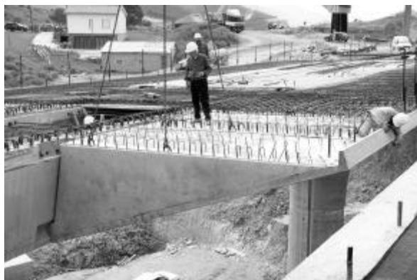
Una vez colocadas las células transversales y las placas de encofrado perdido correspondiente a la zona de momento negativo, se procedió a la colocación de ferralla, así
