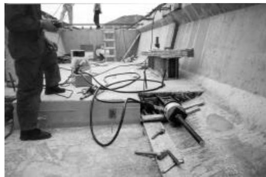
Una vez realizadas las juntas de continuidad y la inyección de mortero de alta resistencia se procedió al desapeo de la estructura, para ello, simplemente se bajaron los gatos
