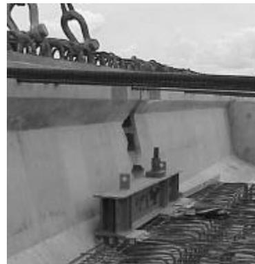
Terminada la colocación de las vigas de vano y con la aprobación del control de topografía se procedió a realizar las juntas de continuidad e inyección de mortero de alta resistencia entre neoprenos y vigas de pila.
