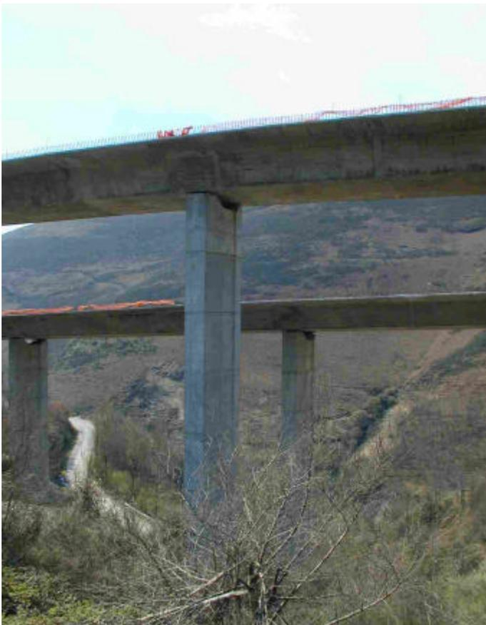
El esquema de pretensado es el correspondiente a puentes continuos construidos por el método de vanos sucesivos, interrumpiéndose en cada frente de fase. En la zona del frente de cada fase se produce el cruce de los tendones de dicha fase, que se anclan en el propio frente de fase, con los de la fase consecutiva, que se anclan en una cuña situada en la cara interior del alma.
