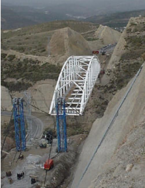
Terminado un avance de 8,66m, es decir cuando el nudo con el patín de deslizamiento llegaba al estribo, se disponía un segundo patín bajo el nudo siguiente, para mediante los cables de tiro traspasar la reacción a este segundo patín, retirar el primero y proceder a un nuevo ciclo de avance de 8,66m.
