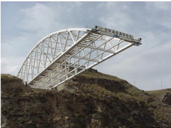
Accionamiento, abriendo émbolo, de los gatos en los cables de retenida en cola para producir el desplazamiento horizontal. Esta operación producía además un descenso del frente de avance variable según la posición.
