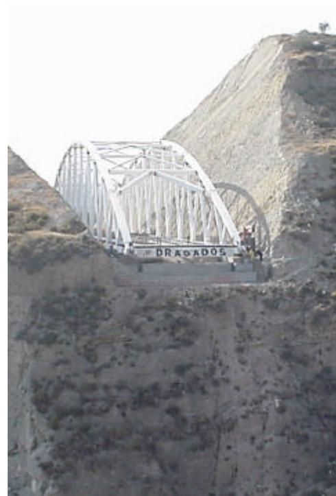
Con el fin de aproximar el frente de tiro al estribo de llegada, y así aumentar el ángulo de inclinación de los cables de tiro y reducir la altura de la torre, con la consiguiente disminución de las cargas de operación, se efectuó un empuje tradicional de la estructura
