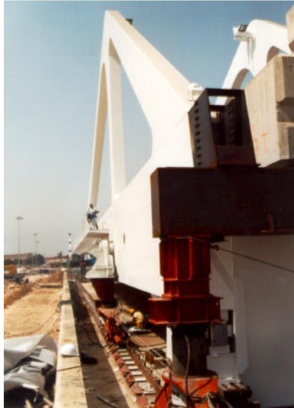
Al estar el centro de gravedad de la totalidad de estructura metálica más contrapeso definitivo en el eje de giro, donde apoyan los patines delanteros, se dispone sobre la parte trasera del tablero un contrapeso provisional de 90 t.
