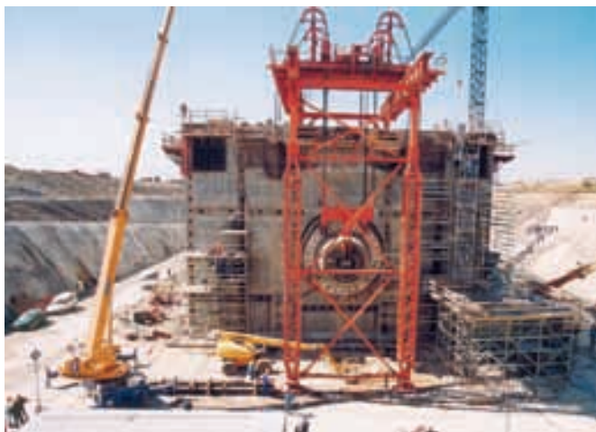
Figura 6.2.5. Rótula. Izado del resto de elementos.
