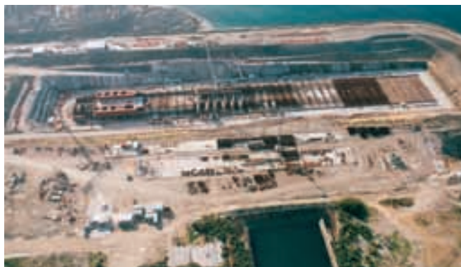
Figura 6.2.2. Parques de ferralla.
