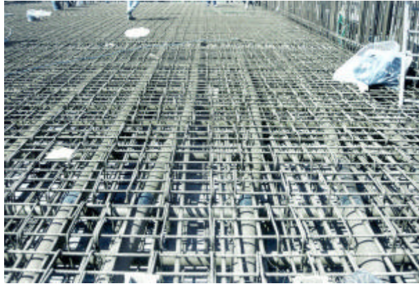
Ilustración 6 Vista de tendones longitudinales.
