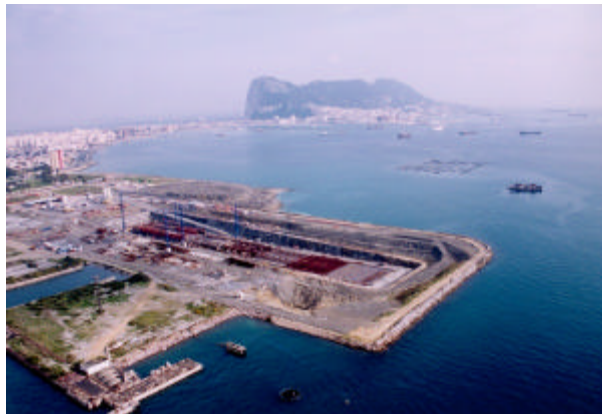
Ilustración 1 Emplazamiento de las obras de prefabricación del dique semiflotante.
