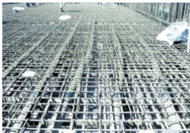
Figura 4.2. Vaina formada por tubos rígidos de acero.
