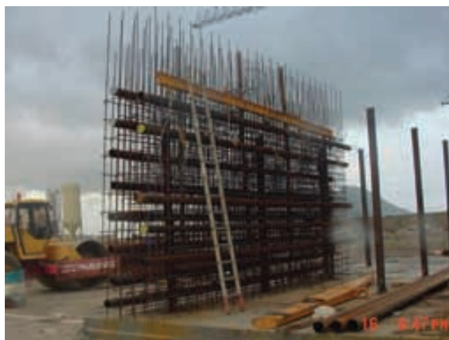
Figura 5.4.4. Prefabricación de cajas de armadura y tubos.
