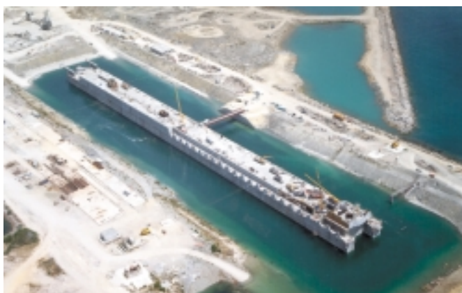
Figura 7.4.1 Dique en proceso de flotación.
