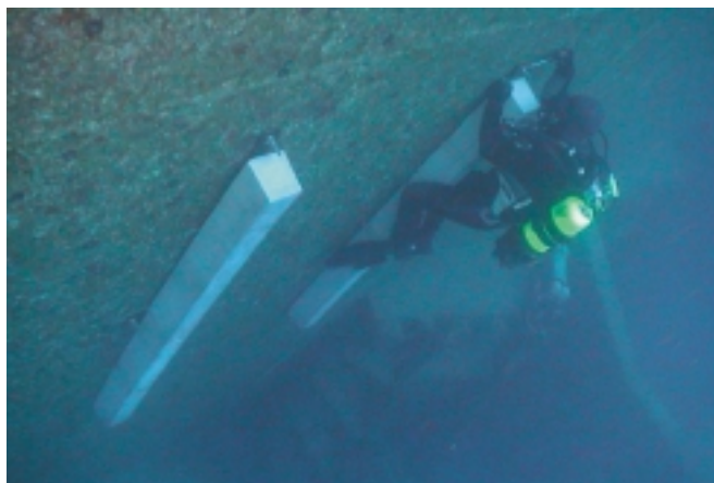
Figura 7.6.3. Instalación de los ánodos de sacrificio.
