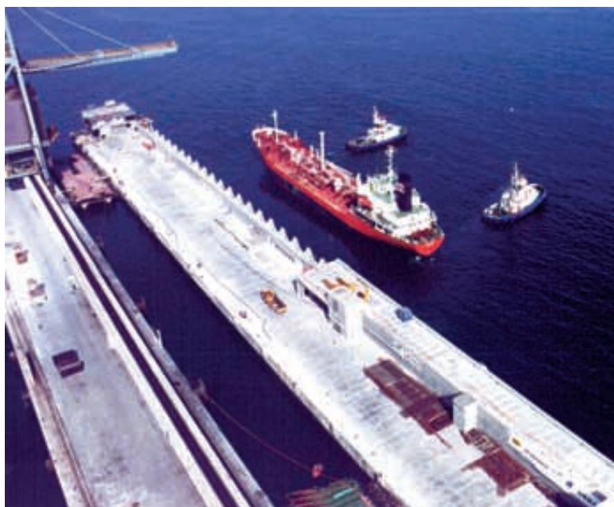
Figura 5.3.2. Lastrado con barco tanque en Algeciras.
