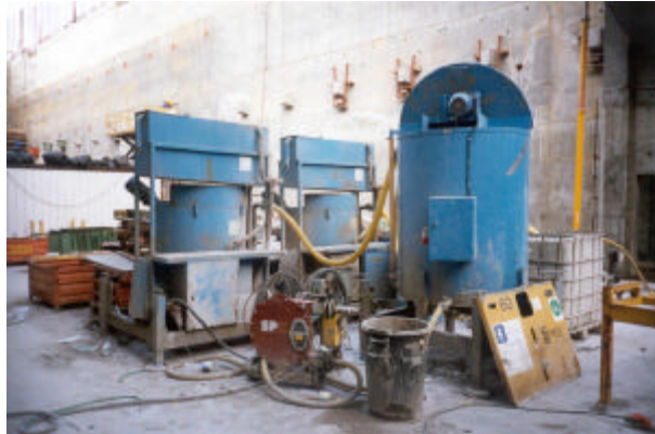
Ilustración 19 Equipo para la inyección de tendones longitudinales.
