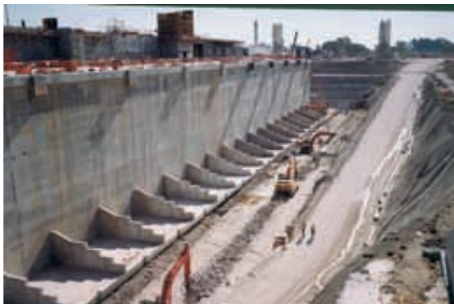
Figura 6.4.13. Retirada de instalaciones.
