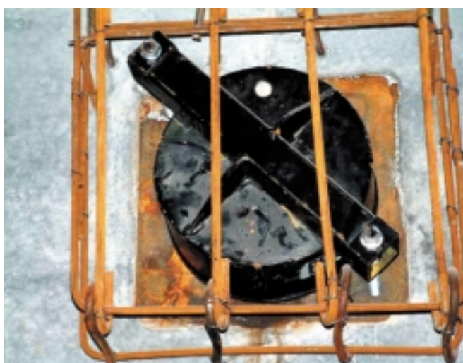
Figura 4.12. Anclaje preparado para el sellado.
