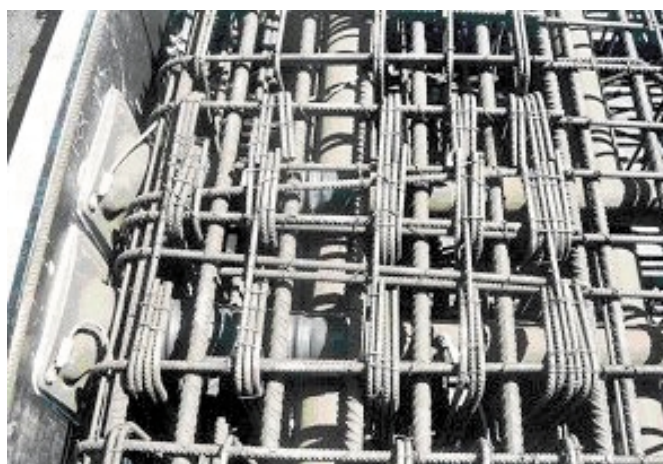
Figura 4.7. Anclajes BBR CONA Compact instalados.
