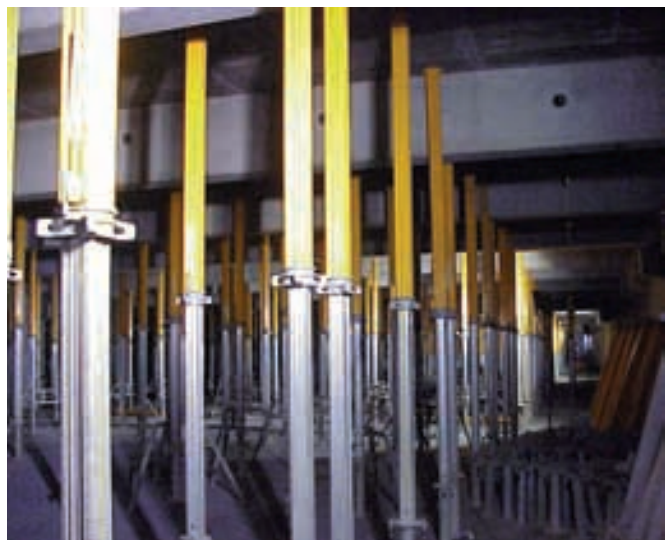
Figura 6.5.4. Apuntalamiento losa +3.
