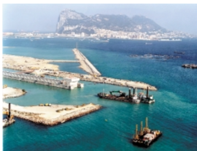
Figura 7.3.7. Dragage Razende Bol y equipo de perforación.
