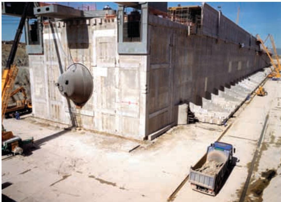
Figura 5.1.10. Protección de la rótula para el transporte.
