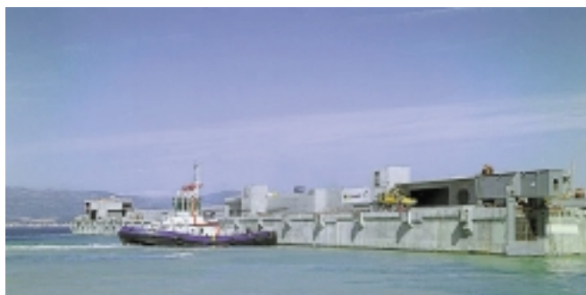
Figura 7.4.5. Maniobra de los remolcadores.
