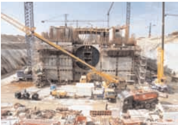
Figura 6.4.7. Hormigonado de la rótula.
