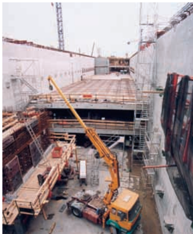
Figura 6.5.3. Encofrado de losas.
