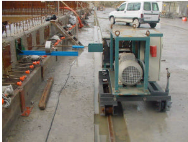
Ilustración 9 Enfiladora sobre carro de traslación.
