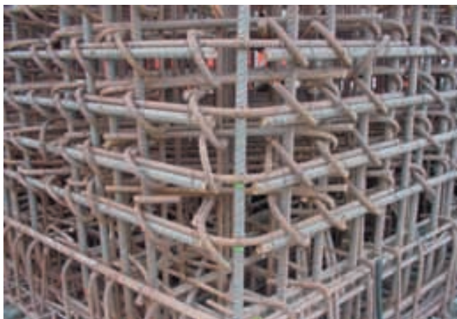
Figura 6.5.1. Disposición de las armaduras.
