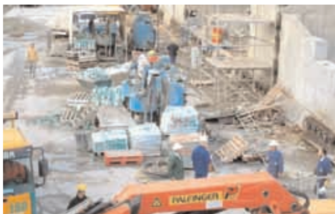
Figura 6.6.3.4. Equipos inyección cables longitudinales
