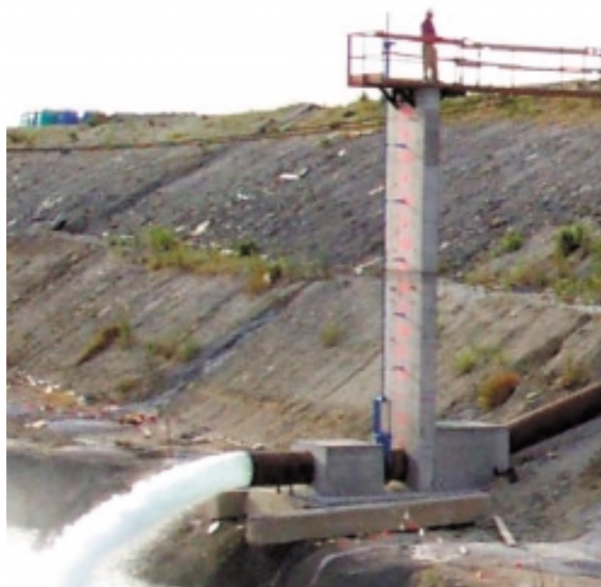
Figura 7.2.4. Sifón llenando la dársena.
