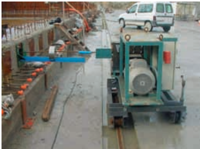
Figura 6.6.3.1. Enfiladora sobre carro de traslación.
