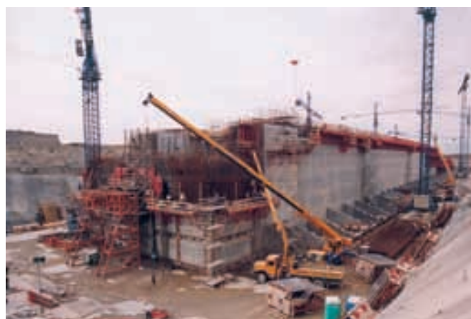
Figura 6.5.8. Ferralla y encofrado zona rótula.
