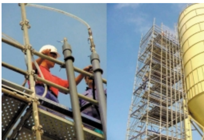
Figura 4.6. Ensayos tubo vertical.
