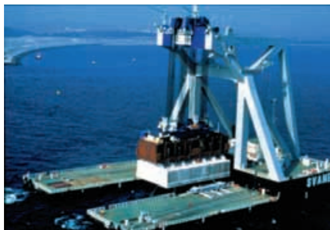
Figura .9.6. Grandes cajones para cimentación de puentes.
