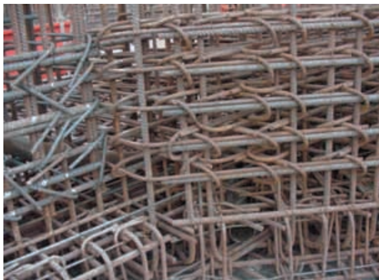
Figura 5.4.2. Horquillas y cercos de armado transversal.
