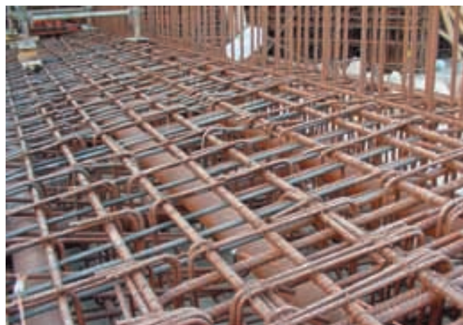
Figura 5.4.5. Vigas prefabricadas con sus tubos de pretensado.
