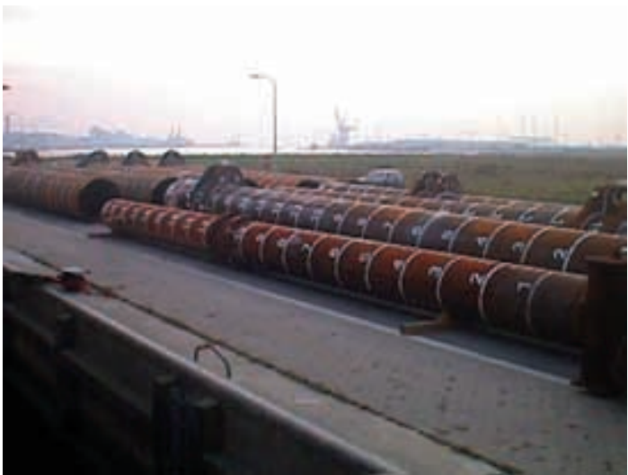
Figura 5.2.3. Vista del acopio de los pilotes metálicos para anclaje.
