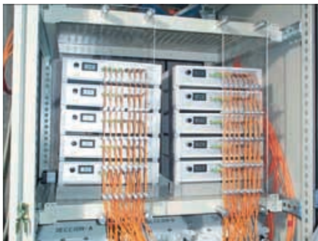
Figura 5.7.4. Unidades optoelectrónicas Opto-Box . A la derecha pueden verse las 10 unidades utilizadas, dispuestas en el armario de centralización de medidas y con los sensores conectados.
