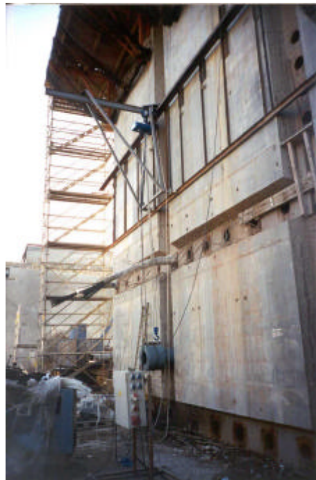
Ilustración 12 Utillaje para manipulación de gatos de tesado de tendones.
