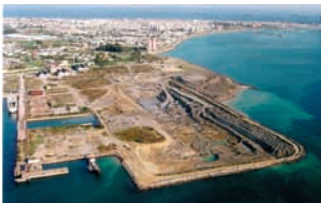
Figura 6.1.3. Excavación de la dársena.
