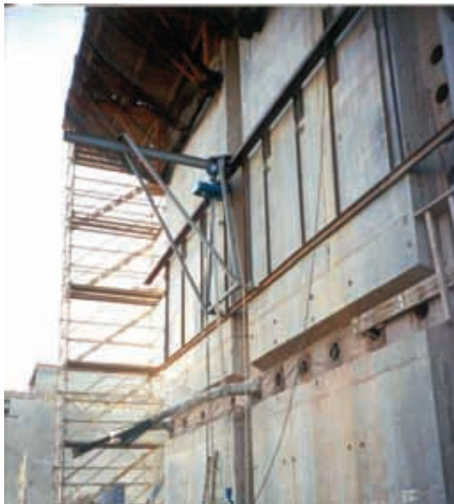
Figura 6.6.3.2. Utillaje para manipulación de gatos de tesado.
