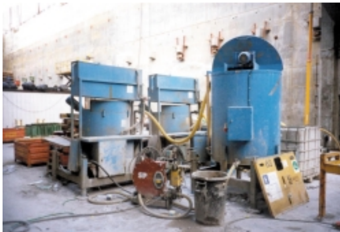
Figura 4.10. Equipo de inyección.
