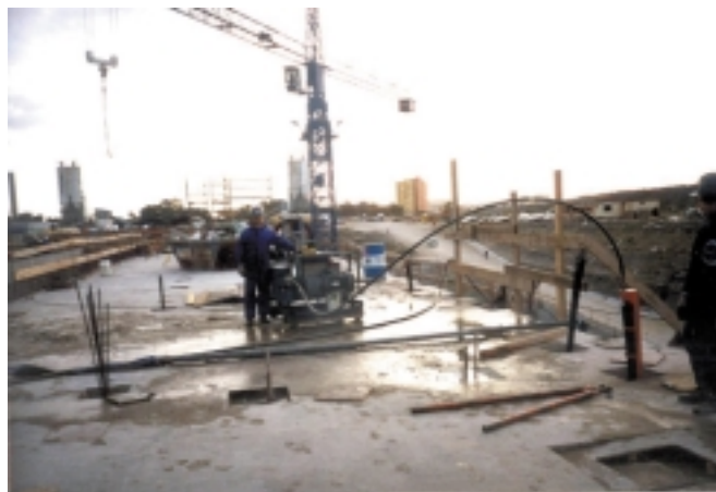
Figura 4.8. Enfilado cordón a cordón en bucles verticales.
