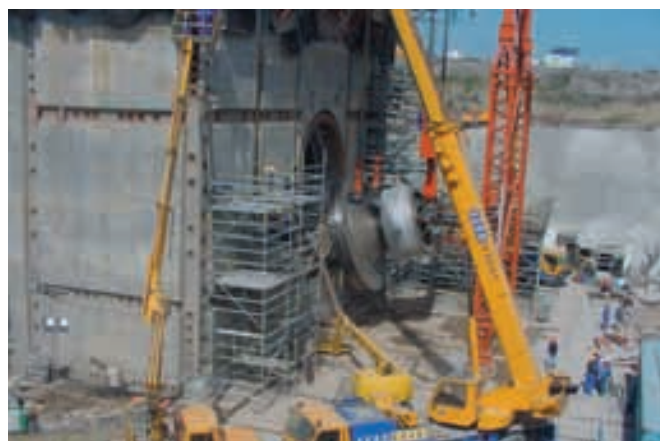
Figura 6.4.8. Montaje de la rótula.
