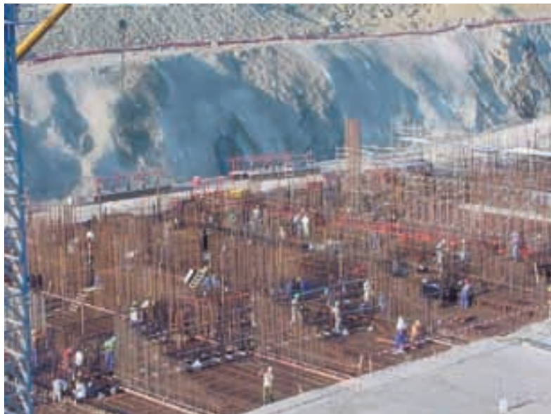
Figura 5.4.1. Aspecto general de los trabajos de armado.
