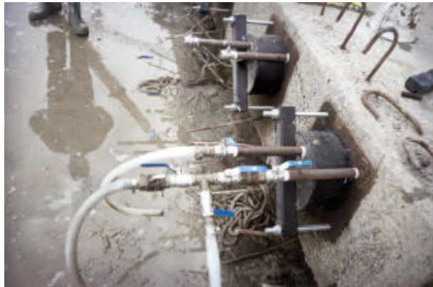
Ilustración 17 Anclaje preparado para la inyección al vacío.
