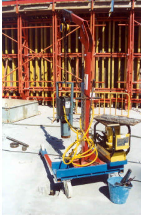
Ilustración 13 Utillaje para manipulación de gatos de tesado de barras.
