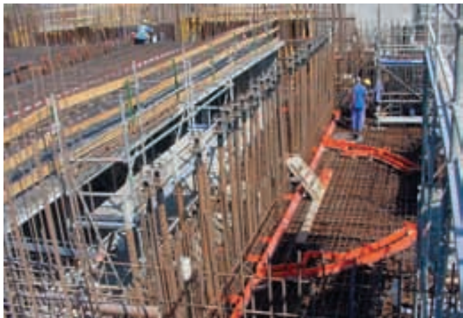
Figura 5.4.6. Pretensados en tres direcciones.
