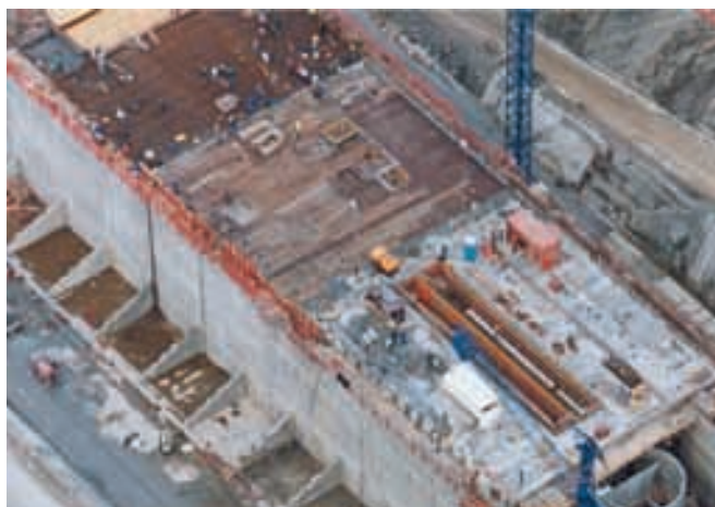
Figura 6.5.5. Curado con arpillerita y agua.
