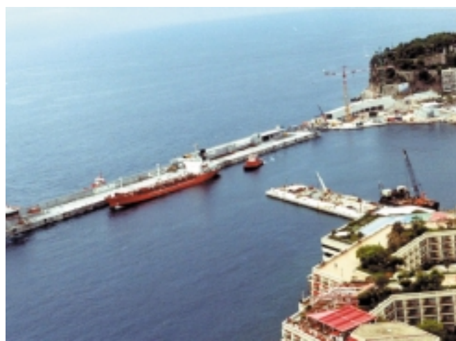
Figura 7.5.11. Lastrado del dique en Mónaco antes de la conexión.
