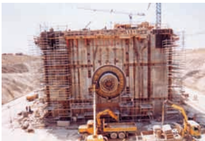
Figura 6.4.10. Sellado de anclajes de postesado.
