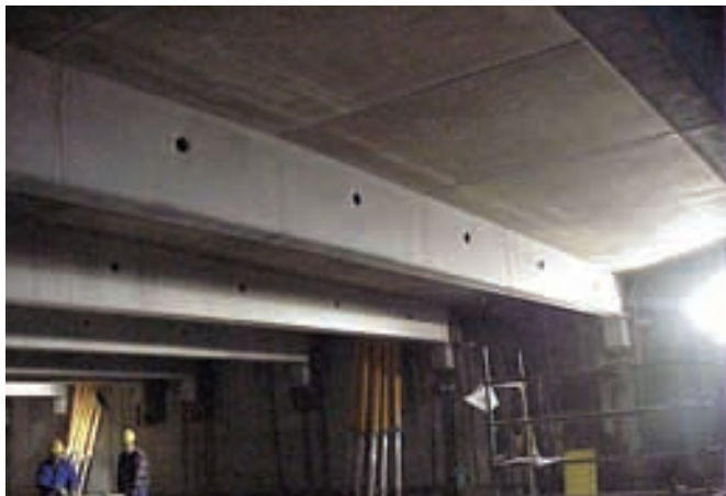
Figura 6.4.9. Vigas y prelosas prefabricadas.
