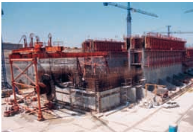
Figura 6.2.3. Rótula. Izado de elementos embebidos.
