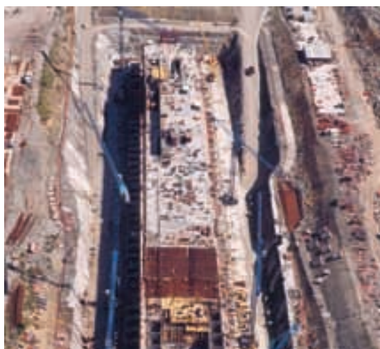
Figura 6.4.4. Evolución de los trabajos.
