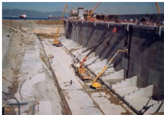
Figura 6.4.11. Inspección de paramentos.
