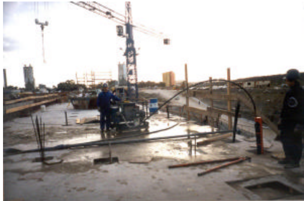
Ilustración 10 Enfilado cordón a cordón en bucles verticales.
