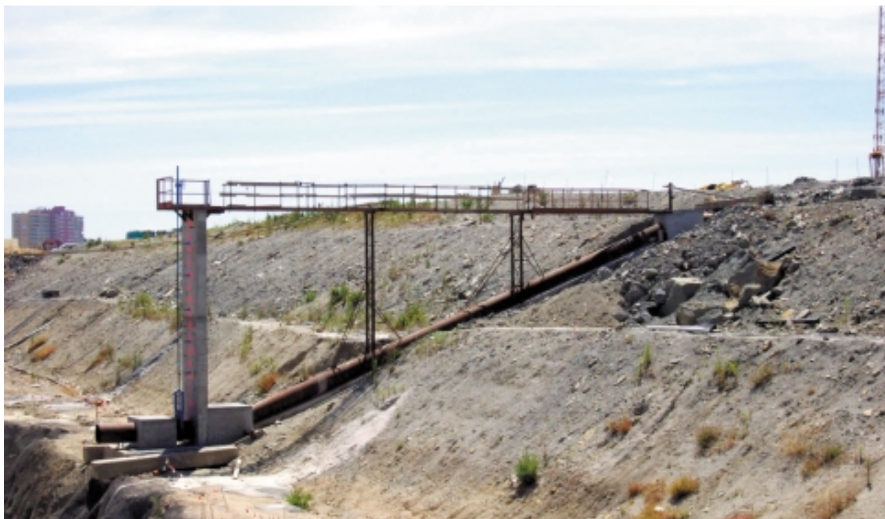
Figura 7.2.2 Sifón de llenado de la dársena.
