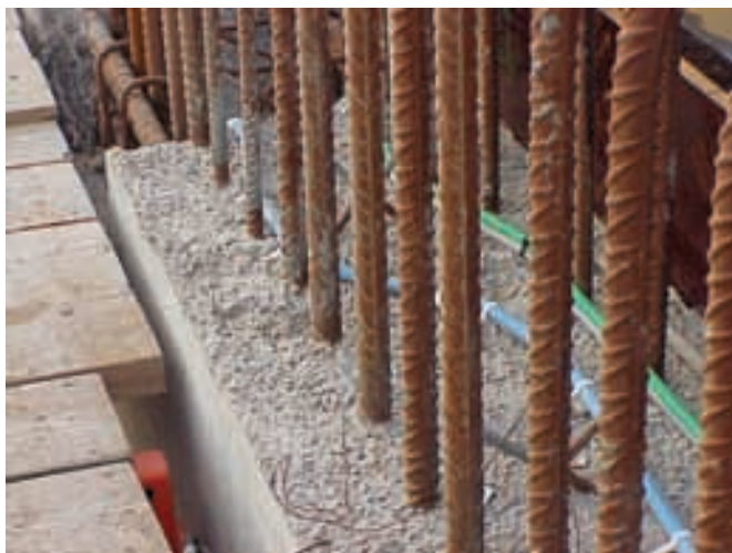
Figura 6.5.7. Junta de hormigonado.
