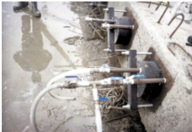
Figura 4.11. Anclaje preparado para la inyección al vacío.
