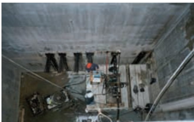
Figura 6.6.3.3 Enfilado tendones longitudinales 250 m
