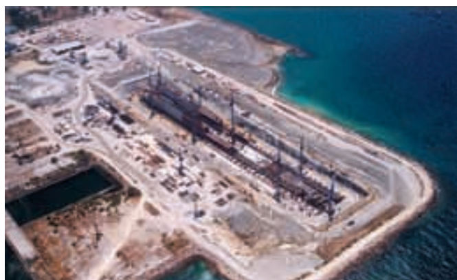
Figura 6.2.7. Vista general de las instalaciones.
