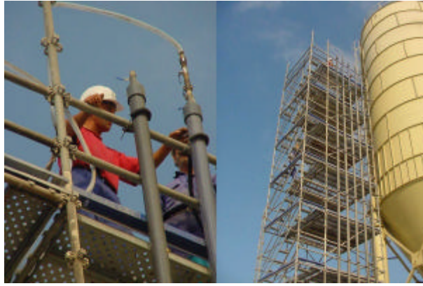
Ilustración 14 Ensayos de inyección de tubo vertical de 17 m.
