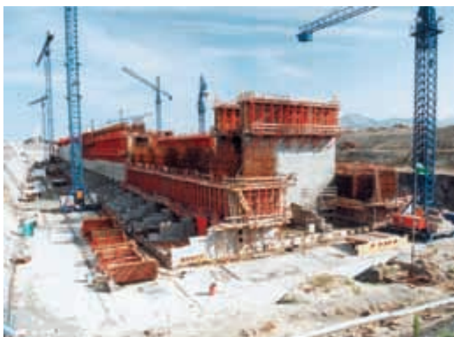
Figura 6.5.2. Encofrado trepante para los muros.
