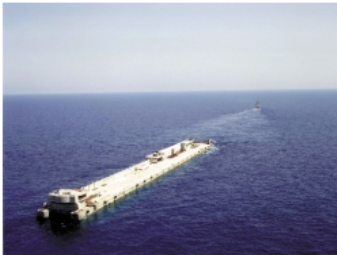
Figura 7.4.16. Transporte del dique.
