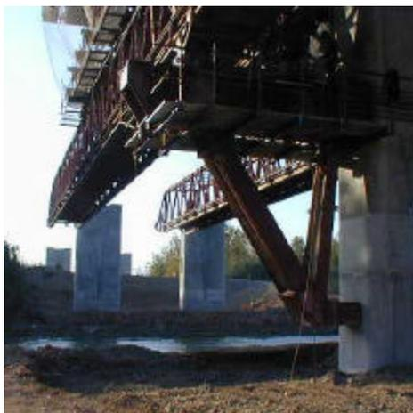
tiene una cierta rigidez, por lo que toma parte de la carga de la losa superior, lo que obliga a realizar un tesado provisional de dos cables del pretensado parabólico para anular o disminuir las tracciones que se producen en este estado.
