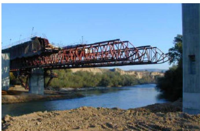
El tablero se ejecuta mediante avance por vanos sucesivos, con cimbra de avance independiente del terreno, que se apoya durante el hormigonado, en el voladizo del vano anterior y en la pila correspondiente.
