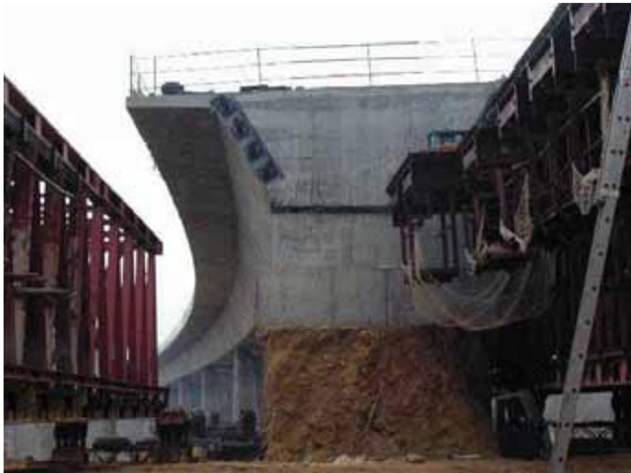
Posteriormente, se demuelen los capiteles provisionales mencionados, se recrecen los pilotes correspondientes, y se finaliza la construcción del encepado y alzado del estribo 1.
