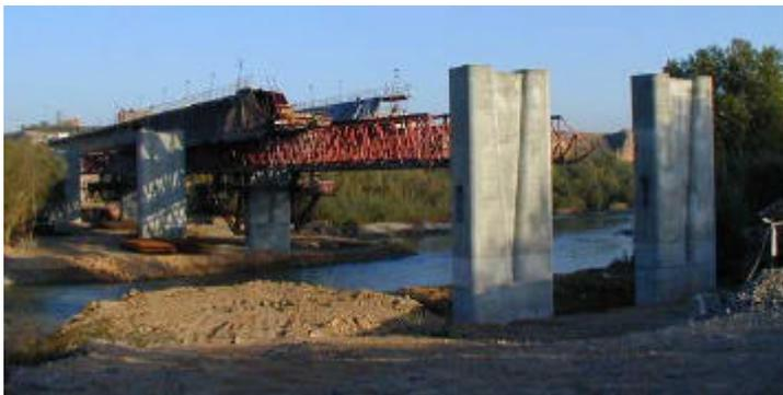
radio, en el que se hace un rebaje triangular de 40 centímetros de profundidad en cada cara de 5 metros de anchura, que tiene una altura de 10,30 metros, coronándose 20 centímetros por debajo de las zonas laterales de 2
