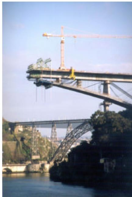
**Fig. 7: Doblecarro y triangulación en celosía**
