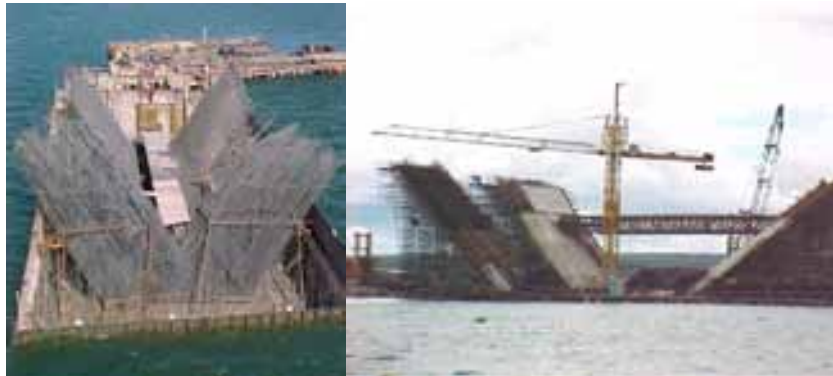
Figura 6. Ejecución de arranque de arcos, pilas y dinteles.
