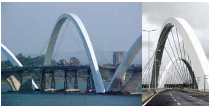
Figura 9. Montaje y puesta en carga de tirantes.
