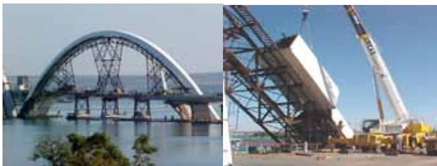
Figura 8. Montaje de arcos metálicos.
