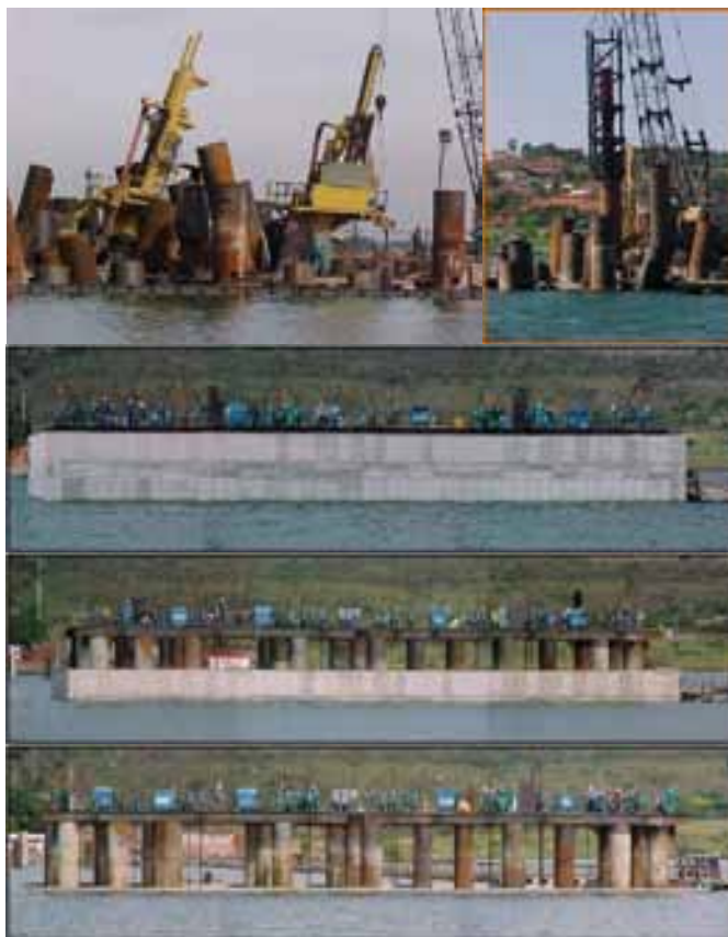
Figura 5. Diferentes fases de la ejecución de los pilotes y encepados.
