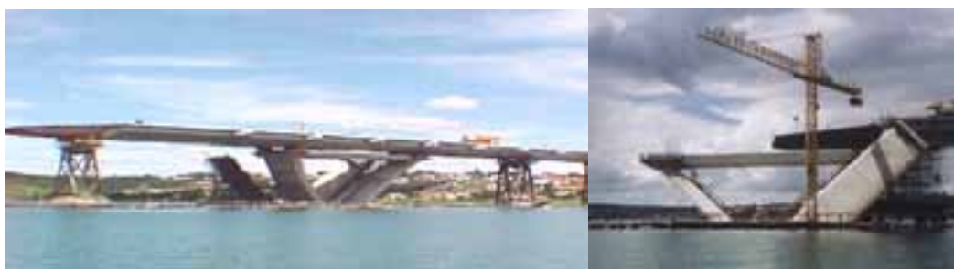
Figura 7. Empuje de tableros.
