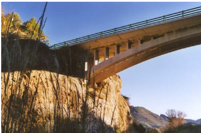
Figura 5 Puente sobre el río Segura en Elche de la Sierra después de la intervención (Fotografía: Paco Gómez)
