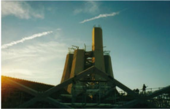
El montaje de las dovelas y resto de estructura interior (losas, escaleras y vigas) se llevó a cabo mediante una grúa LIEBHERR LG-1550 de 550 Tn de capacidad que manejaba la pieza más pesada (43 Tn) con un radio de 45 m, con la precisión requerida. La principal
