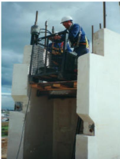
dificultando el encuentro con el extremo de las barras de la dovela inferior. Sin embargo, tras unos ensayos en fábrica, previamente a la fabricación de las dovelas, se consiguió el procedimiento apropiado para realizar los empalmes sin excesivos problemas, llegándose a montar 3 dovelas en un mismo día.
